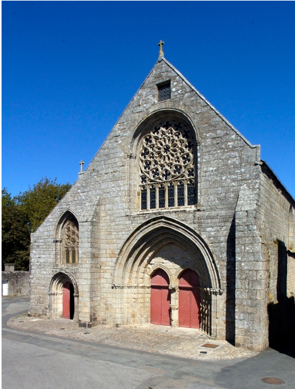
Vue rapprochée de la façade ouest
