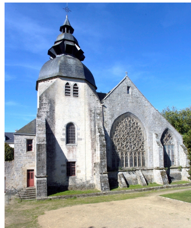
Vue générale du chevet Phot. Norbert Lambart IVR53_20072900197NUCA
