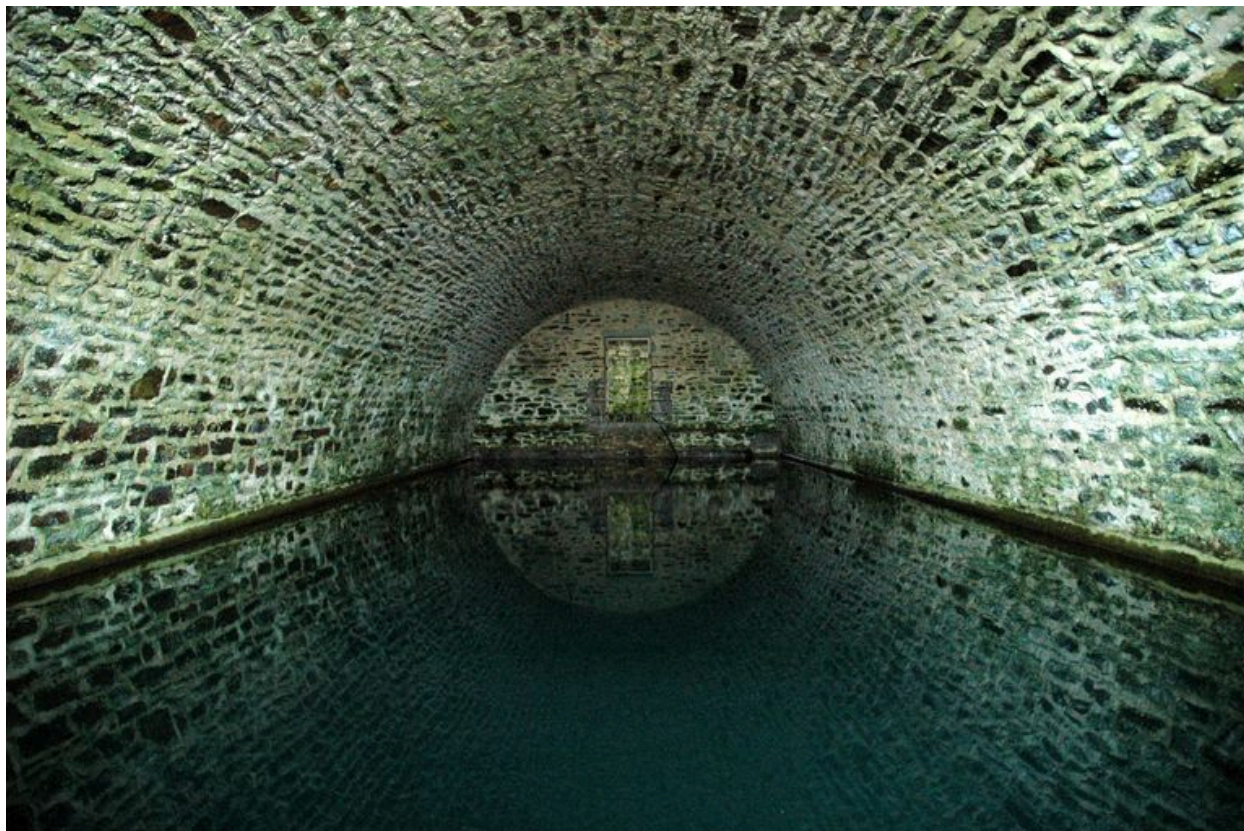
Vue de l'aiguade de la Belle-Fontaine : intérieur
