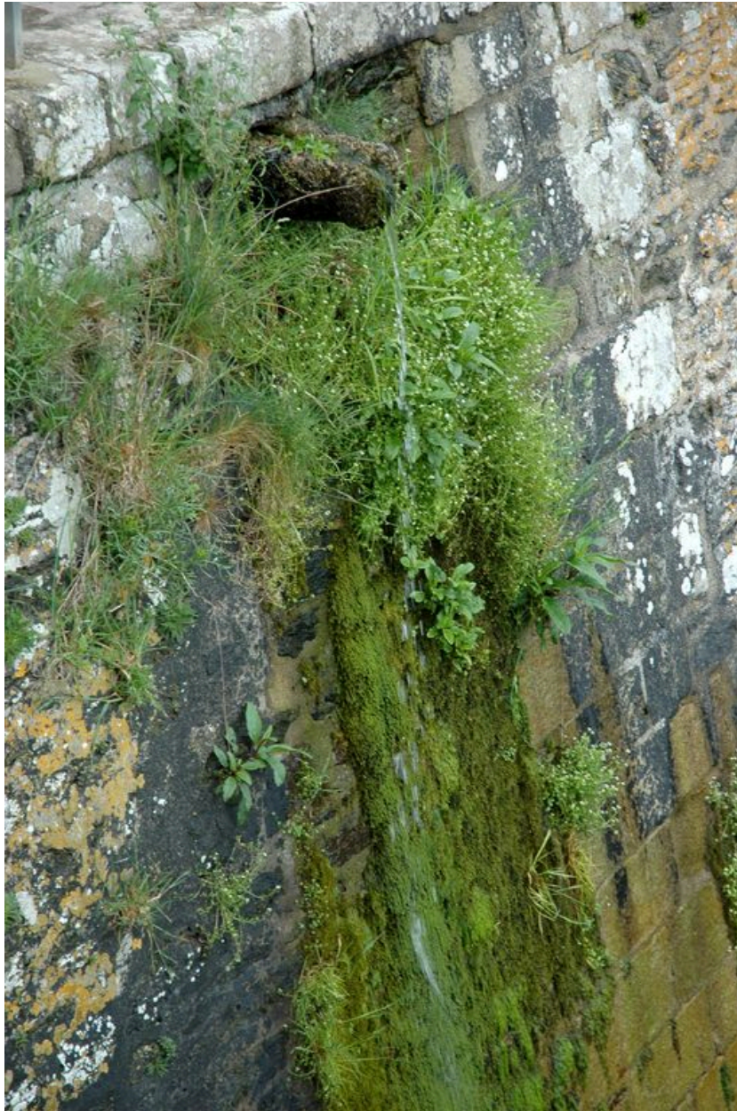
Vue de l'aiguade de la Belle-Fontaine : détail du trop plein, la gargouille
