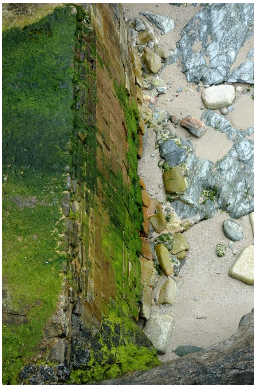
Vue de l'aiguade de la Belle-Fontaine : détail de l'escarpe
