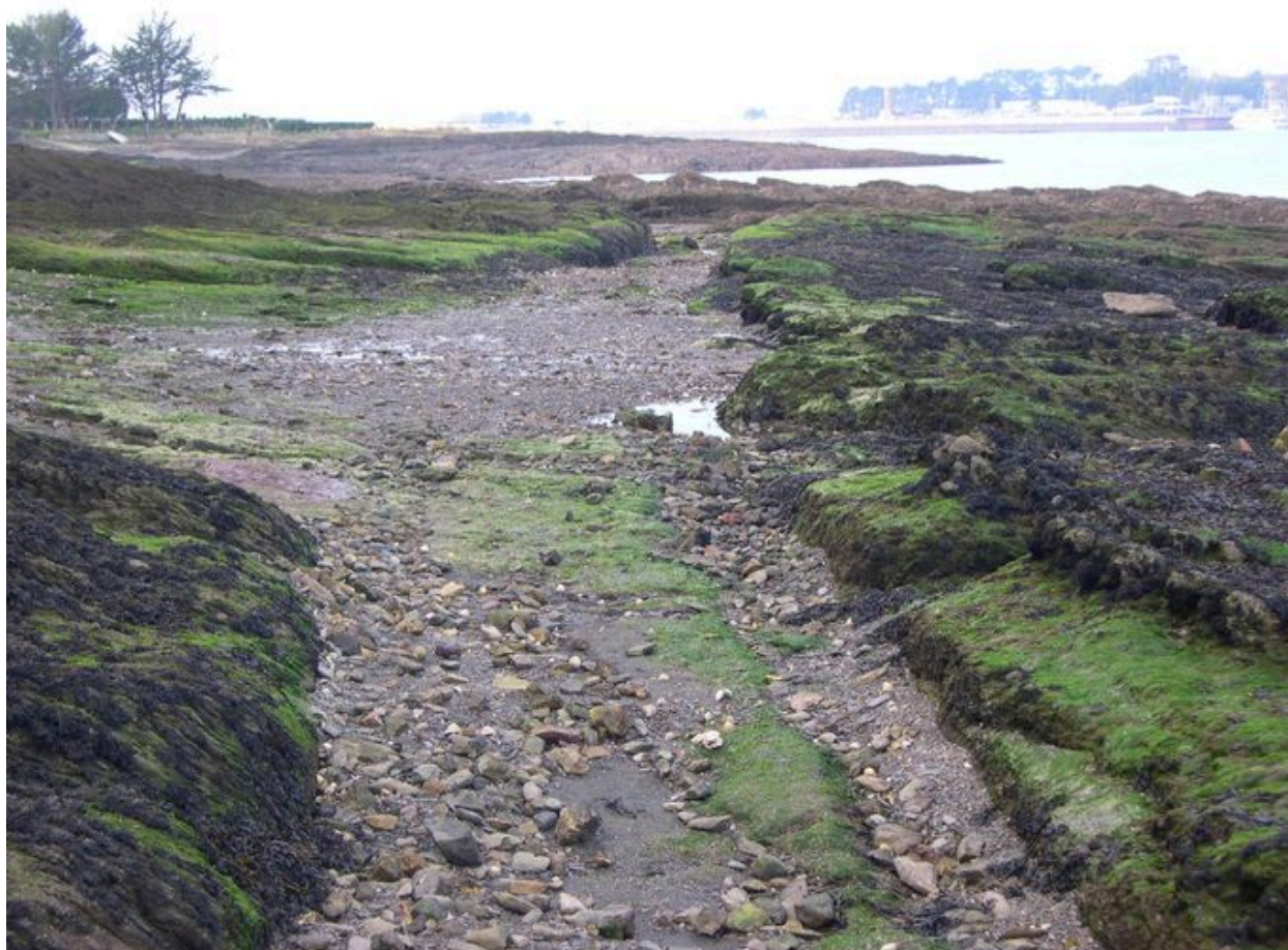
Vue générale de la chaussée sur l'estran au Zorn
