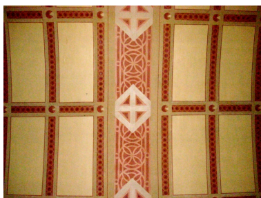
Morlaix, église paroissiale Saint-Mathieu : lambris de couvrement de la nef, détail Phot. Gwénaél Fauchille IVR53_20082906620NUCA
