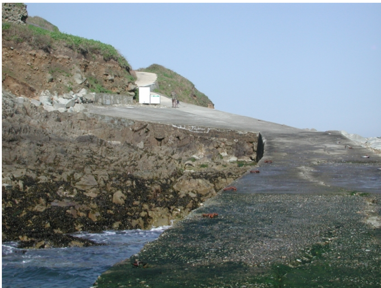
Vue de la forme du quai sud
