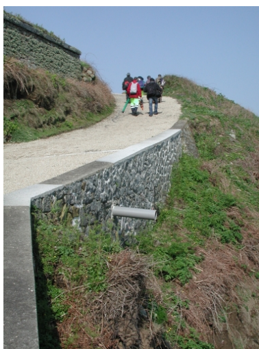
Le mur de quai refait avec barbacane moderne Phot. Guy Prigent IVR53_20072205658NUCA
