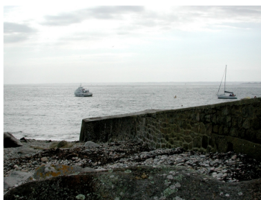
Vue du mur du quai côté est : revêtement en moellons de granite Phot. Guy Prigent IVR53_20062208676NUCA
