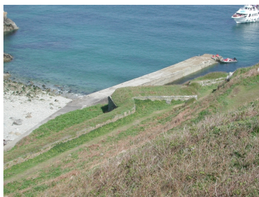
Vue en plongée du quai et des murs de retranchement Phot. Guy Prigent IVR53_20062208675NUCA
