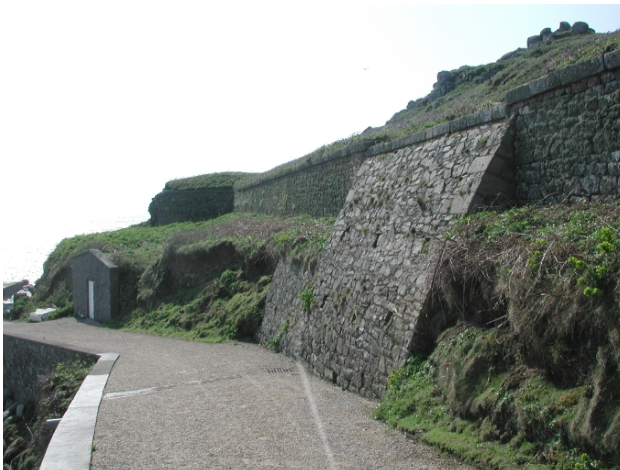
Le sentier élargi et entouré de murs de soutènement et de défense
