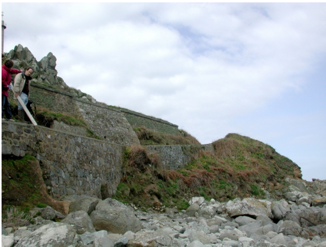
Vue du mur de soutènement du quai en amont : moellons de granite et pierres sèches
