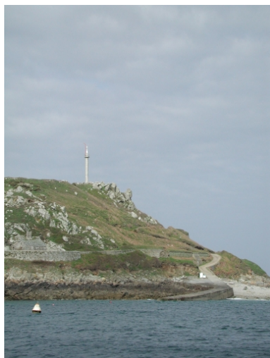
Vue générale du quai ou cale sud Phot. Guy Prigent IVR53_20062208674NUCA
