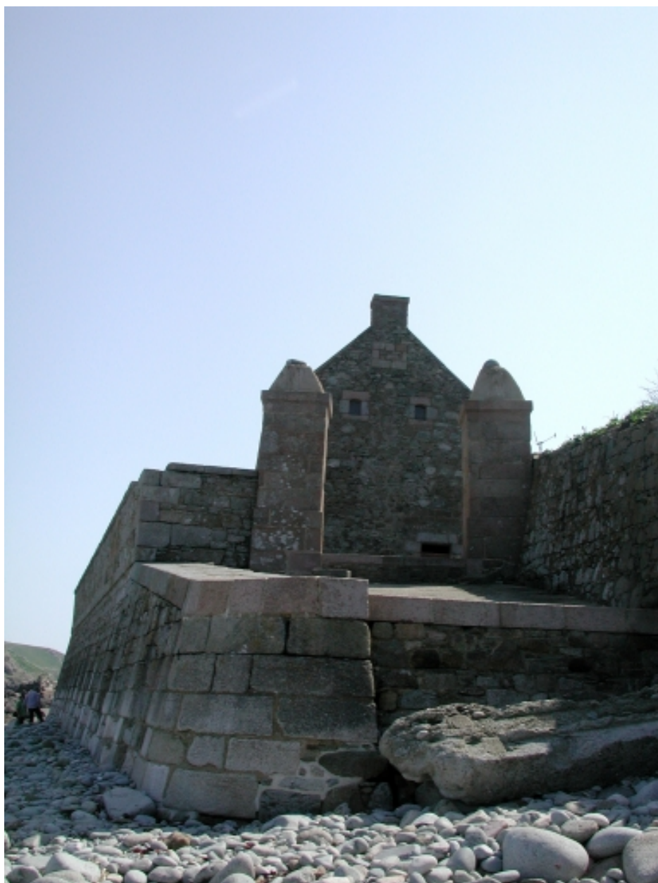
Vue de la cale sud de la caserne avec ses murs de soutènement
