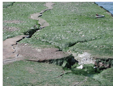
Vue de la partie supérieure de la cale sud lésardée à son extrémité Phot. Guy Prigent IVR53_20072205657NUCA
