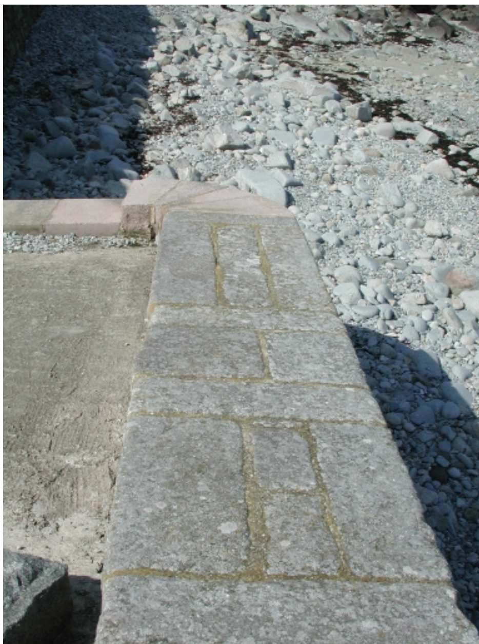
Le mur de soutènement de la cale nord en pierres de taille
