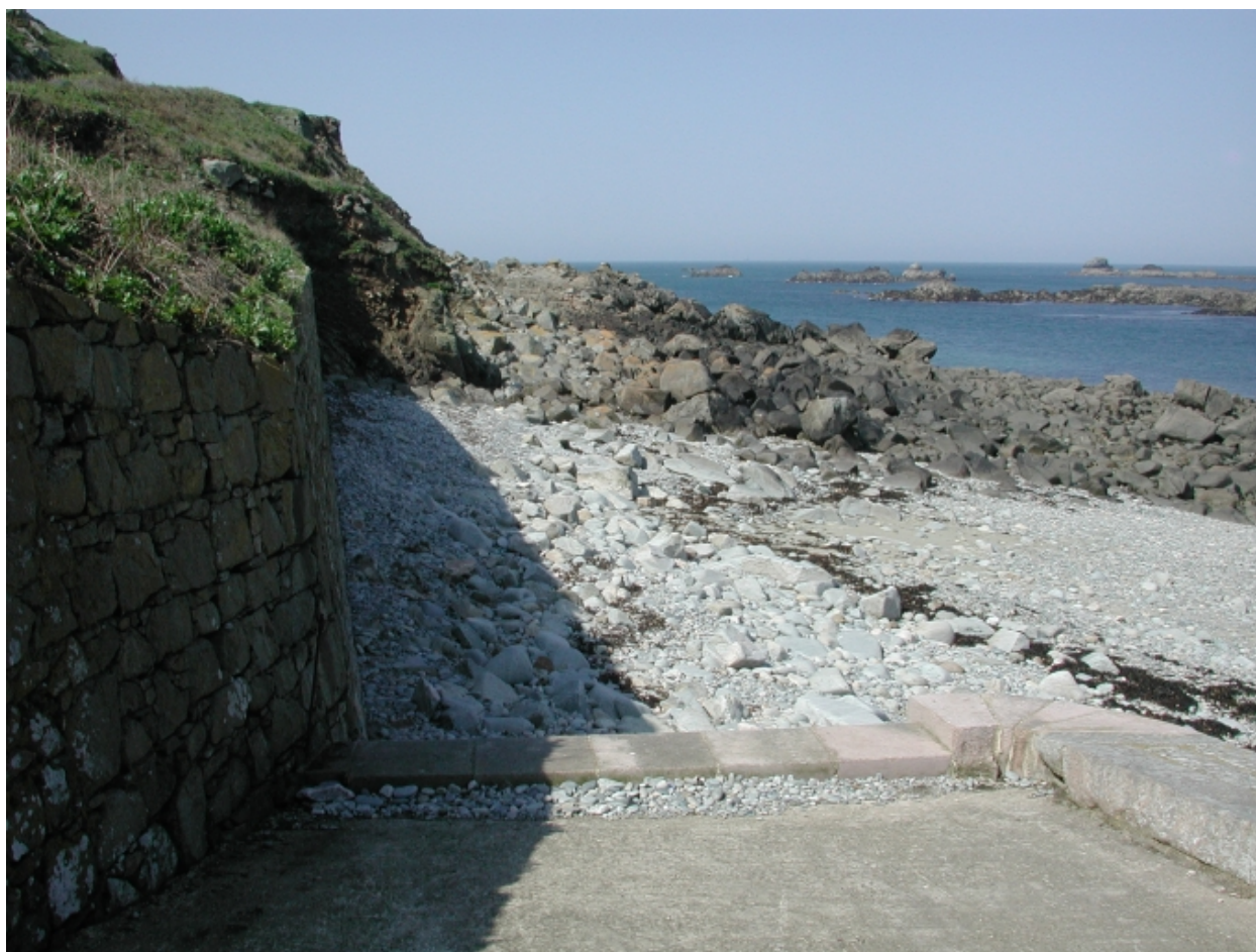
La cale du mouillage nord (orientée ouest)
