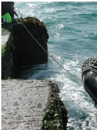
Vue de la partie supérieure de la cale sud lésardée à son extrémité Phot. Guy Prigent IVR53_20072205657NUCA
