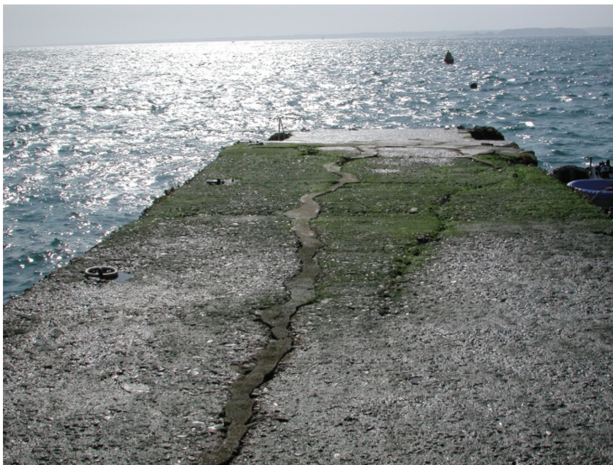
Vue de l'extrémité du quai sud
