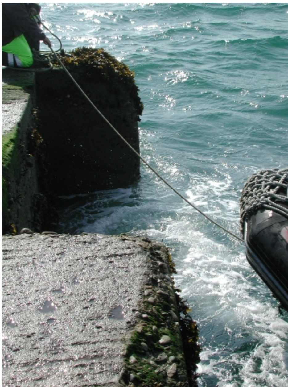
Vue de l'escalier à l'extrémité ouest du quai sud
