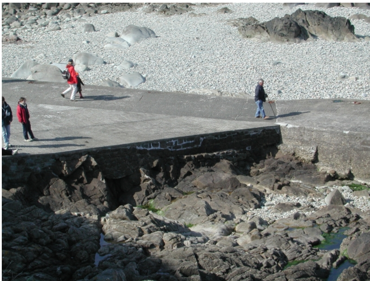
Vue de la plateforme du quai en amont : remarquer le vaigrage en ciment
