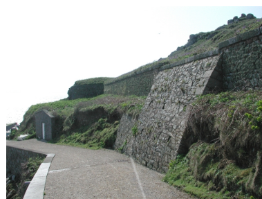
Le sentier élargi et entouré de murs de soutènement et de défense Phot. Guy Prigent IVR53_20072205660NUCA
