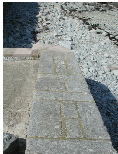
Le mur de soutènement de la cale nord en pierres de taille Phot. Guy Prigent IVR53_20072205662NUCA
