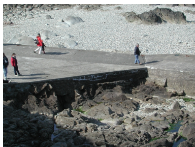
Vue de la plateforme du quai en amont : remarquer le vaigrage en ciment Phot. Guy Prigent IVR53_20062208677NUCA
