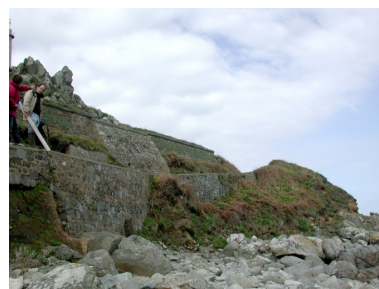
Vue du mur de soutènement du quai en amont : moellons de granite et pierres sèches Phot. Guy Prigent IVR53_20062208678NUCA
