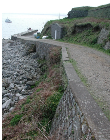
Le quai en amont : remarquer l'absence de barbacane et le fruit du mur sur 3 mètres Phot. Guy Prigent IVR53_20062208679NUCA
