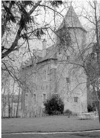
Manoir : élévation postérieure du logis (état en 1985) Phot. Norbert Lambart IVR53_19855600274X
