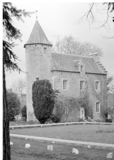
Manoir : élévation antérieure du logis vue depuis le portail d'entrée (état en 1985) Phot. Norbert Lambart IVR53_19855600272X
