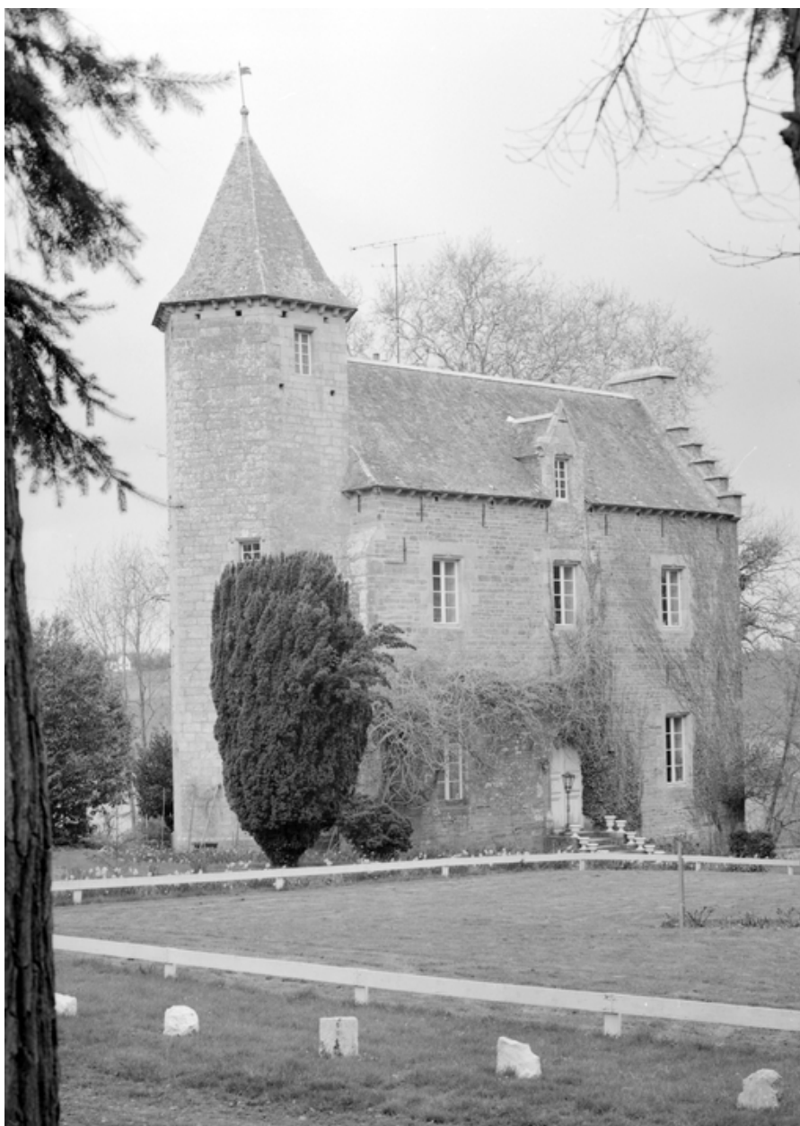
Manoir : élévation antérieure du logis vue depuis le portail d'entrée (état en 1985)
