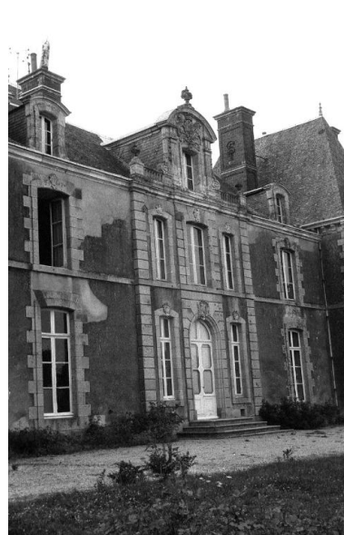
Vue générale, façade sud. Phot. Galbrun IVR53_19823501153Z
