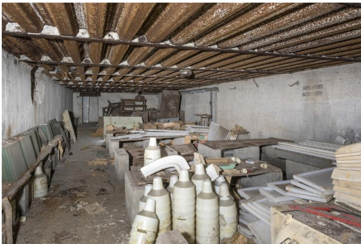
Vue de l'une des deux salles (1) : rangées de bancs en béton surmontés de leurs assises en bois. Au fond de la salle, empilement de sommiers en bois
