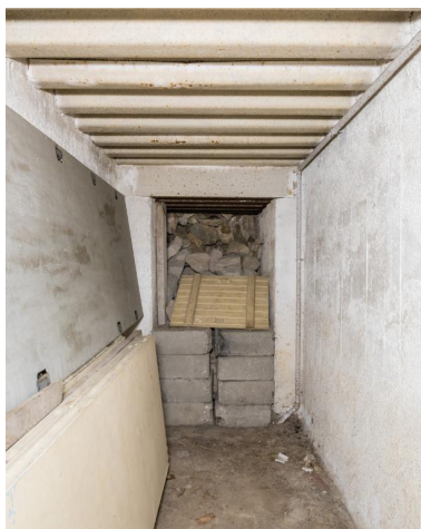
Vue de l'une des entrées du bunker : cette dernière est murée Phot. Charlotte Barraud IVR53_20235600057NUCA
