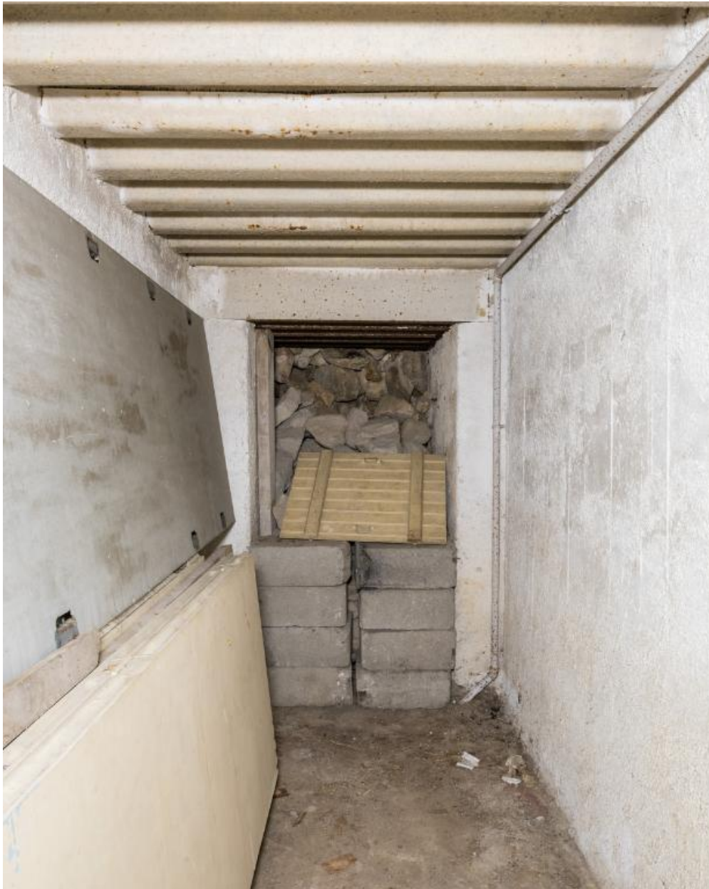
Vue de l'une des entrées du bunker : cette dernière est murée
