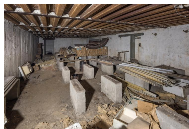
Vue de l'une des deux salles (2) : rangées de bancs en béton encore surmontés pour certains de leurs assises en bois Phot. Charlotte Barraud IVR53_20235600058NUCA
