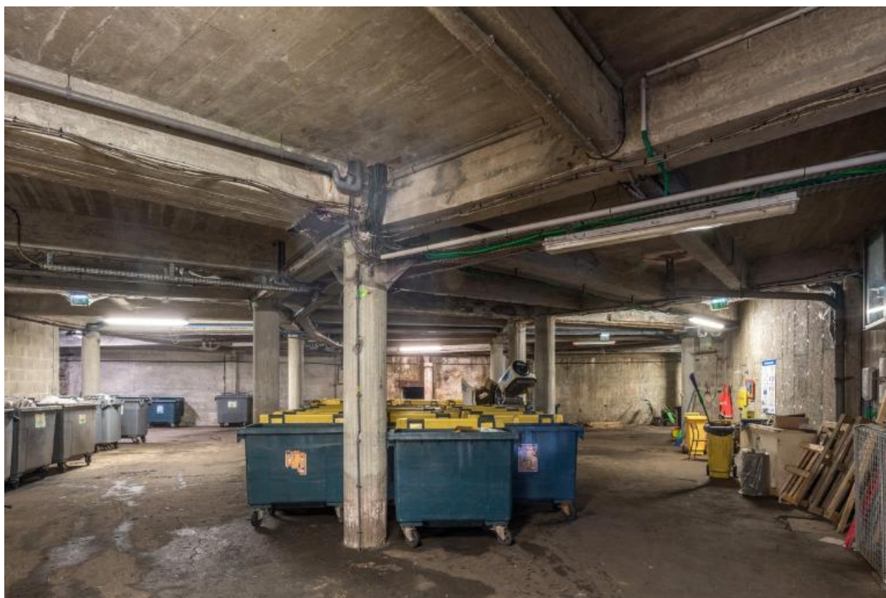
Vue du sous-sol des Halles de Merville : accès au bunker - abri
