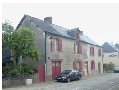
Vue générale sud-ouest du 28 rue de la Grange Phot. Xavier Gilbert IVR53_20013508533NUCA
