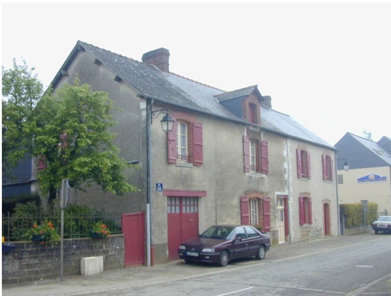
Vue générale sud-ouest du 28 rue de la Grange
