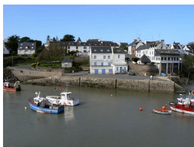
Vue générale du quai Peyron Phot. Julien Amghar IVR53_20082908562NUCA
