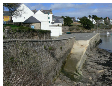
Quai Peyron et cale vus d'aval Phot. Julien Amghar IVR53_20082908563NUCA
