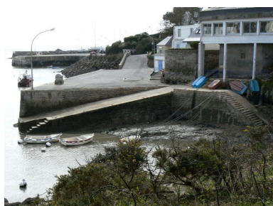
Quai Peyron et deuxième cale vus d'amont Phot. Julien Amghar IVR53_20082908564NUCA
