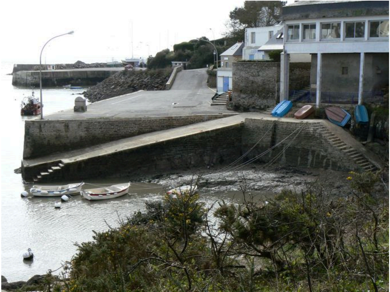
Quai Peyron et deuxième cale vus d'amont
