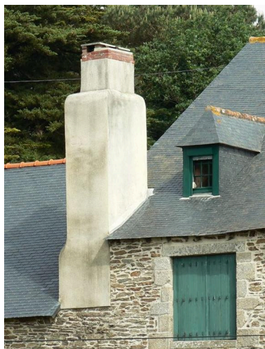
Cheminée et lucarne de l'ancienne presse de Porsac'h d'où l'on voyait arriver les bateaux Phot. Johan Vincent IVR53_20072909116NUCA
