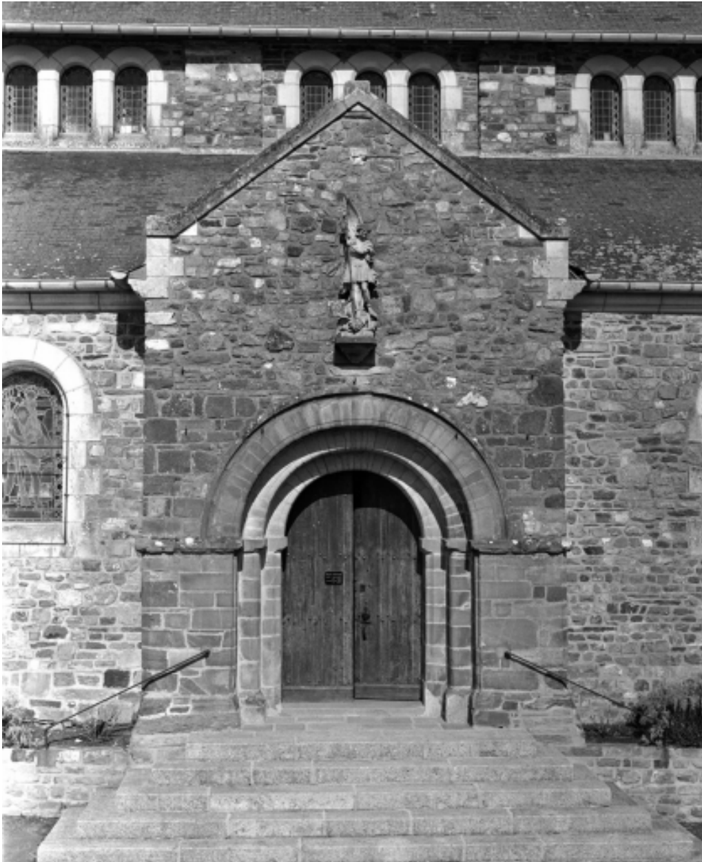
Elévation sud, porte ; vue générale
