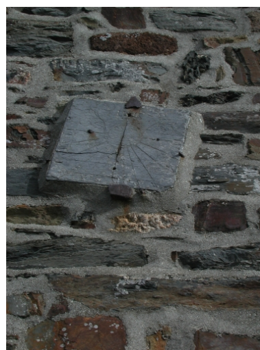
Elévation sud, transept ; un cadran solaire Phot. Claude Quillivic IVR53_20003516285NUCA
