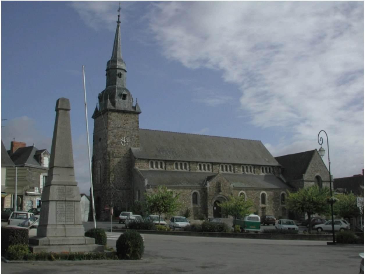
Vue de situation sud
