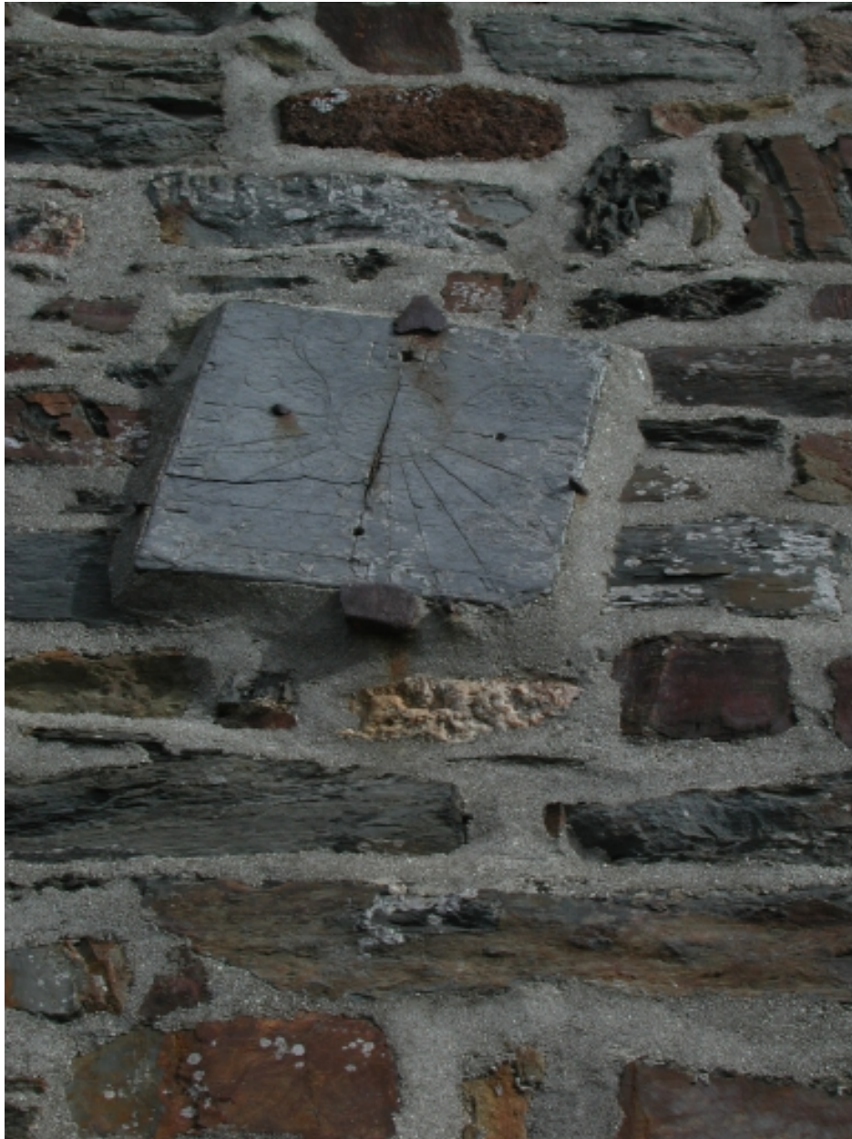
Elévation sud, transept ; un cadran solaire
