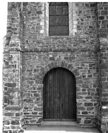
Elévation ouest, porte ; vue générale Phot. Guy Artur, Phot. Norbert Lambart IVR53_19953500076X
