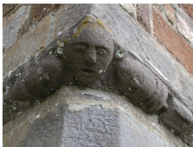
Elévation sud, porte ; détail Phot. Claude Quillivic IVR53_20003516426NUCA
