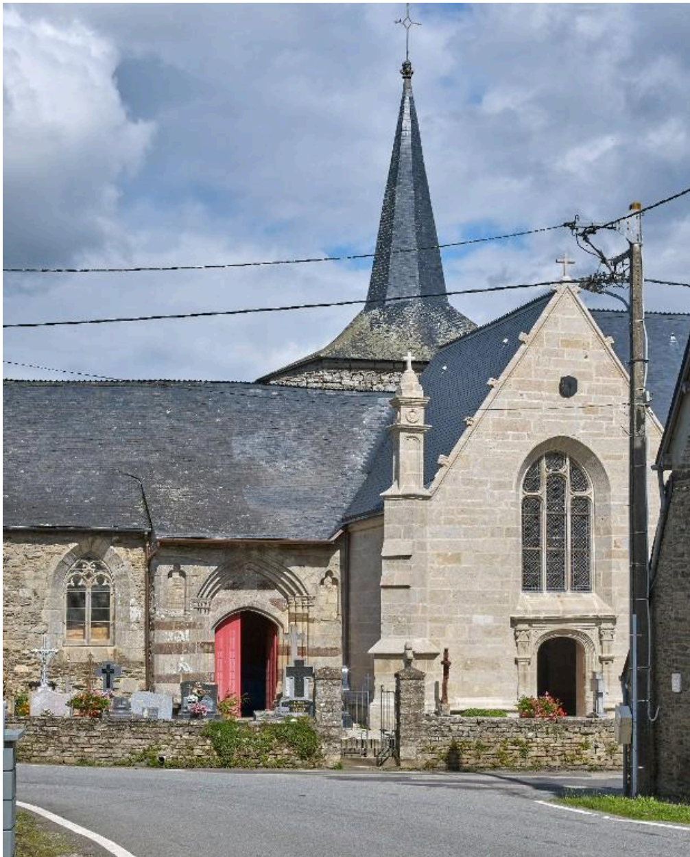
Façade sud de la chapelle depuis la rue
