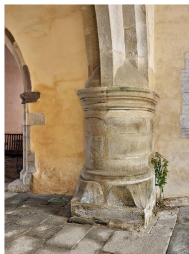
Puissant pilier du transept sud Phot. Bernard Bègne IVR53_20215600678NUCA
