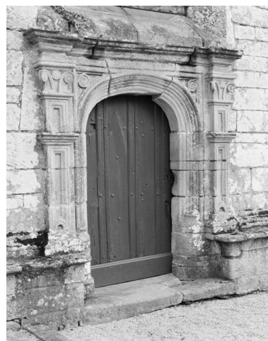
Chapelle, bras sud du transept, élévation sud : le portail (état en 1991) Phot. Guy Artur, Phot. Norbert Lambart IVR53_19915600582X
