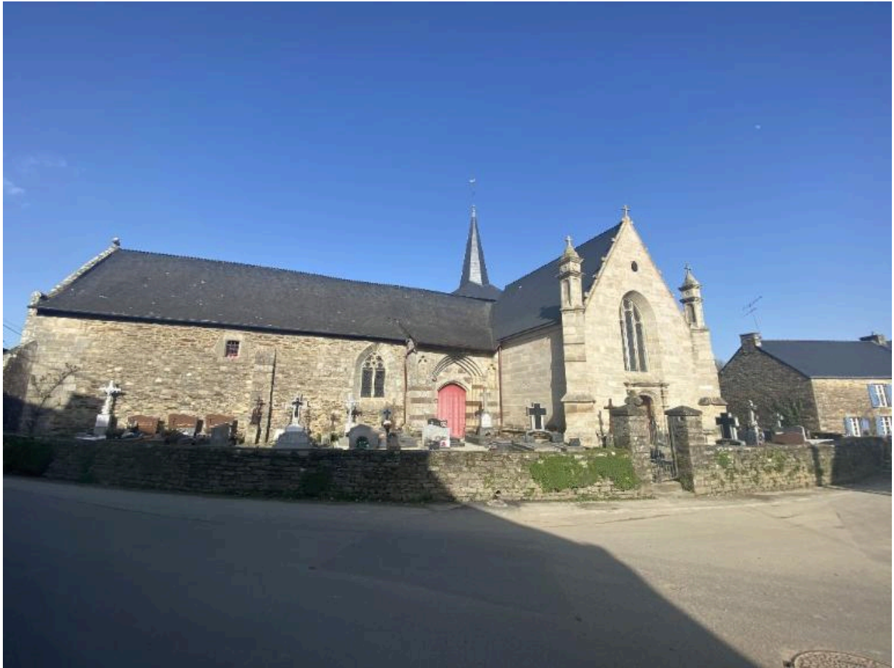
Élévation sud, vue générale
