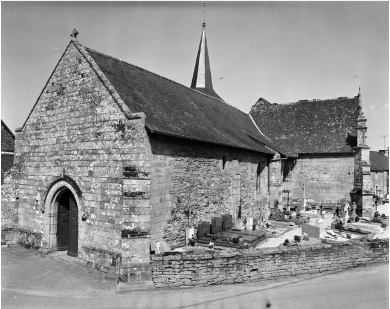
Chapelle vue du sud-ouest (état en 1991)
