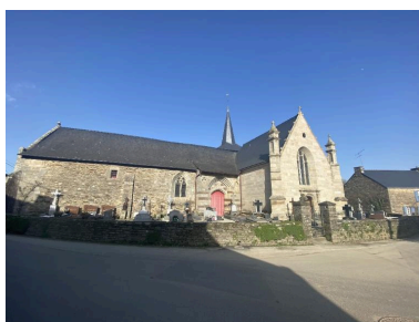
Élévation sud, vue générale Phot. Baptiste Oligo IVR53_20265610890NUCA
