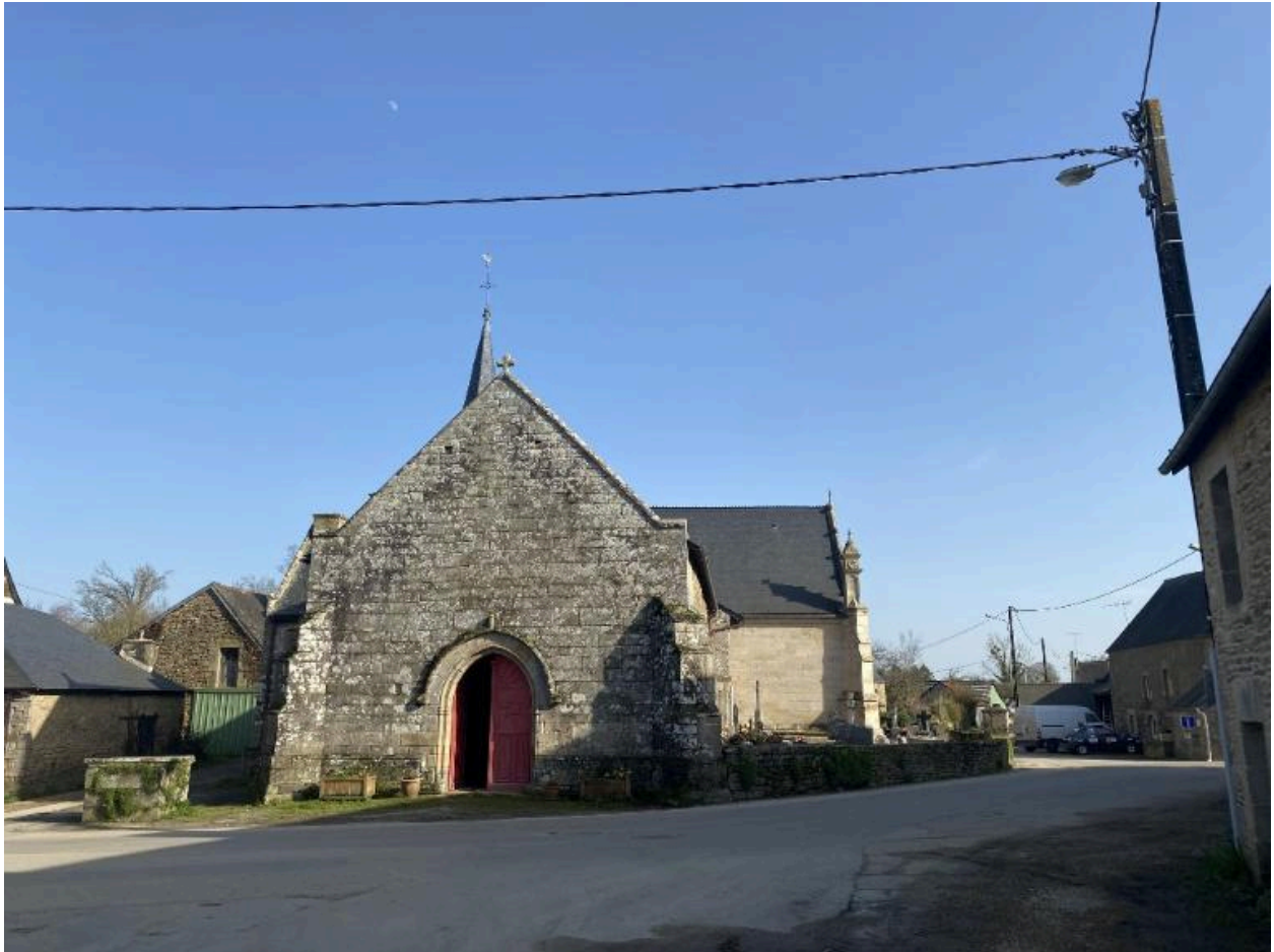
Élévation ouest, vue générale
