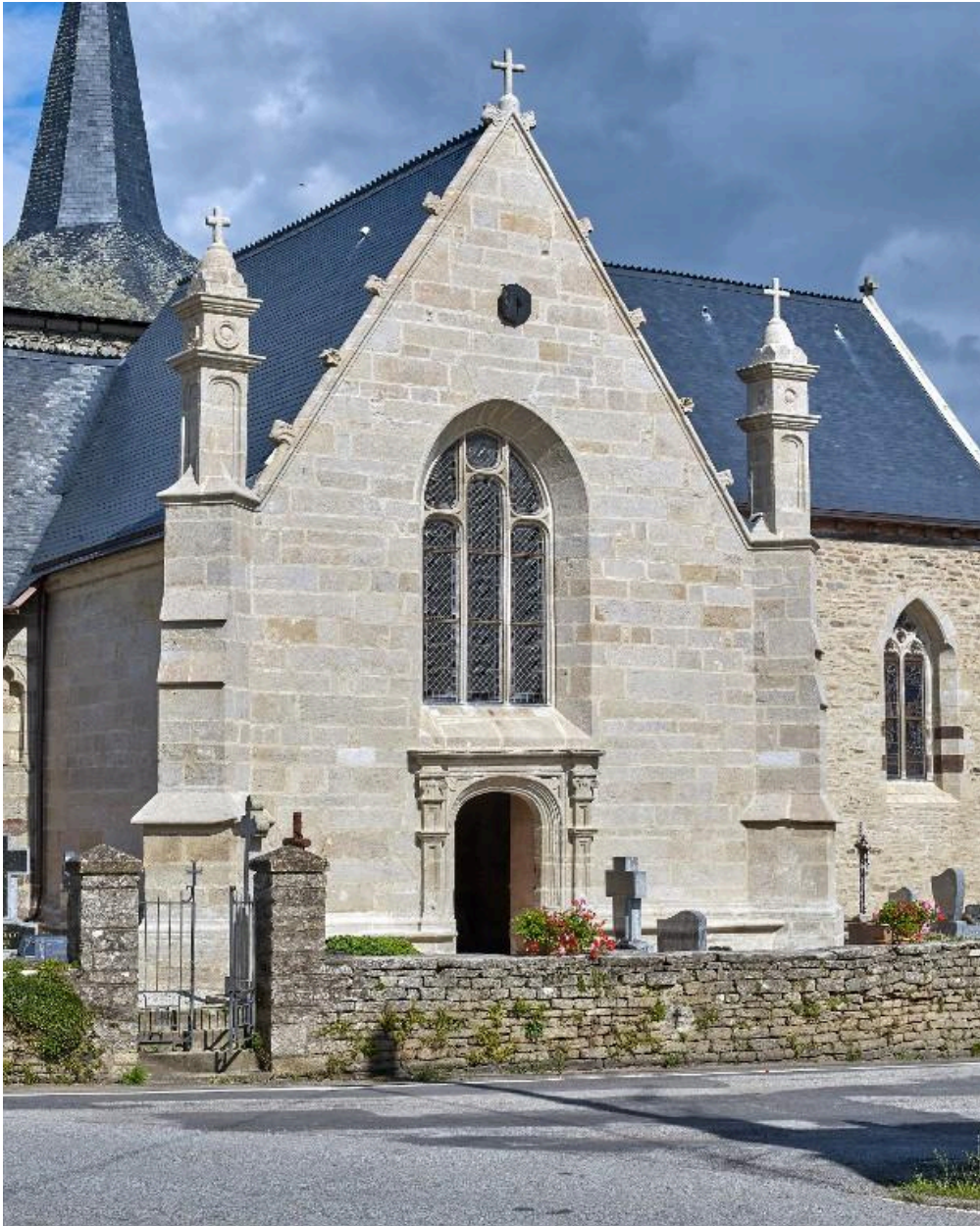
Pignon sud de la chapelle
