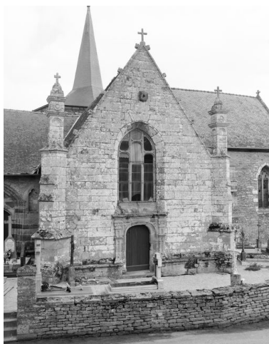
Chapelle, bras sud du transept : élévation sud (état en 1991) Phot. Guy Artur, Phot. Norbert Lambart IVR53_19915600583X
