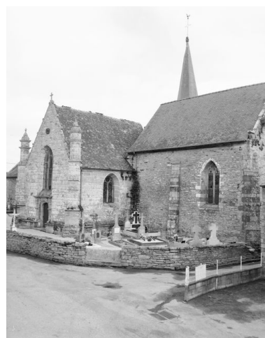
Chapelle vue du sud-est (état en 1991) Phot. Guy Artur, Phot. Norbert Lambart IVR53_19915600577X
