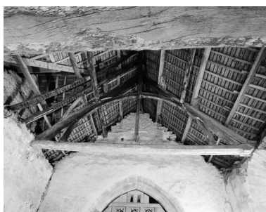
Chapelle, la nef : la charpente entre le carré du transept et le mur diaphragme (état en 1992) Phot. Guy Artur, Phot. Norbert Lambart IVR53_19925601326X
