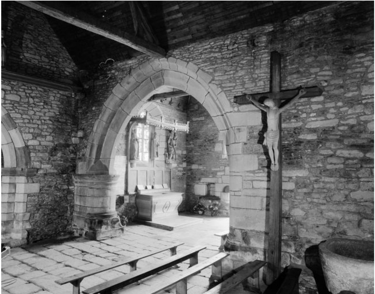
Chapelle, transept : arcade sud (état en 1992)
