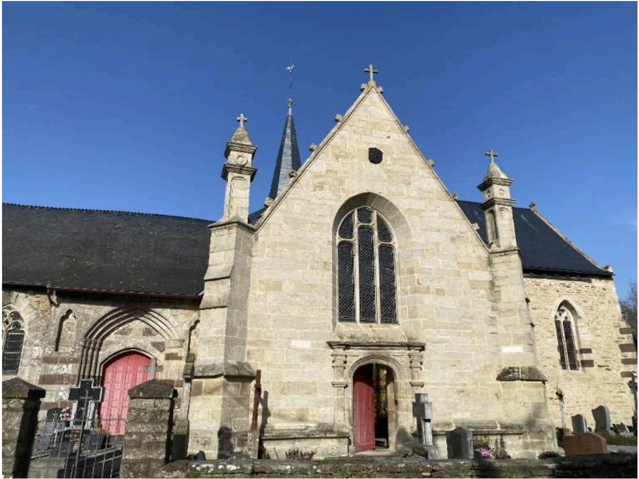
Élévation sud, détail
