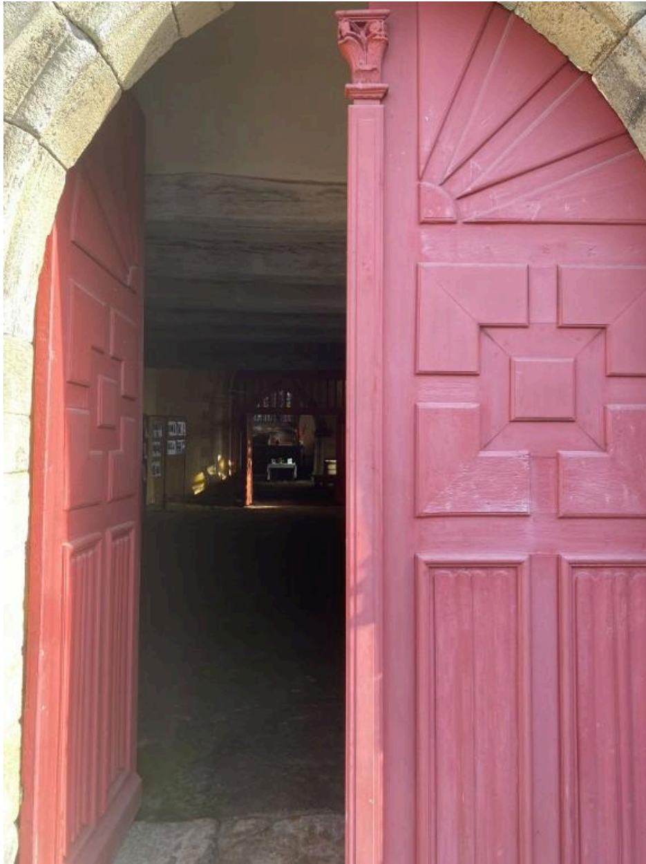
Porte, élévation ouest, détail
