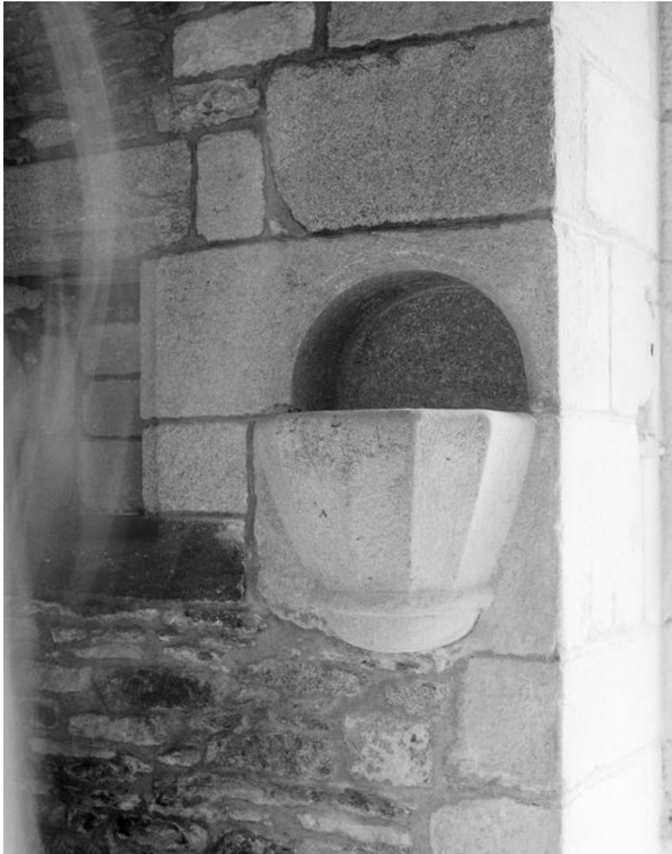
Chapelle, bras sud du transept : bénitier (état en 1992)
