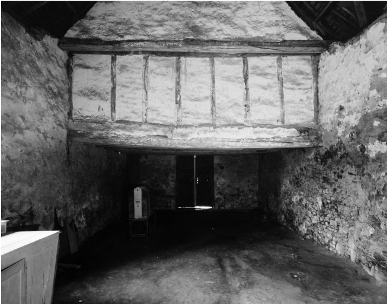
Chapelle, la nef : la salle qui accueillait les pèlerins (état en 1992)
