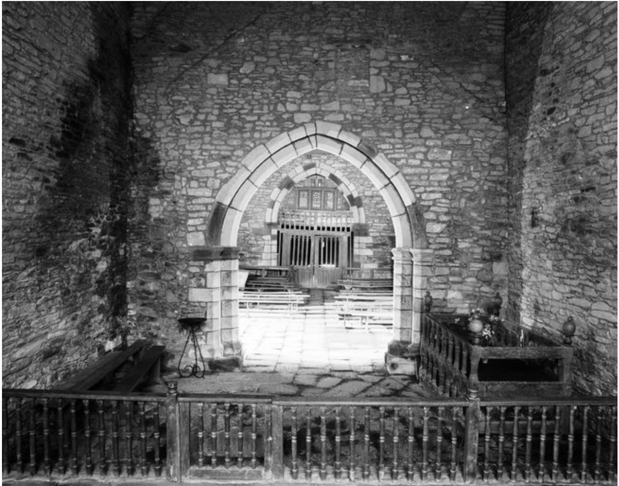
Chapelle : vue du choeur vers l'ouest (état en 1992)
