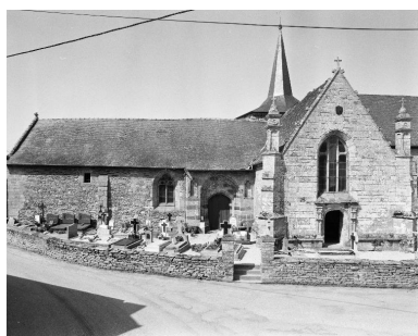
Chapelle : élévation sud (état en 1991) Phot. Guy Artur, Phot. Norbert Lambart IVR53_19915601037X
