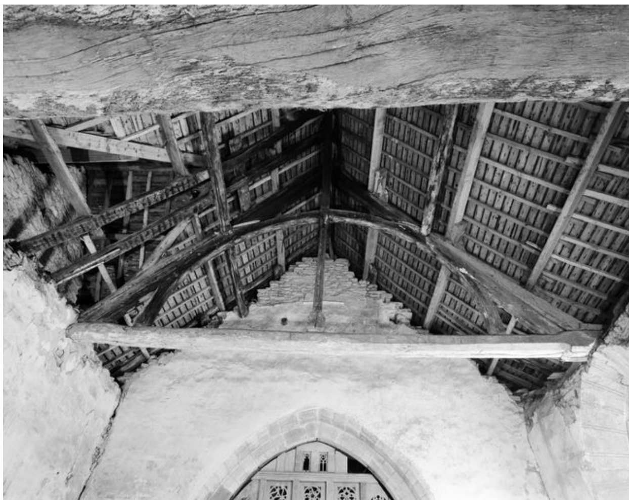
Chapelle, la nef : la charpente entre le carré du transept et le mur diaphragme (état en 1992)
