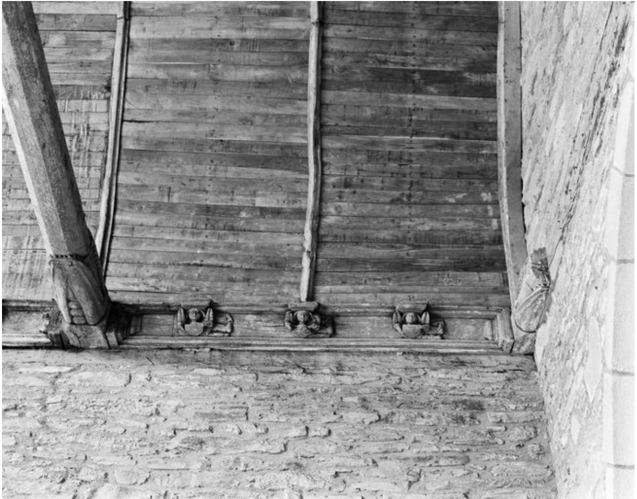
Chapelle, bras sud du transept : sablière côté ouest (état en 1992)
