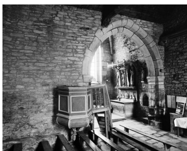
Chapelle : carré du transept vu vers le nord-est (état en 1992) Phot. Guy Artur, Phot. Norbert Lambart IVR53_19925601300X
