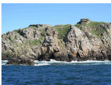
Vue générale de l'Île de Cézembre depuis la mer : côte nord (état en 2015). On aperçoit le bunker-poste de direction de tir de type M 157 à droite et une cuve pour canon de 19,4 cm à gauche. Entre les deux se trouve un bunker de type S 302 Phot. Guillaume Lécueillier IVR53_20263510315NUCA
