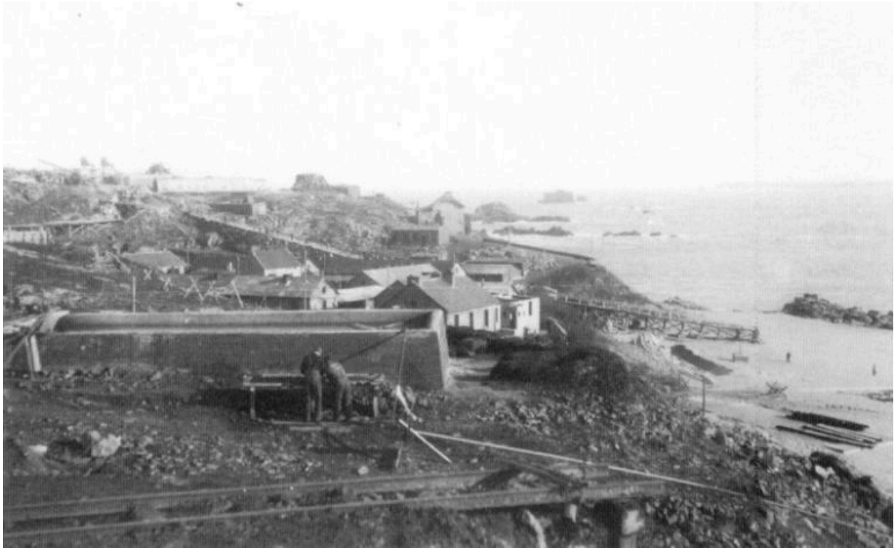
Vue de l'île de Cézembre depuis la pointe ouest : chantier de construction des fortifications, fin 1942-1943
