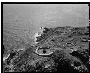
Vue aérienne oblique de l'Île de Cézembre, juillet 1963 Phot. Créations Artistiques Heurtier IVR53_20263510343NUC
