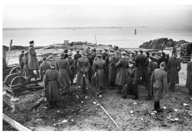
Vue d'une inspection des travaux de fortification de l'île Cézembre en présence d'une délégation japonaise, fin 1942-1943. Il s'agit d'une photographie de propagande nazie Phot. Auteur inconnu IVR53_20263510355NUC
