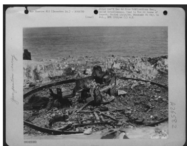
Vue des résultats des bombardements américains sur l'Île de Cézembre : cuve en béton armée et canon de 19,4 cm de calibre (ici, les vestiges du pivot central), septembre 1944
