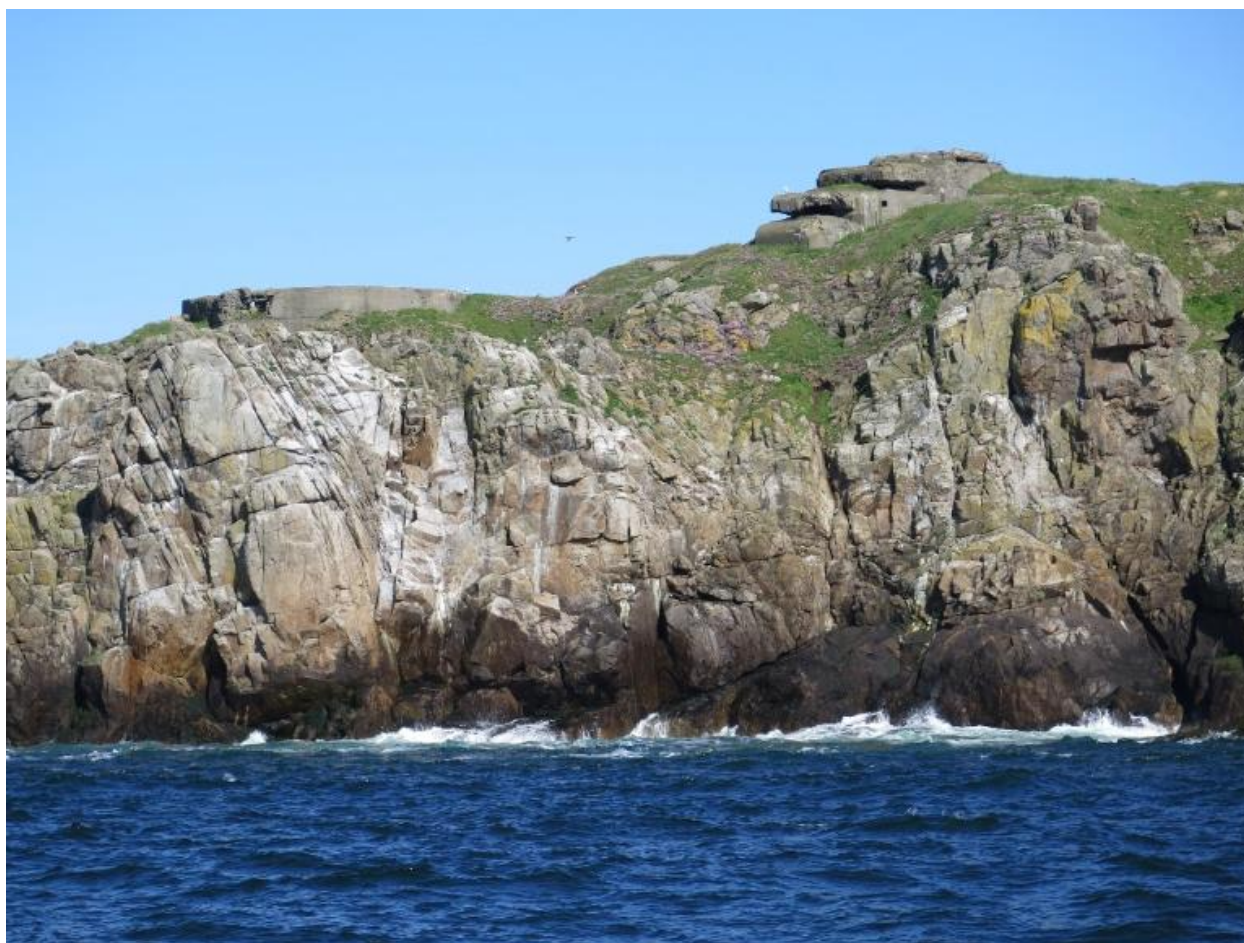
Vue générale de l'Île Cézembre depuis la mer : côte ouest (état en 2015). On aperçoit le bunker-poste de direction de tir de type M 157 à droite et une cuve pour canon de 19,4 cm à gauche
