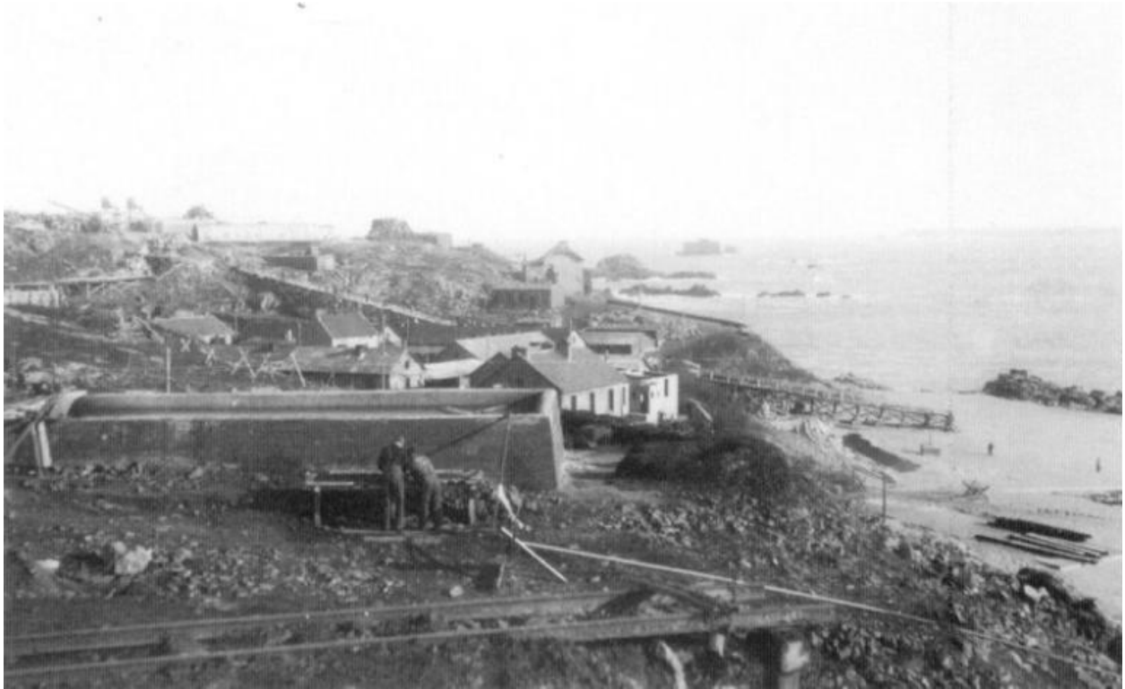
Vue de l'île Cézembre depuis la pointe ouest : chantier de construction des fortifications, fin 1942-1943
