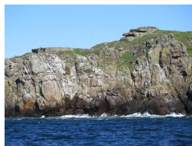
Vue générale de l'île Cézembre depuis la mer : côte ouest (état en 2015). On aperçoit le bunker-poste de direction de tir de type M 157 à droite et une cuve pour canon de 19,4 cm à gauche Phot. Guillaume Lécueillier IVR53_20263510314NUCA
