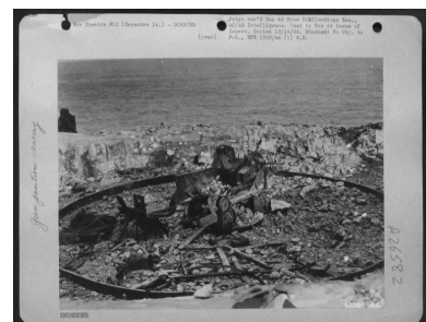
Vue des résultats des bombardements américains sur l'Île Cézembre : cuve en béton armée et canon de 19,4 cm de calibre (ici, les vestiges du pivot central), septembre 1944 Repro. National Archives and Records Administration, Phot. United States Air Force IVR53_20263510351NUC
