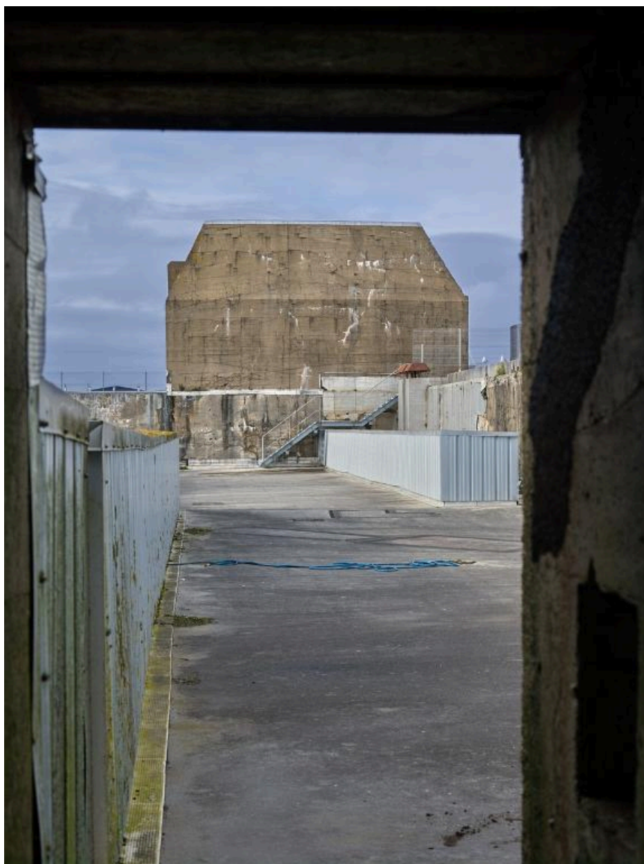
Vue générale depuis le bunker - cuves sud
