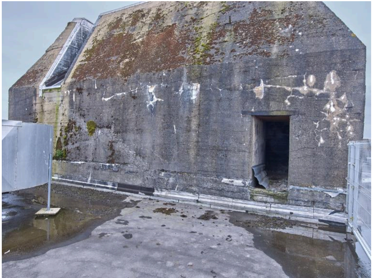
Vue de l'élévation nord : entrée. La cuve était accessible par un escalier extérieur dont on voit encore les traces à gauche de l'entrée
