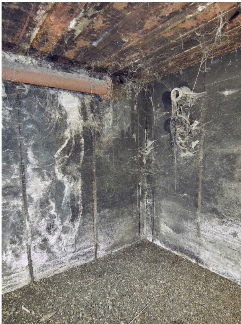
Vue intérieure : pièce de vie - chambre ; dans le mur, conduit de cheminée du poêle et conduit de ramonage (fermé par un couvercle boulonné). Des toiles d'araignée ont envahi le bunker. Au sol, des fientes d'oiseau
