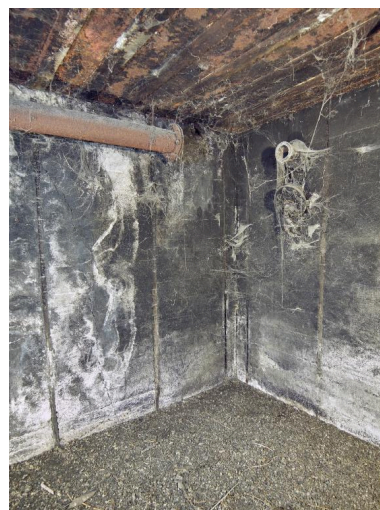
Vue intérieure : pièce de vie - chambrée ; dans le mur, conduit de cheminée du poêle et conduit de ramonage (fermé par un couvercle boulonné). Des toiles d'araignée ont envahi le bunker.
