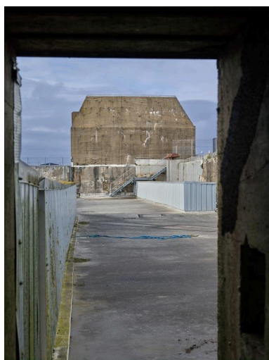
Vue générale depuis le bunker - cuves sud Phot. Bernard Bègne IVR53_20235600216NUCA
