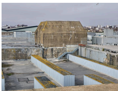
Vue générale depuis le sud (depuis la dalle de couverture du bunker - cuves et abri sud). La forme pyramidale est caractéristique des cuves pour canon antiaérien. L'abri se trouve en-dessous
