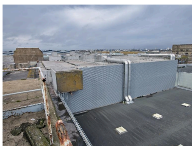
Vue de la dalle de couverture du bunker Keroman I. A gauche, bunker - cuve pour un canon antiaérien quadruple de 2 cm et abri. Au centre, accès des trémies à charbon (masqué par le bardage) avec son monorail pour le chargement depuis le parc à charbon Phot. Bernard Bègne IVR53_20235600208NUCA
