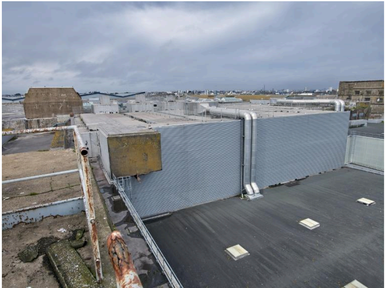
Vue de la dalle de couverture du bunker Keroman I. A gauche, bunker - cuve pour un canon antiaérien quadruple de 2 cm et abri. Au centre, accès des trémies à charbon (masqué par le bardage) avec son monorail pour le chargement depuis le parc à charbon
