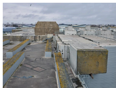
Vue de la dalle de couverture du bunker Keroman I. Au centre, bunker - cuve pour un canon antiaérien quadruple de 2 cm et abri. A droite au premier plan, accès des trémies à charbon (masqué par le bardage) avec son monorail pour le chargement depuis le parc à charbon Phot. Bernard Bègne IVR53_20235600209NUCA
