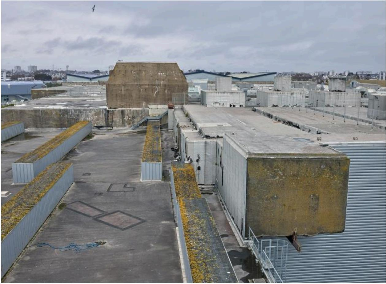
Vue de la dalle de couverture du bunker Keroman I. Au centre, bunker - cuve pour un canon antiaérien quadruple de 2 cm et abri. A droite au premier plan, accès des trémies à charbon (masqué par le bardage) avec son monorail pour le chargement depuis le parc à charbon
