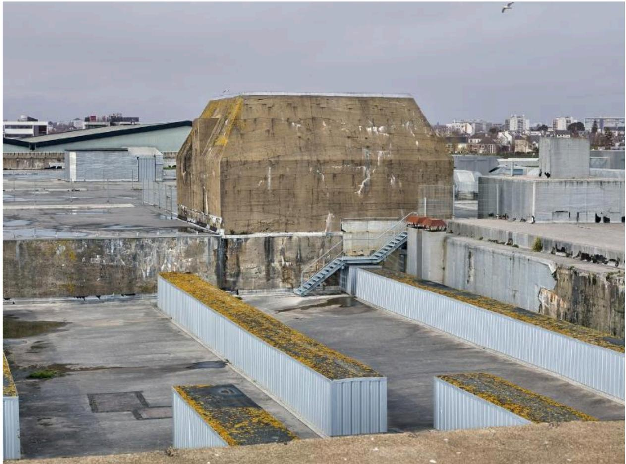
Vue générale depuis le sud (depuis la dalle de couverture du bunker - cuves et abri sud). La forme pyramidale est caractéristique des cuves pour canon antiaérien. L'abri se trouve en-dessous
