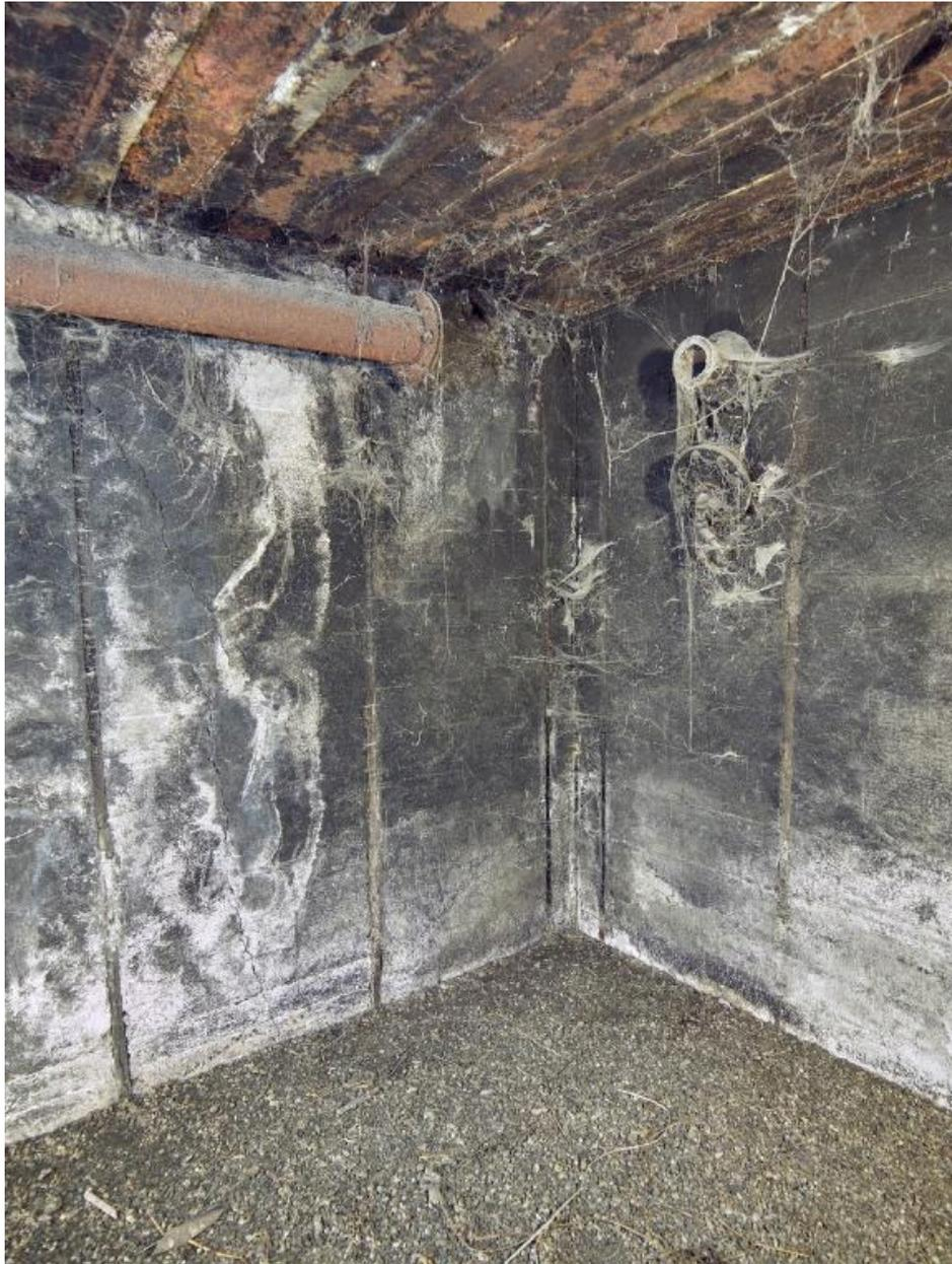
Vue intérieure : pièce de vie - chambrée ; dans le mur, conduit de cheminée du poêle et conduit de ramonage (fermé par un couvercle boulonné). Des toiles d'araignée ont envahi le bunker. Au sol, des fientes d'oiseau
