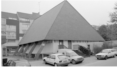
Elévation Nord : vue générale Phot. Bernard Bègne, Phot. M. Loyon IVR53_19933500104X
