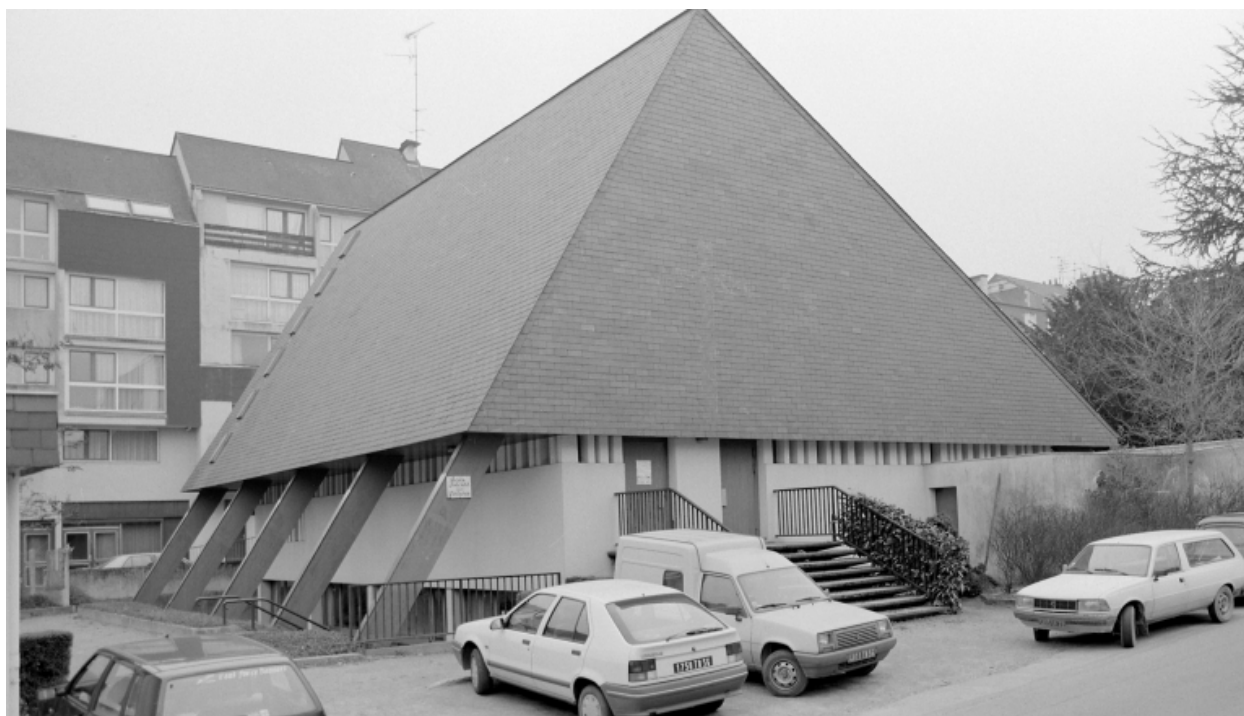
Elévation Nord : vue générale
