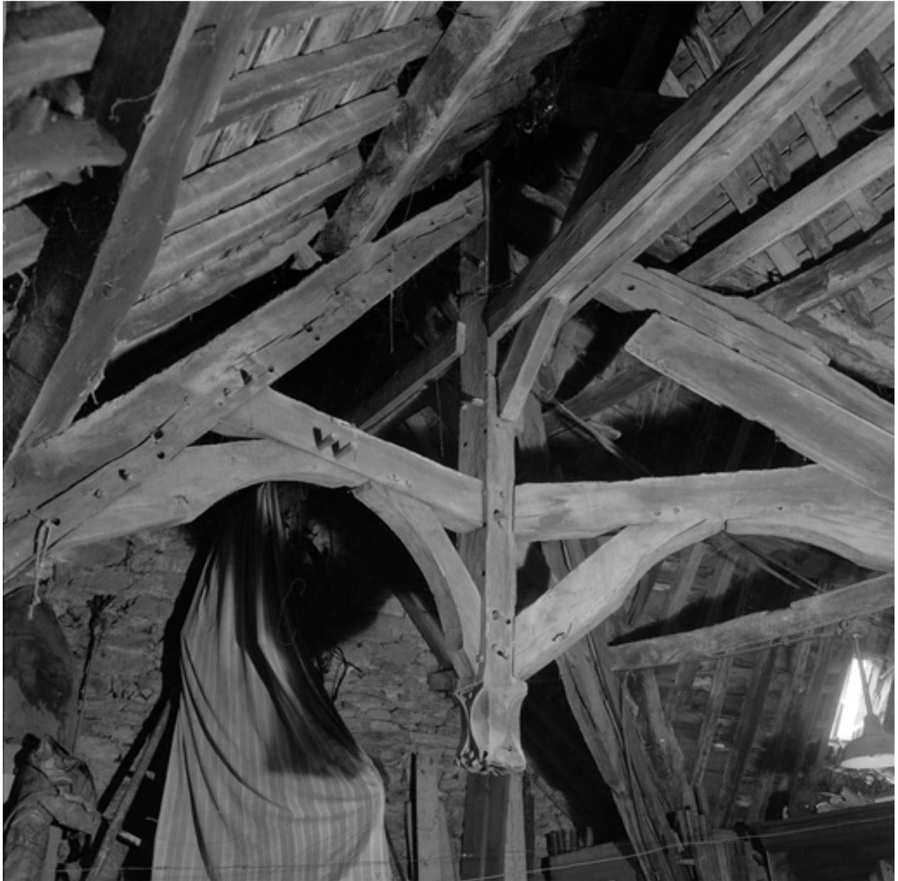
Charpente, vue d'ensemble de l'assemblage central.
