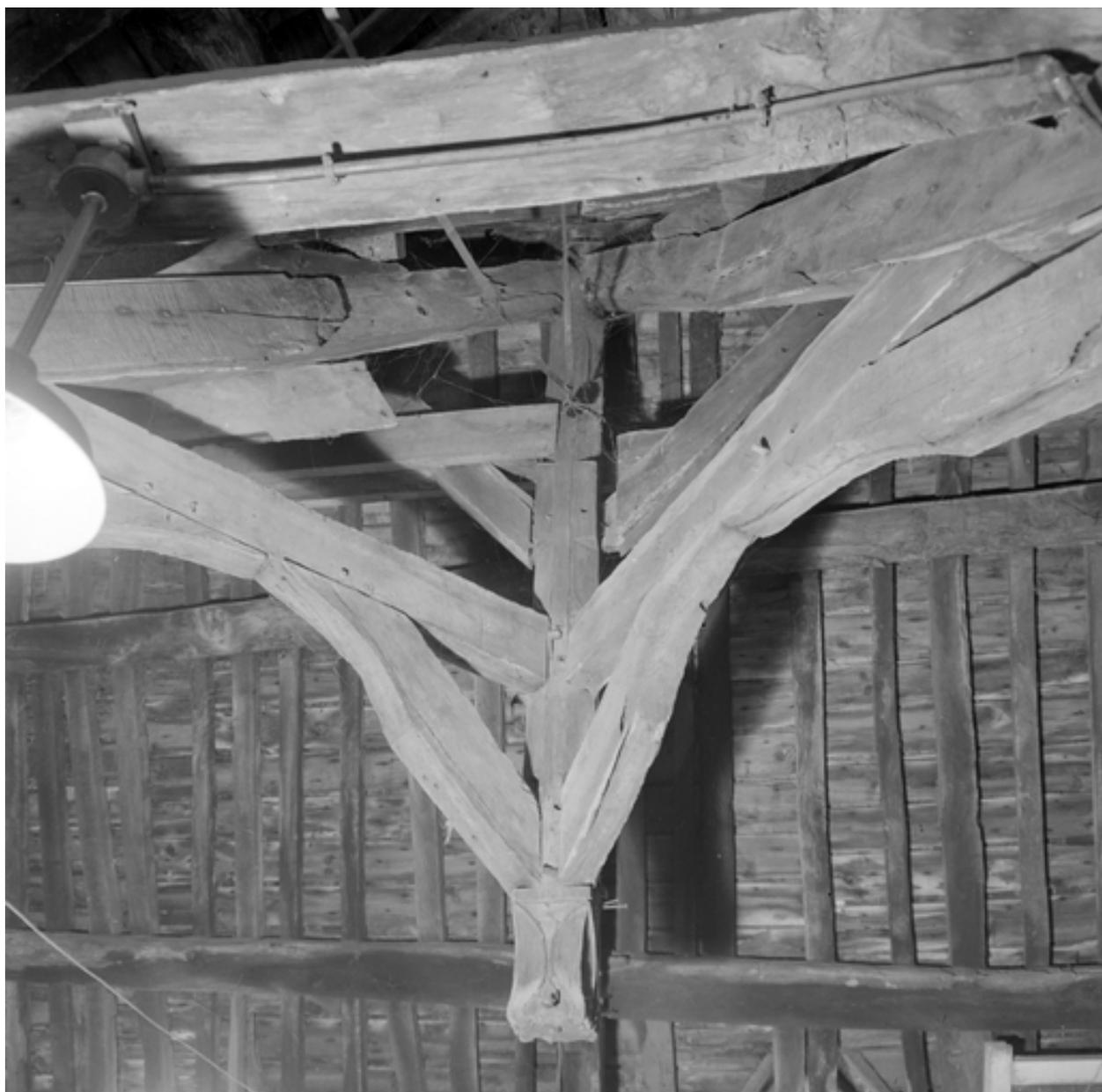
Charpente, détail de l'assemblage central.
