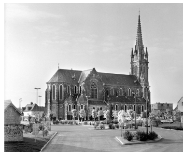
Vue générale nord est Phot. Guy Artur, Phot. Norbert Lambart IVR53_19943501918X
