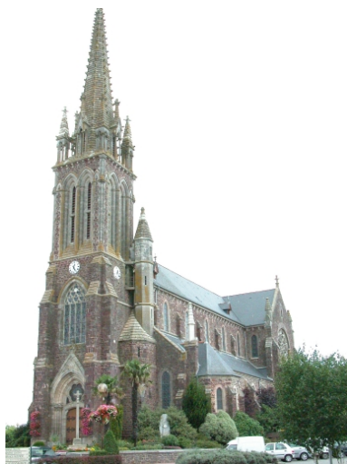
Vue générale sud ouest Phot. Claude Quillivic IVR53_20033517135NUCA
