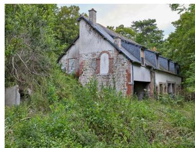
Vue des communs et dépendances : pignon Ouest et élévation Sud. Le pignon est percé d'une porte haute en arc plein cintre en brique donnant accès au comble à surcroît. Deux souches de cheminée émergent du toit. En appentis, grenier arrière et porte
