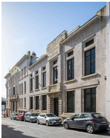
Facade est comportant l'entrée de l'ancien tribunal de commerce dans la continuité du bâtiment. Phot. Charlotte Barraud IVR53_20265600150NUCA
