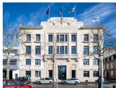
Facade principale, vue générale. Phot. Charlotte Barraud IVR53_20265600120NUCA
