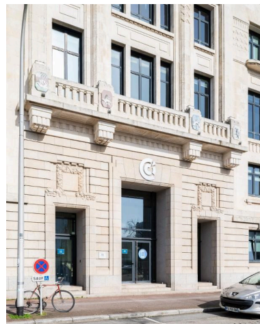
Ancienne entrée principale surplombée par un balcon à balustres comportant les armoiries des villes de Lorient, Vannes, Pontivy et Ploërmel. Phot. Charlotte Barraud IVR53_20265600132NUCA
