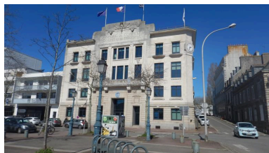
Chambre de commerce et d'Industrie du Morbihan, façade principale (1928) Phot. Laura Thibert IVR53_20225605548NUCA
