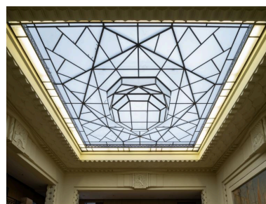
Verrière en couverture du hall principal. Phot. Charlotte Barraud IVR53_20265600192NUCA
