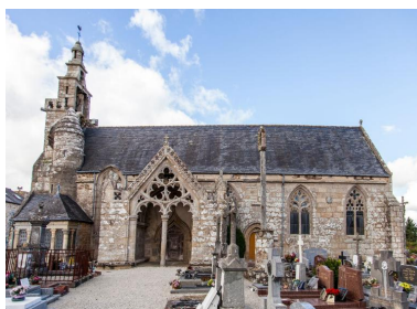
Façade méridionale, Commanderie du Palacret, église paroissiale, Saint-Laurent IVR53_20152211700NUCA
