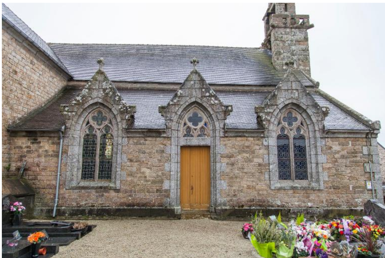
Façade nord, Commanderie du Palacret, église paroissiale, Saint-Laurent
