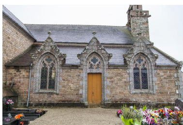
Façade nord, Commanderie du Palacret, église paroissiale, Saint-Laurent IVR53_20152211713NUCA
