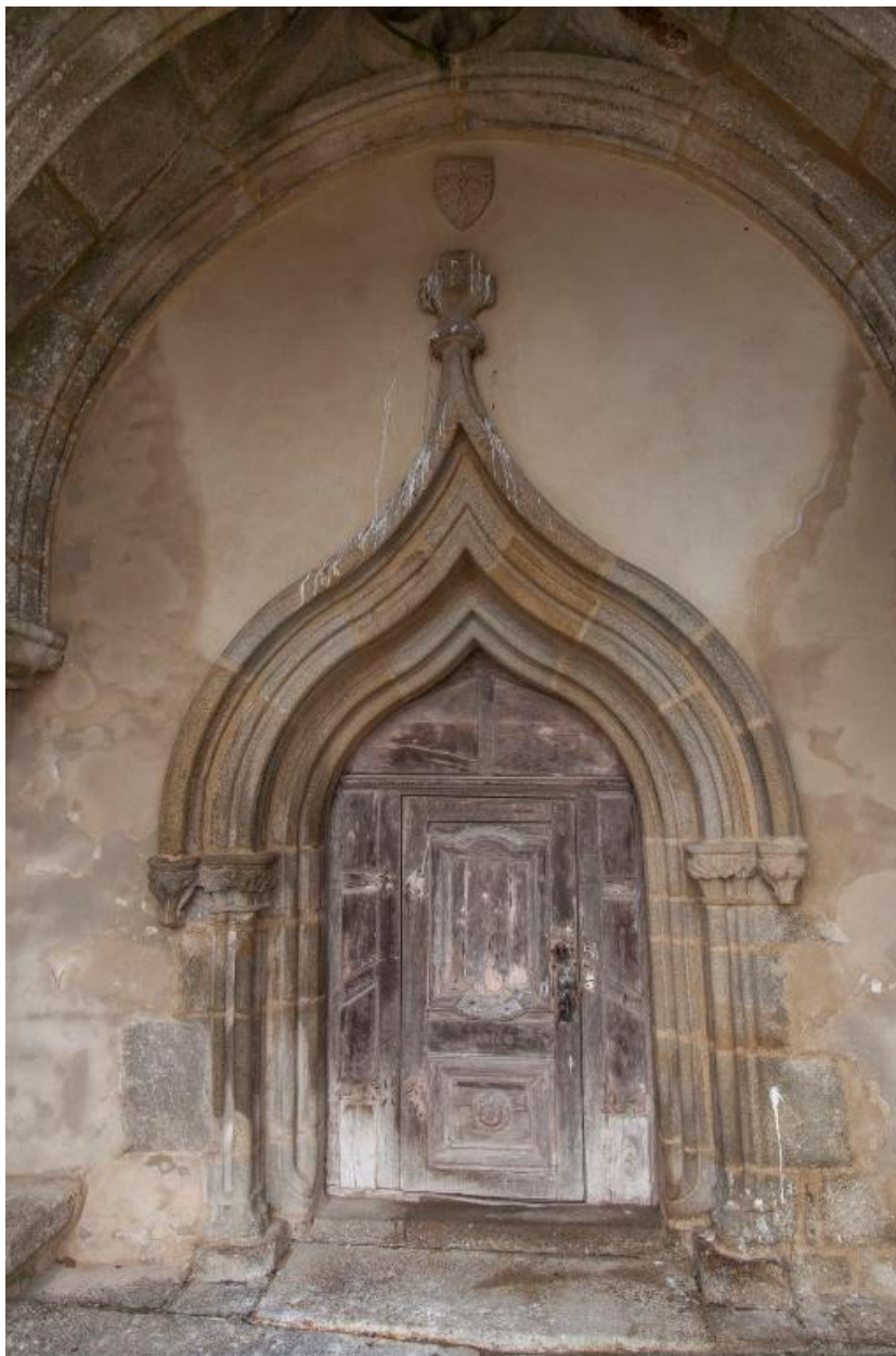
Portail méridional, Commanderie du Palacret, église paroissiale, Saint-Laurent
