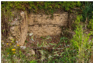
Sondage de la cave enterrée du logis principal, Commanderie du Palacret, Saint-Laurent IVR53_20152211722NUCA
