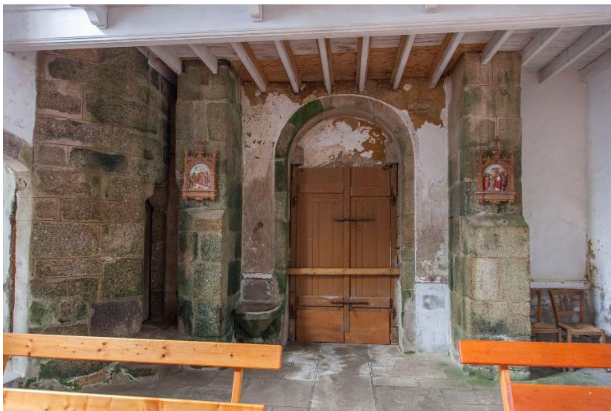
Porte de la tour et contreforts en saillie du clocher-mur, Commanderie du Palacret, église paroissiale, Saint-Laurent
