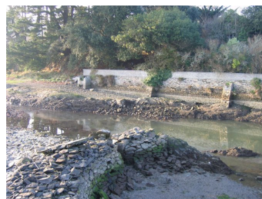
Partie arrière de l'écluse du Fret
