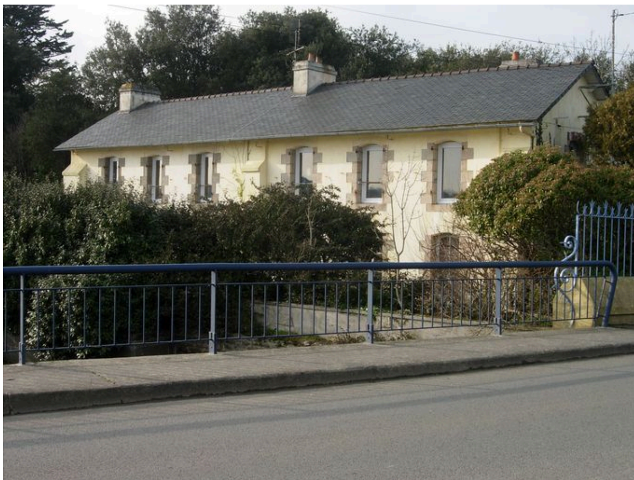
Maison de l'éclusier
