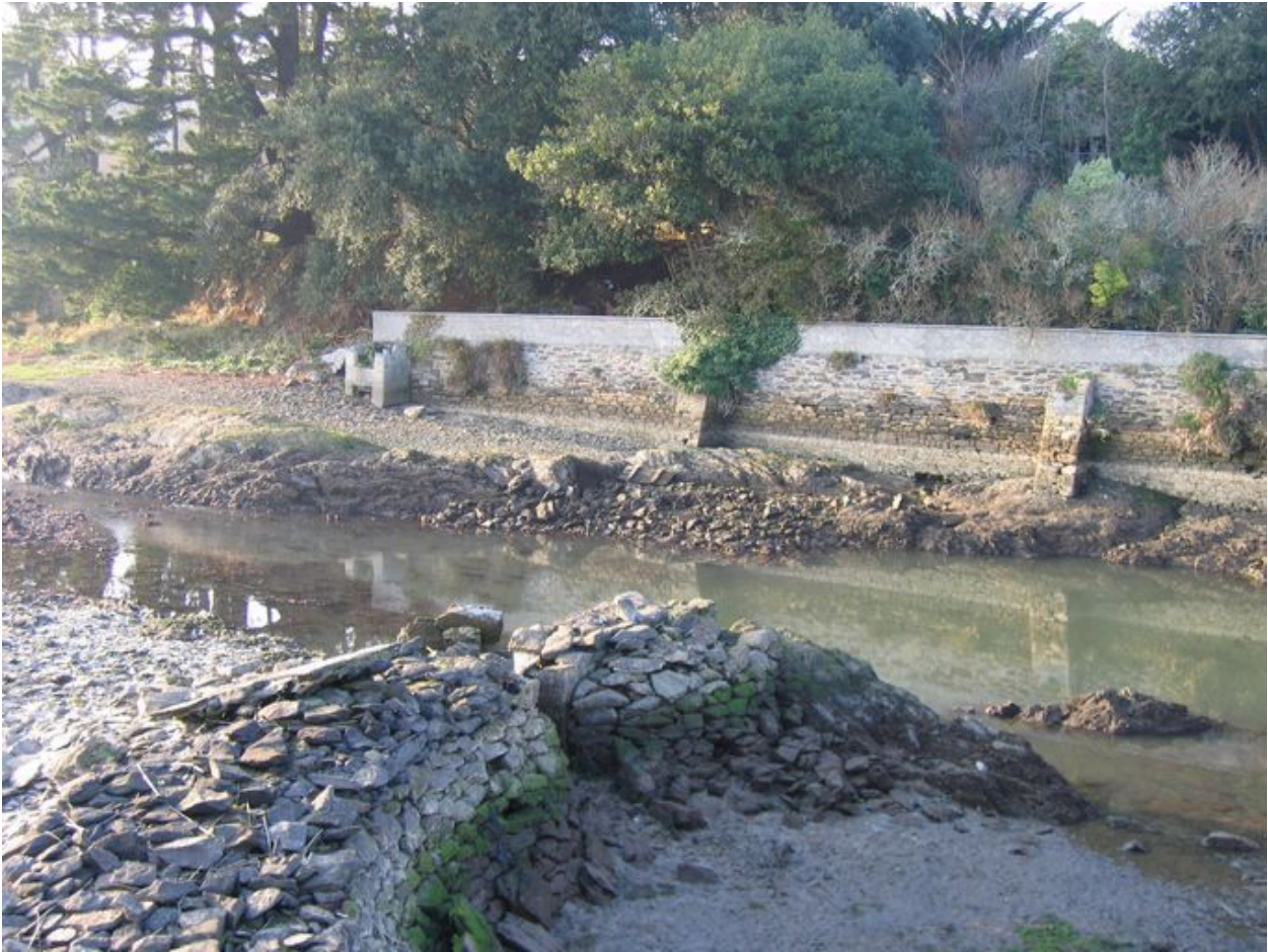
Partie arrière de l'écluse du Fret
