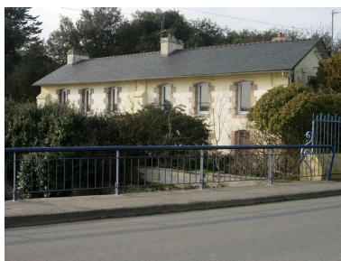
Maison de l'éclusier
