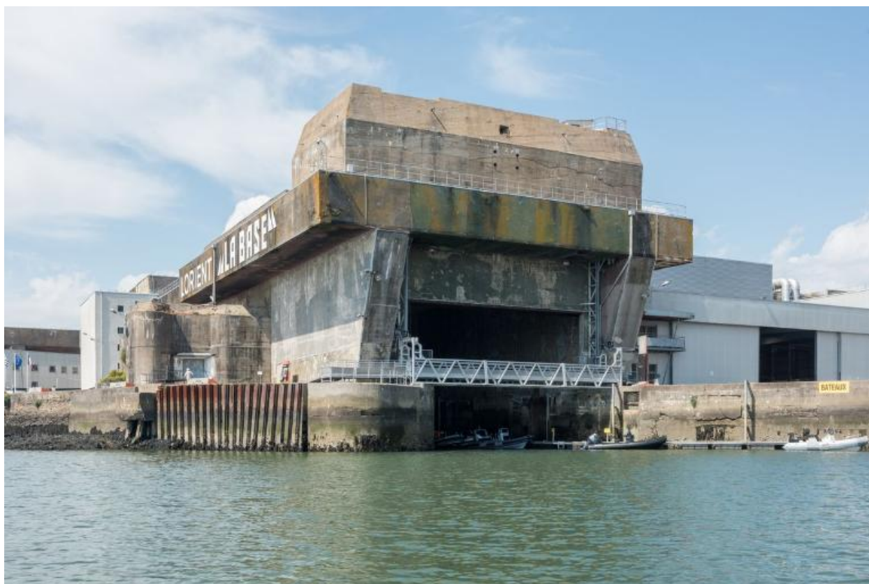
Vue du bunker KI avec l'entrée du slipway : sur la dalle de couverture, le bunker - cuves pour deux canons antiaériens. Sur le quai à gauche, le bunker - casemate de flanquement
