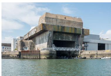
Vue du bunker KI avec l'entrée du slipway : sur la dalle de couverture, le bunker - cuves pour deux canons antiaériens. Sur le quai à gauche, le bunker - casemate de flanquement Phot. Charlotte Barraud IVR53_20215600604NUCA
