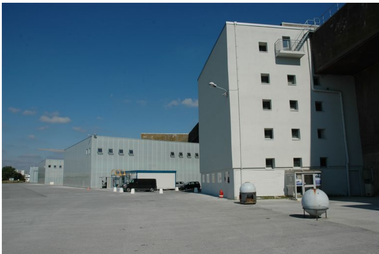
Vue de situation. A l'arrière-plan, les hangars du Port de La Base de Lorient
