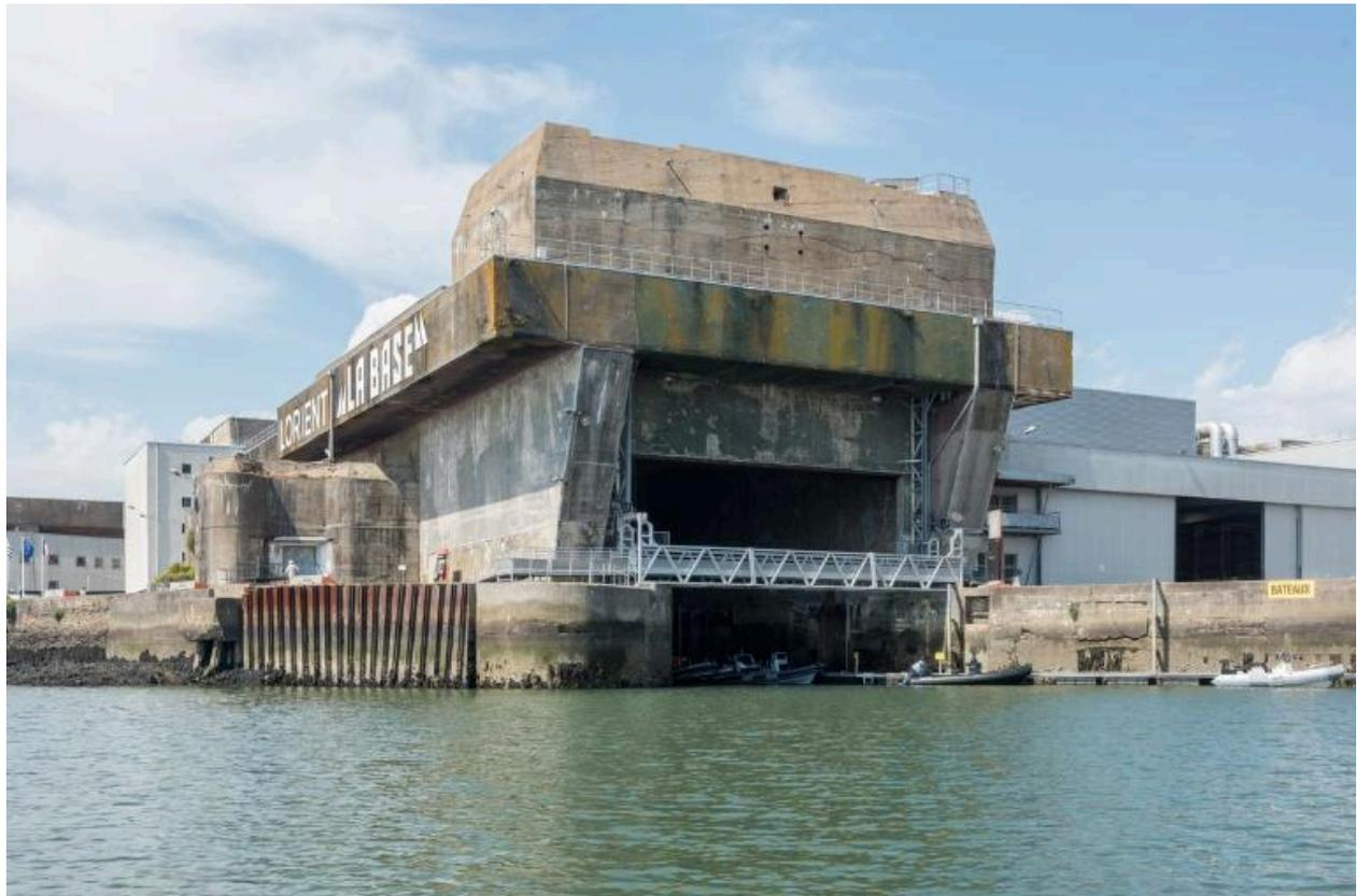
Vue du bunker KI avec l'entrée du slipway : sur la dalle de couverture, le bunker - cuves pour deux canons antiaériens.
