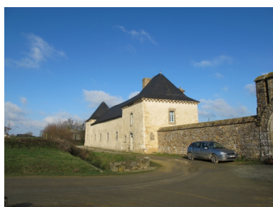
Vue sud-est Phot. Sabrina Dalibard IVR53_20113506117NUCA
