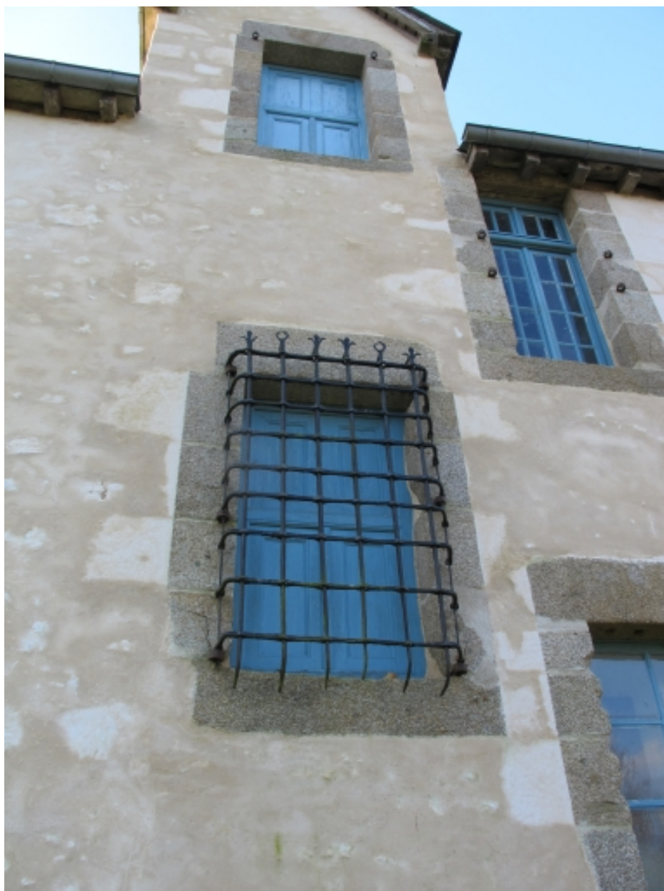
Détail des baies de la façade nord
