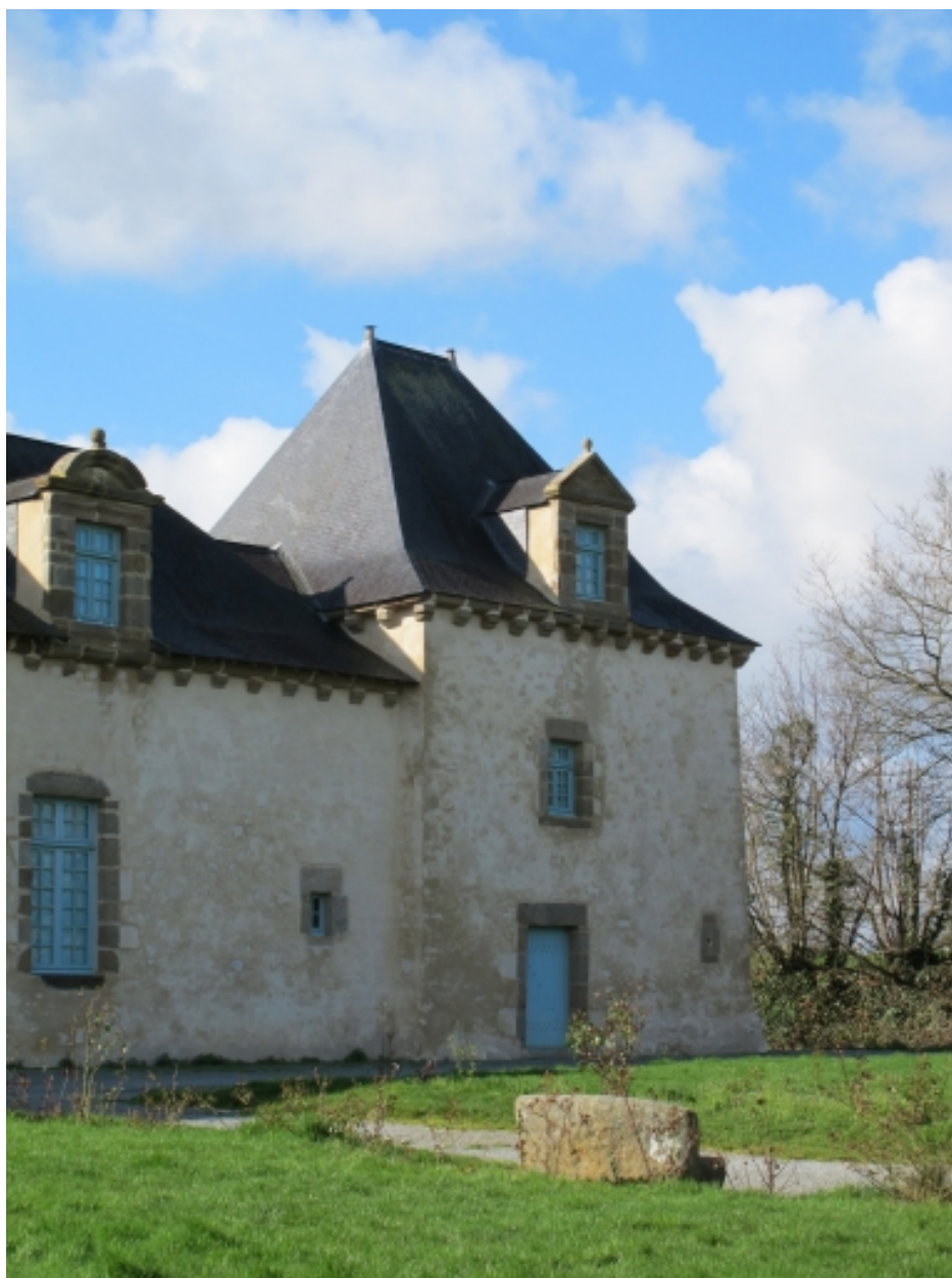
Partie ouest du bâtiment sud-ouest
