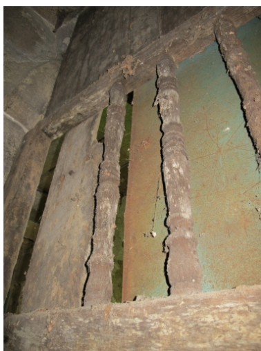
Balustrade en bois située au rez-de-chaussée de l'escalier Phot. Sabrina Dalibard IVR53_20113506113NUCA
