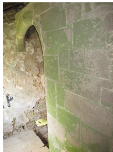
Palier de l'escalier Phot. Sabrina Dalibard IVR53_20113506109NUCA
