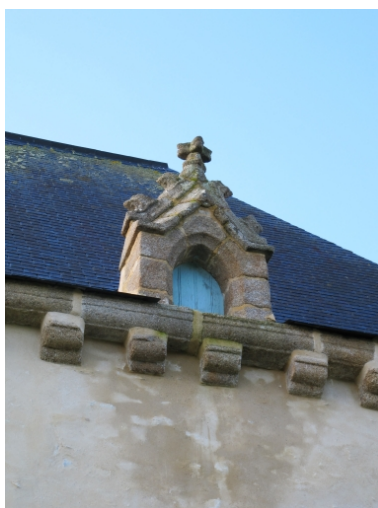
Lucarne de la chapelle Phot. Sabrina Dalibard IVR53_20113506119NUCA
