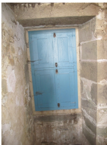
Fenêtre située dans la montée de l'escalier
