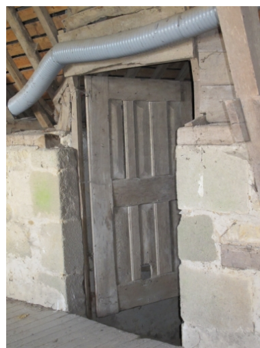
Porte d'accès aux combles du pavillon du logis Phot. Sabrina Dalibard
