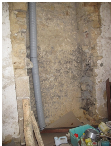
Vestiges d'une cheminée située dans un cabinet de l'étage (façade nord) Phot. Sabrina Dalibard IVR53_20113506100NUCA
