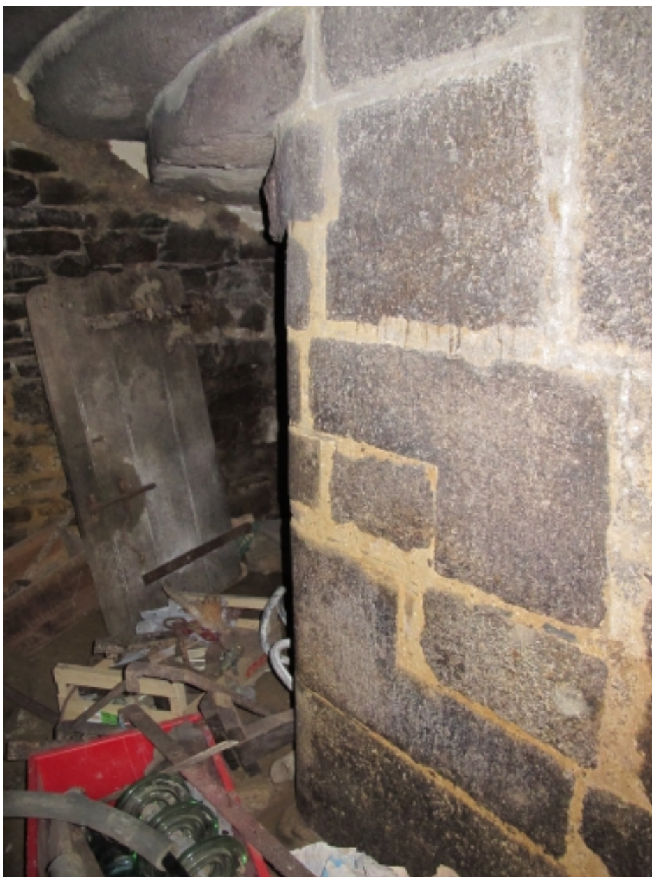
Rez-de-chaussée de l'escalier
