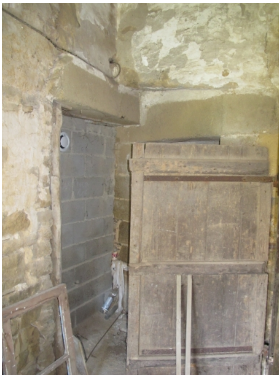
Vestibule situé en partie nord du logis
