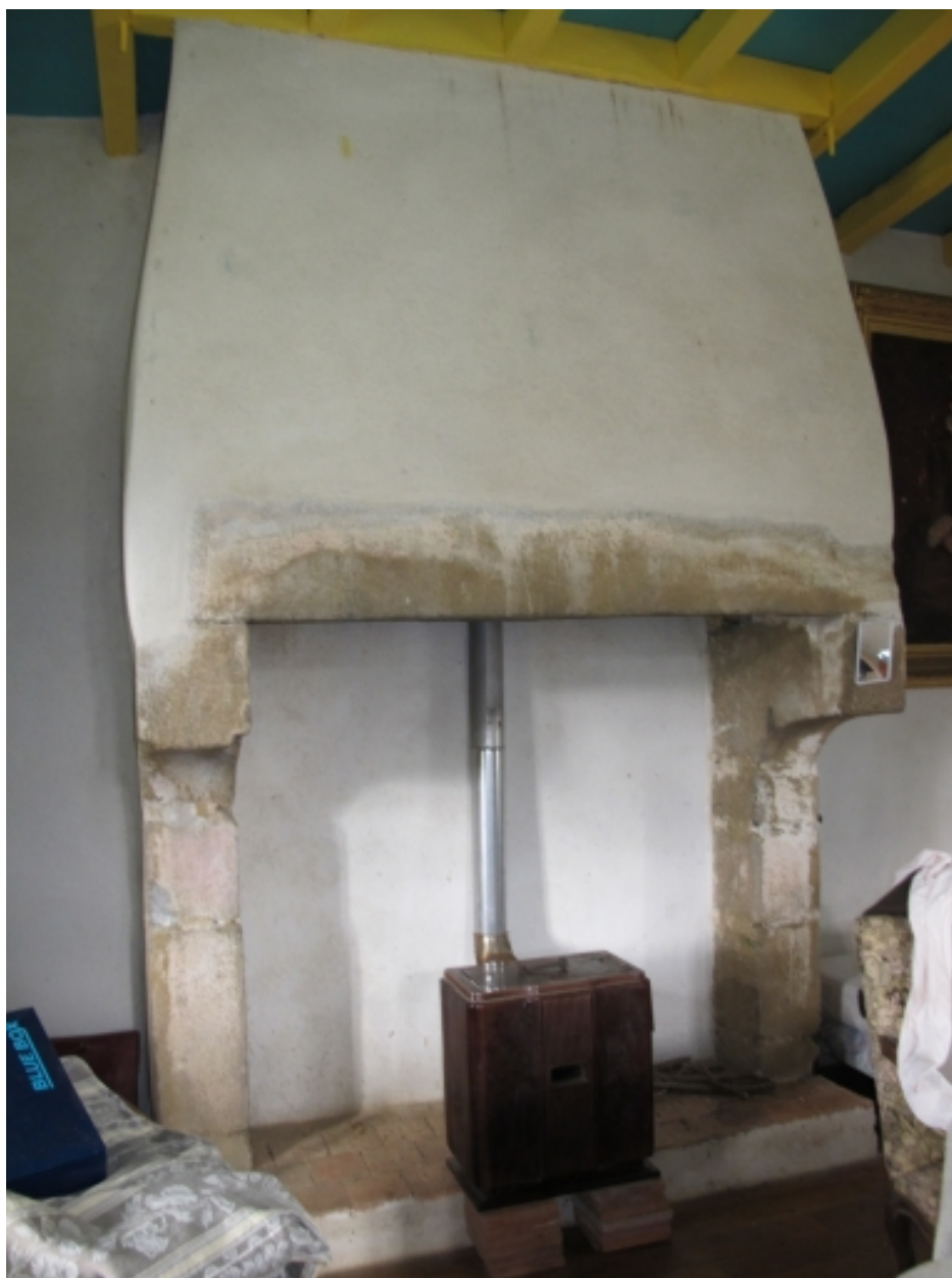
Cheminée située dans le bâtiment sud-ouest
