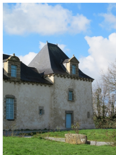
Partie ouest du bâtiment sud-ouest Phot. Sabrina Dalibard IVR53_20113506076NUCA
