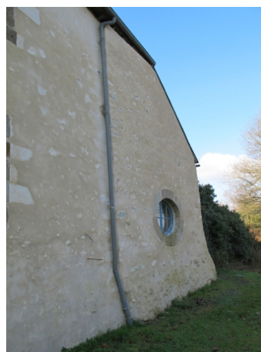
Façade nord du logis, partie ouest Phot. Sabrina Dalibard IVR53_20113506115NUCA
