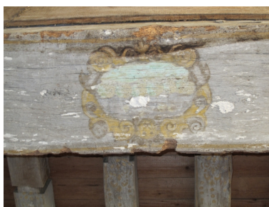
Poutre de l'étage du logis Phot. Sabrina Dalibard IVR53_20113506098NUCA
