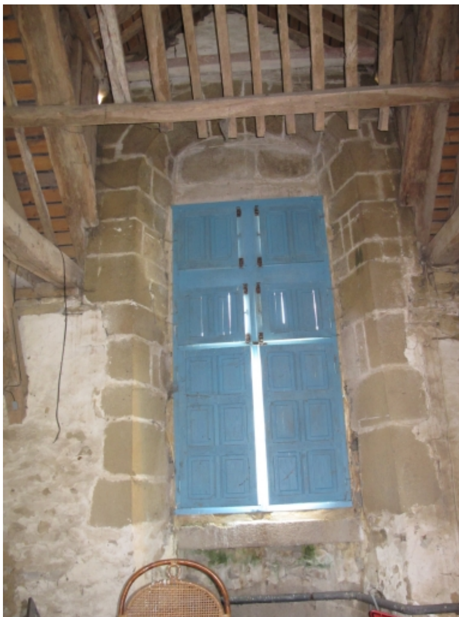
Fenêtre de la salle Est du logis
