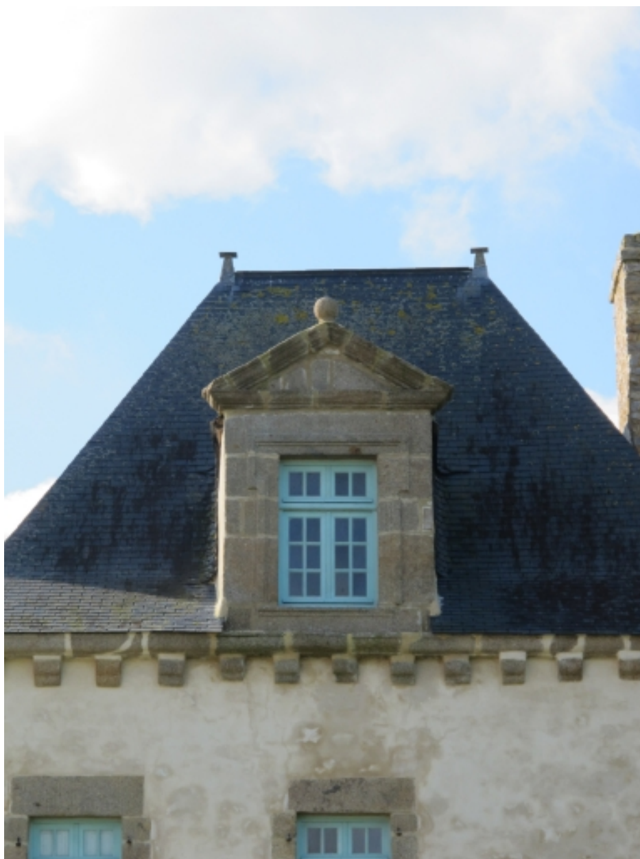
Lucarne de la façade nord du bâtiment sud-ouest
