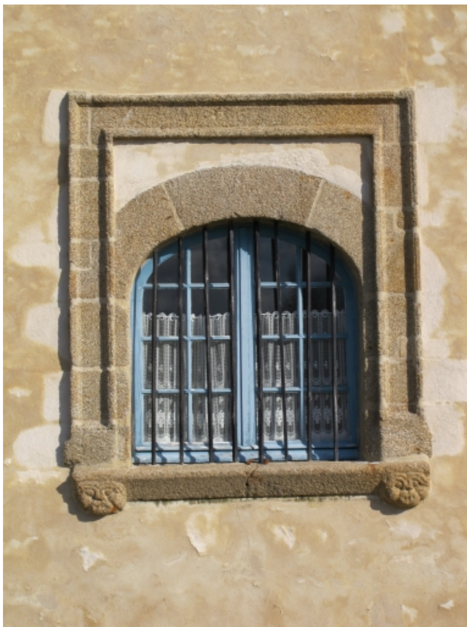
Détail de l'une des baies de la façade sud
