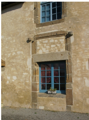
Détail de la façade sud du logis Phot. Sabrina Dalibard IVR53_20113506081NUCA
