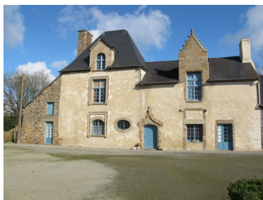
Vue sud Phot. Sabrina Dalibard IVR53_20113506089NUCA
