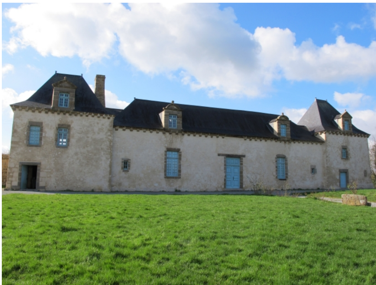
Vue nord du bâtiment sud-ouest
