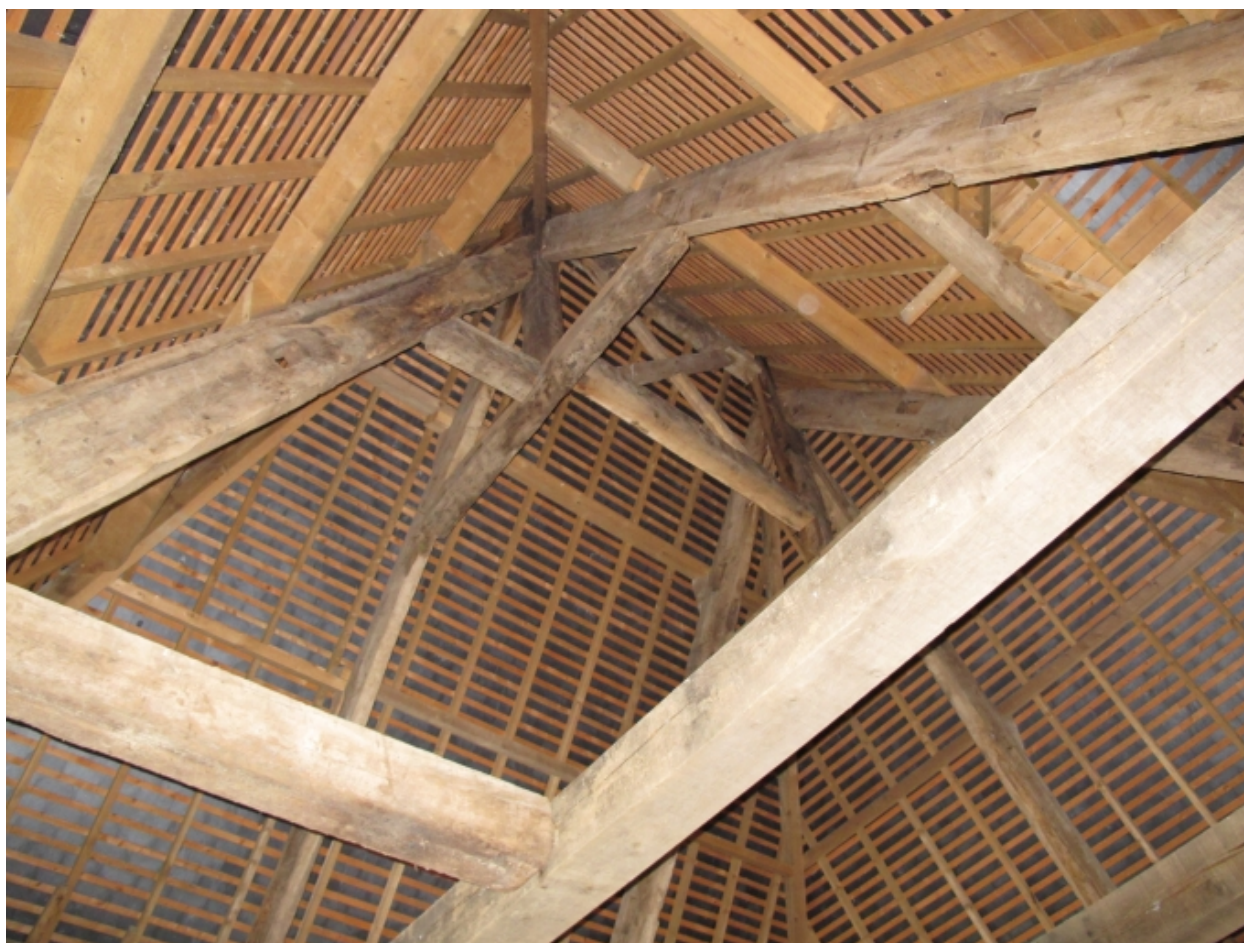
Charpente du pavillon du bâtiment sud-ouest
