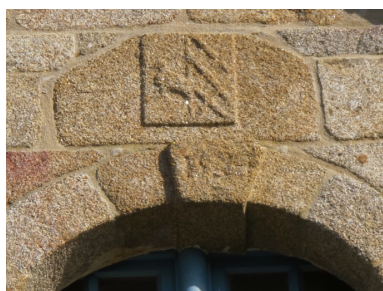
Détail de la lucarne Phot. Sabrina Dalibard IVR53_20113506086NUCA
