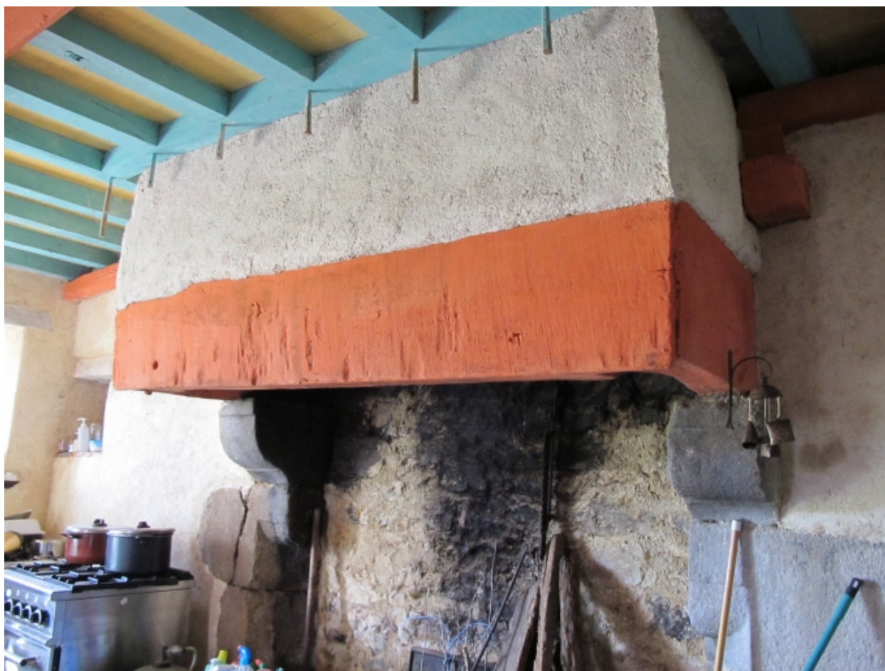
Cheminée du rez-de-chaussée située en partie est du bâtiment sud-ouest
