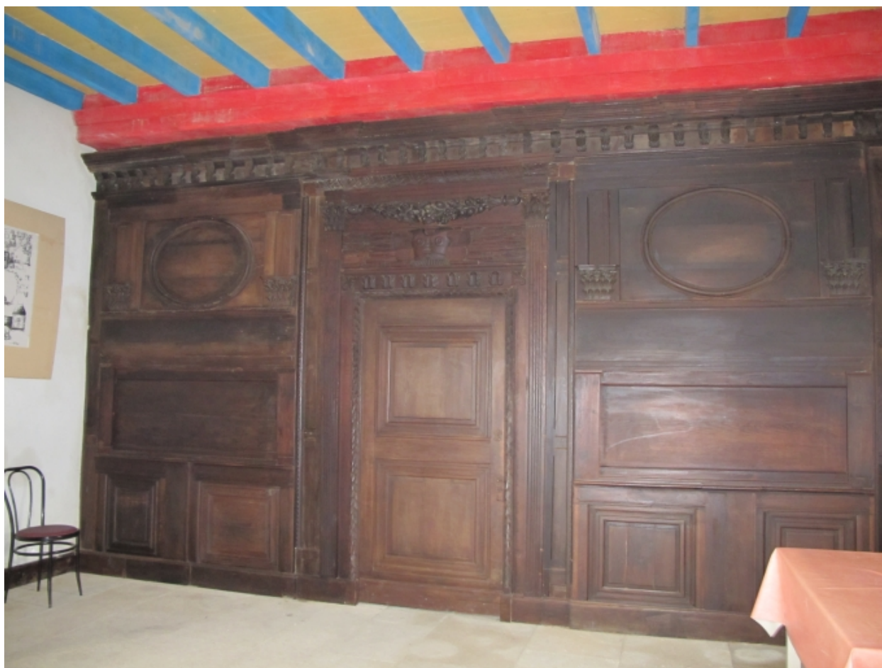
Boiseries du logis réinstallées dans le bâtiment sud-ouest
