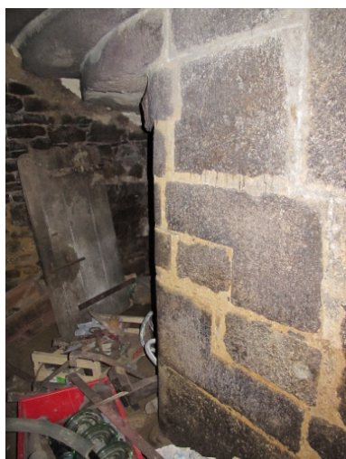
Rez-de-chaussée de l'escalier Phot. Sabrina Dalibard IVR53_20113506111NUCA
