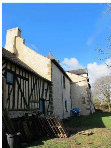
Façade nord du logis Phot. Sabrina Dalibard IVR53_20113506093NUCA
