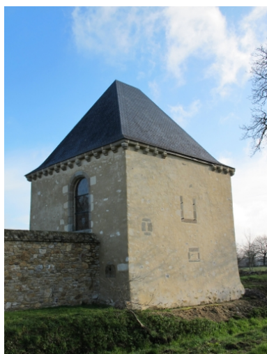
Vue sud-ouest de la chapelle Phot. Sabrina Dalibard IVR53_20113506118NUCA
