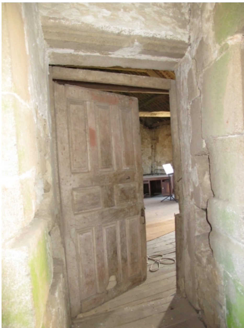
Accès à la pièce Est de l'étage du logis
