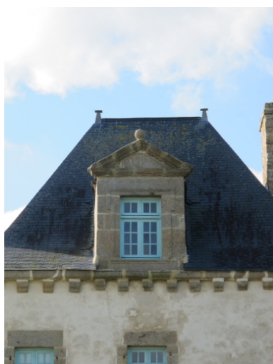
Lucarne de la façade nord du bâtiment sud-ouest Phot. Sabrina Dalibard IVR53_20113506078NUCA
