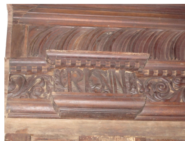
Détail des boiseries Phot. Sabrina Dalibard IVR53_20113506067NUCA
