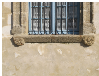
Détail de la fenêtre de la façade sud du logis Phot. Sabrina Dalibard IVR53_20113506080NUCA
