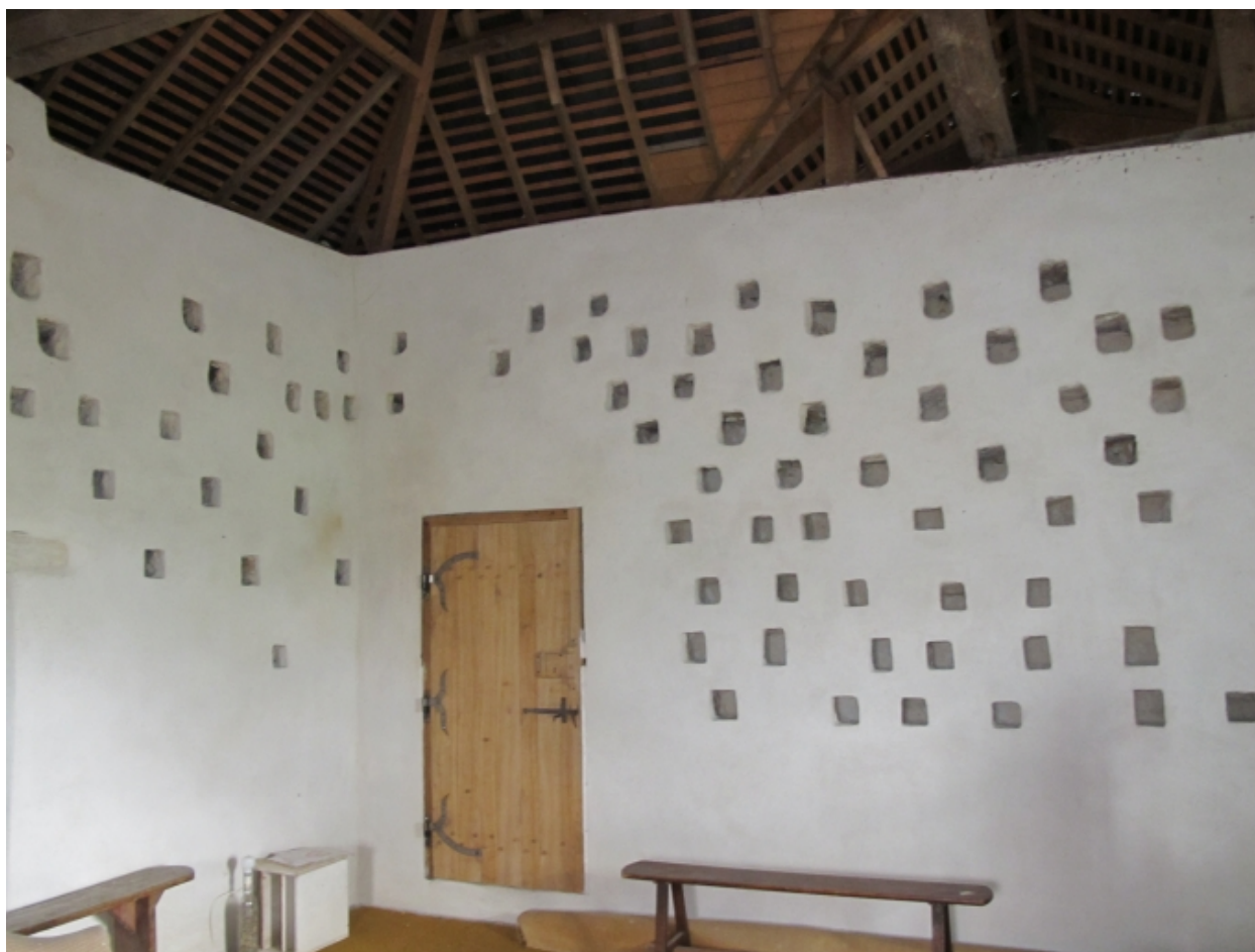
Partie ouest du bâtiment sud-ouest : ancien pigeonnier
