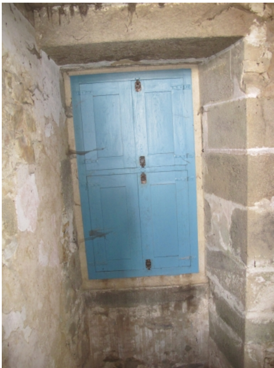
Fenêtre située dans la montée de l'escalier
