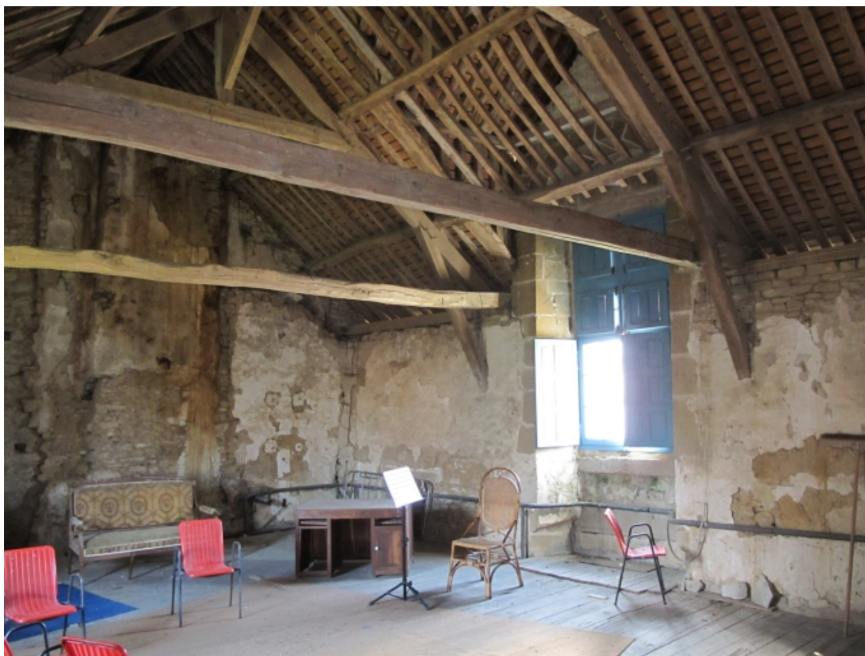
Salle de la partie Est du logis
