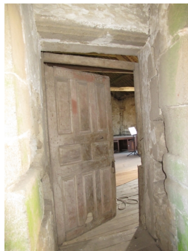
Accès à la pièce Est de l'étage du logis Phot. Sabrina Dalibard IVR53_20113506102NUCA
