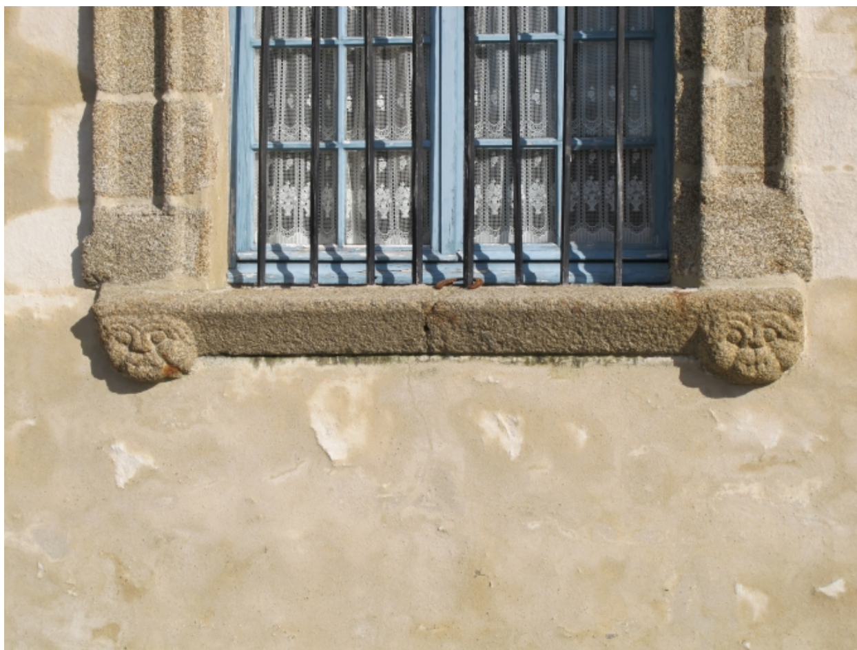
Détail de la fenêtre de la façade sud du logis
