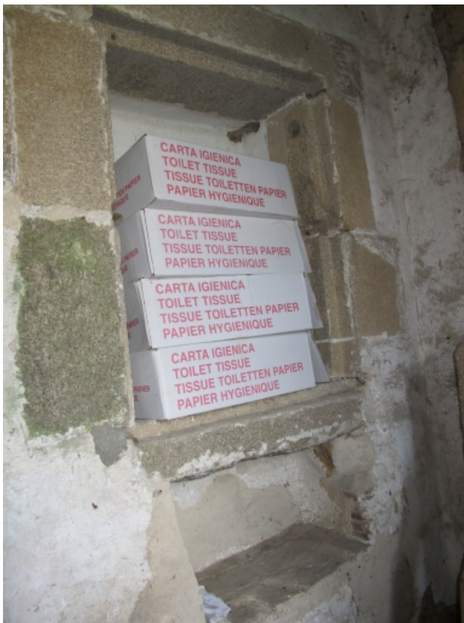
Placard situé dans le cabinet de l'étage du logis
