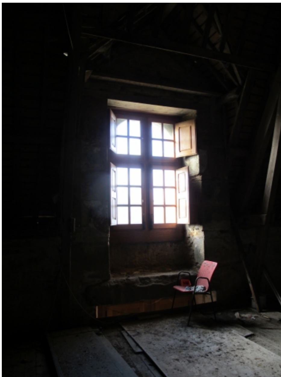
Lucarne du comble du pavillon
