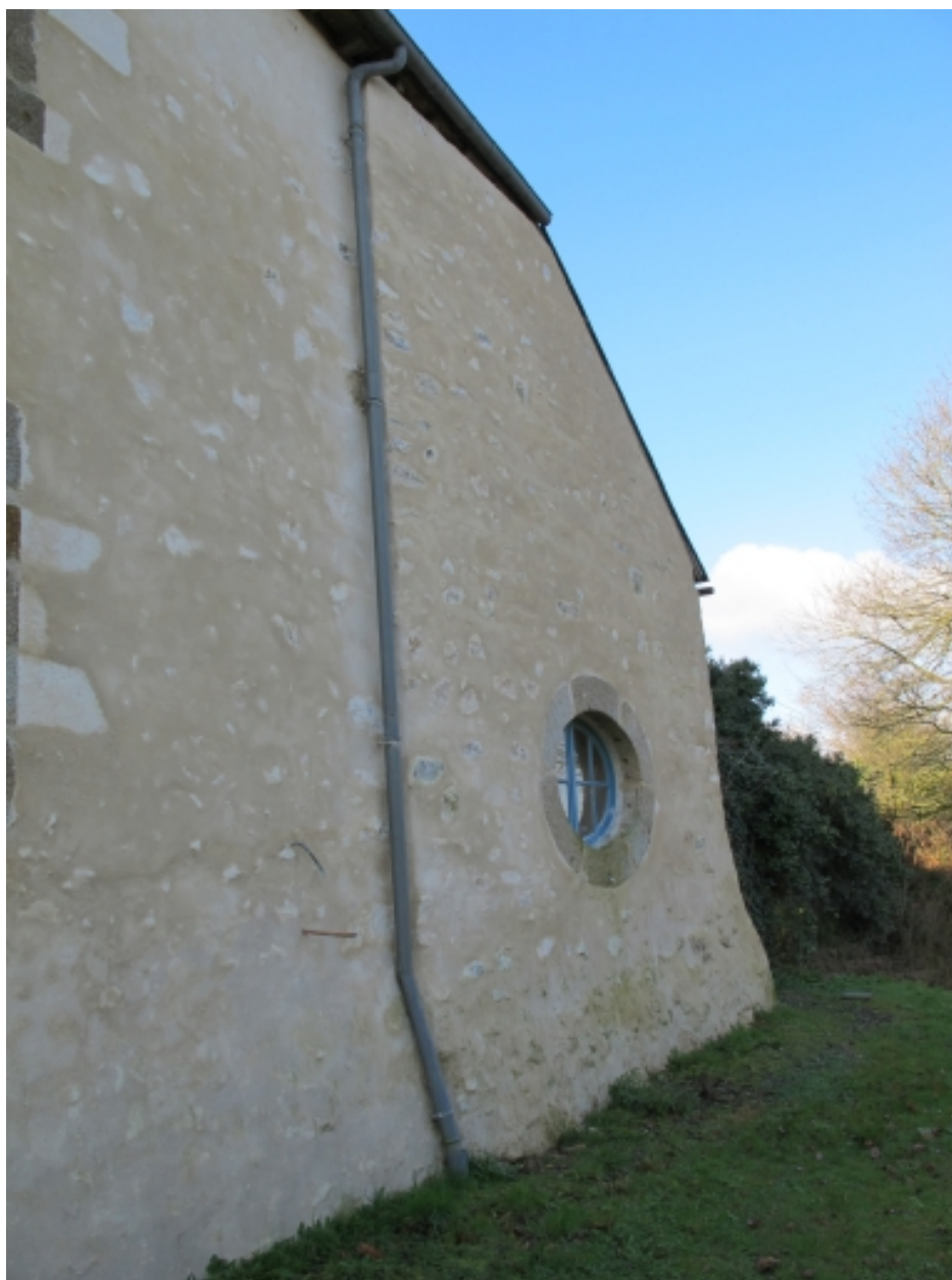
Façade nord du logis, partie ouest
