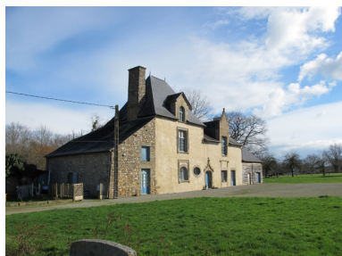
Vue générale sud-ouest Phot. Sabrina Dalibard IVR53_20113506075NUCA
