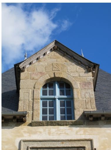
Détail de la lucarne Phot. Sabrina Dalibard IVR53_20113506085NUCA
