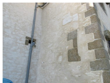
Façade nord du logis Phot. Sabrina Dalibard IVR53_20113506094NUCA
