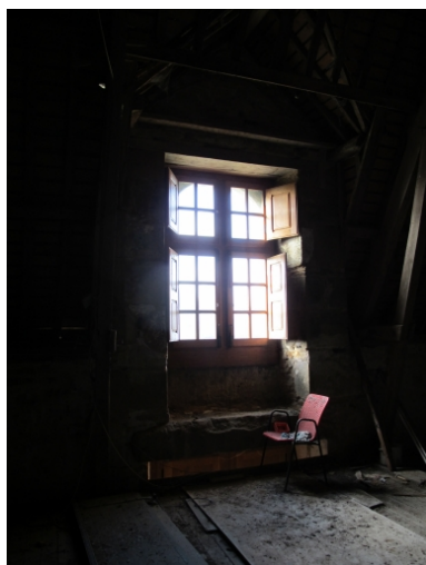
Lucarne du comble du pavillon Phot. Sabrina Dalibard IVR53_20113506106NUCA
