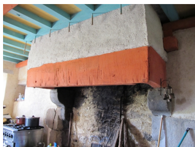
Cheminée du rez-de-chaussée située en partie est du bâtiment sud-ouest Phot. Sabrina Dalibard IVR53_20113506074NUCA
