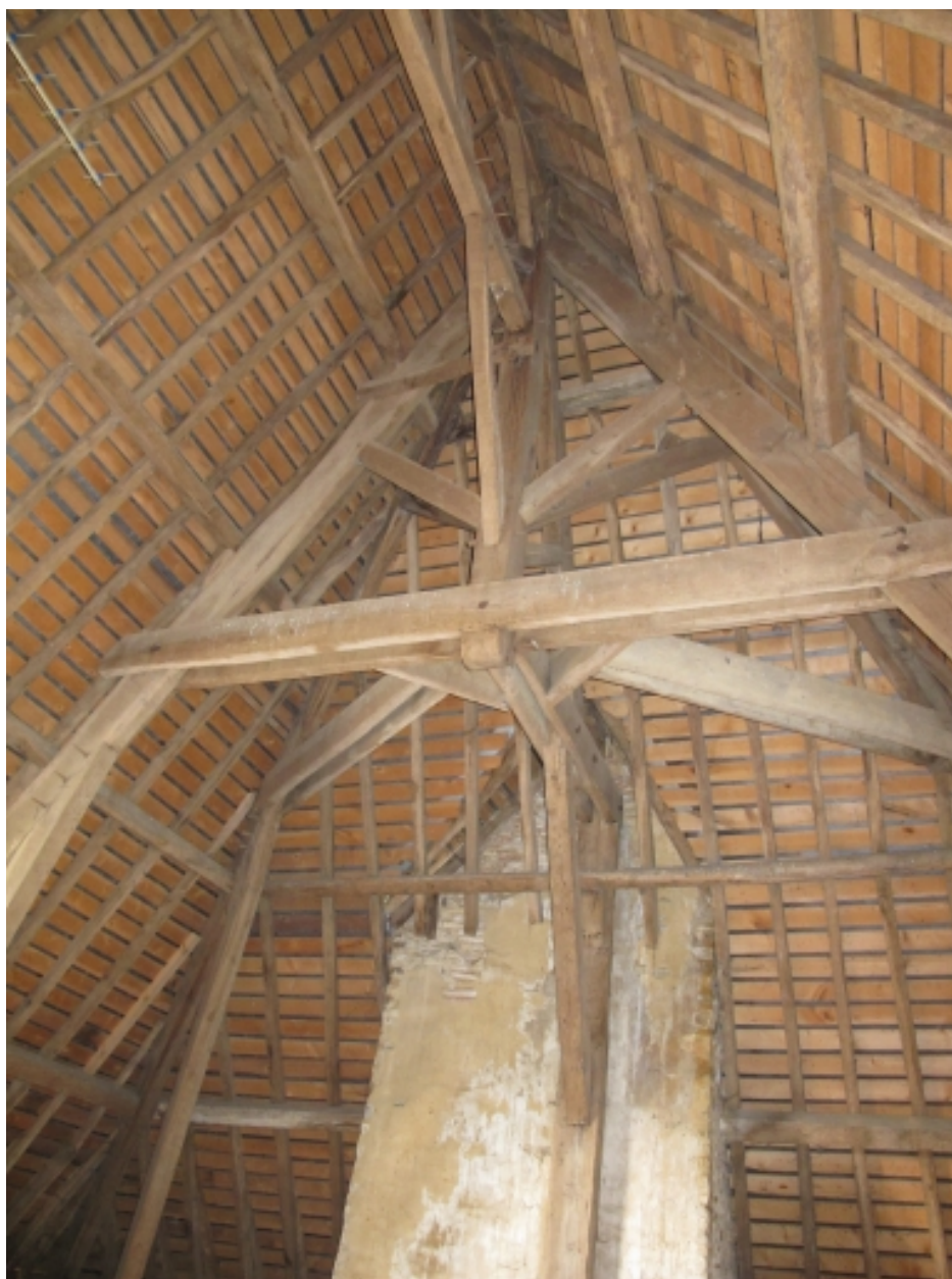
Charpente du pavillon du logis
