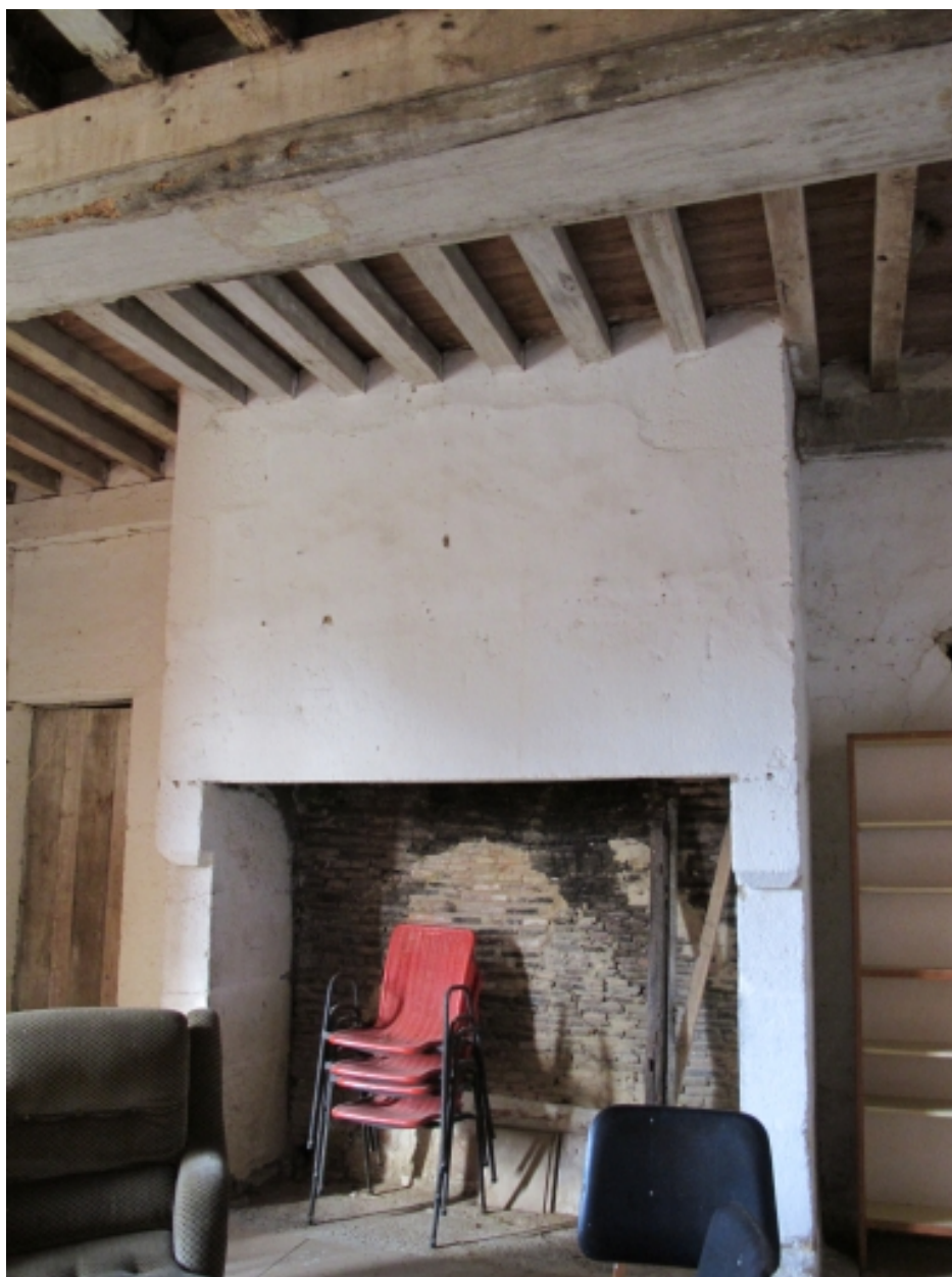
Cheminée de l'étage du logis
