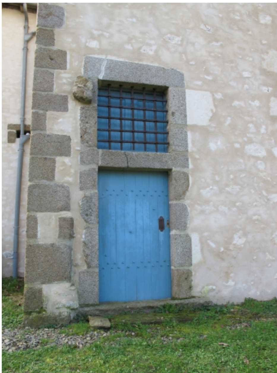
Porte de la façade nord du logis
