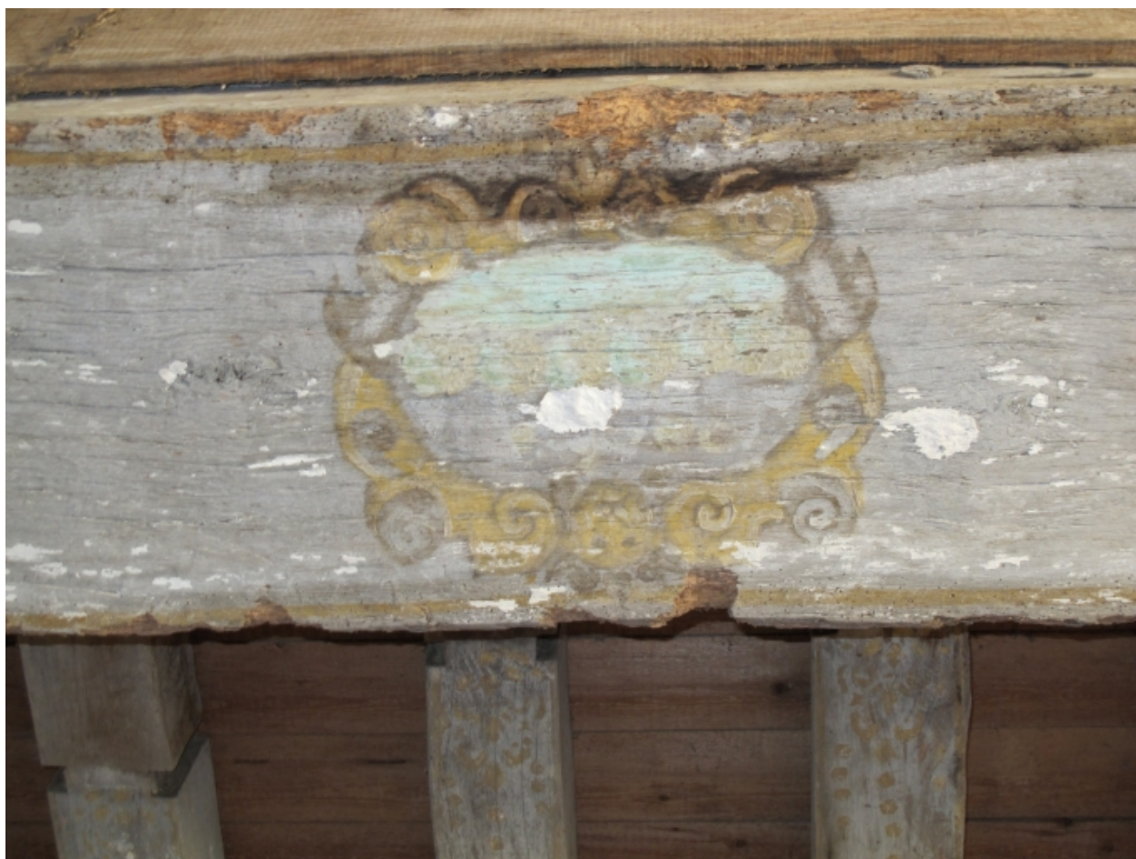
Poutre de l'étage du logis
