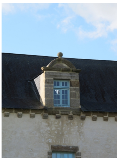
Lucarne de la façade nord du bâtiment sud-ouest Phot. Sabrina Dalibard IVR53_20113506079NUCA
