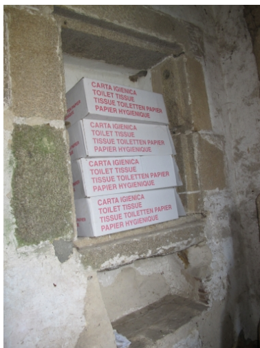
Placard situé dans le cabinet de l'étage du logis Phot. Sabrina Dalibard IVR53_20113506101NUCA
