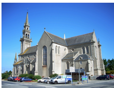
Kerlouan, église paroissiale : vue générale sud-est Phot. Gwénaél Fauchille IVR53_20082906284NUCA
