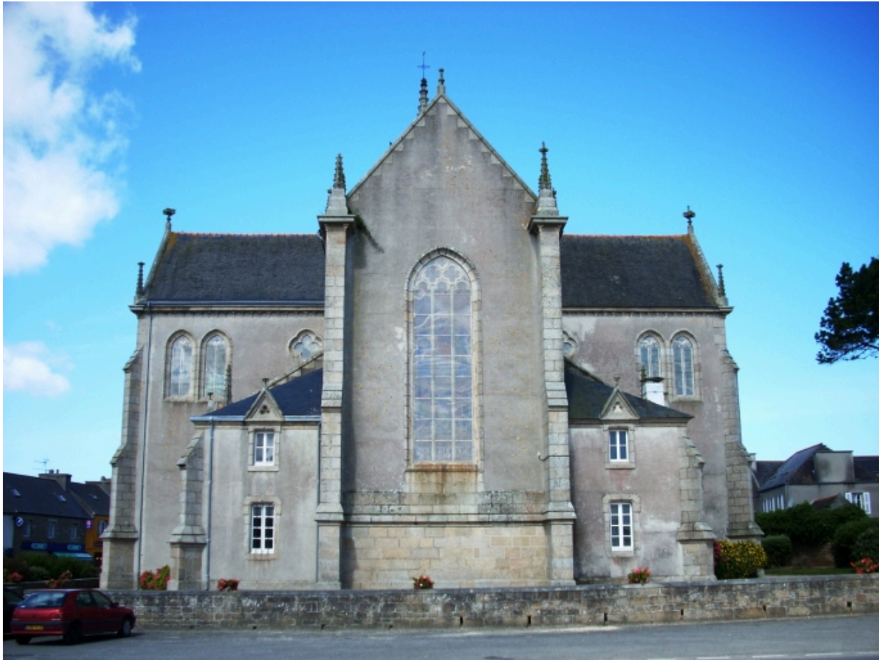
Kerlouan, église paroissiale : élévation est
