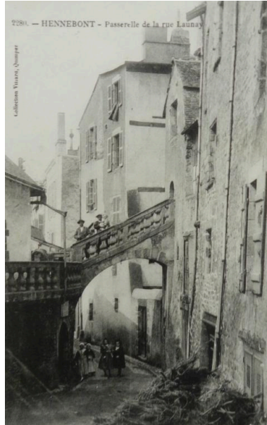
Passerelle Launay au début du XXe siècle détruite suite aux bombardements d'août 1944 Phot. Pierre Laurent Constantin IVR53_20225605159NUCA
