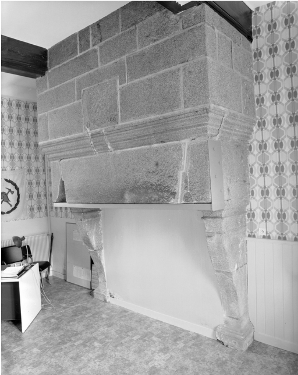
Vue générale de la cheminée du rez-de-chaussée.
