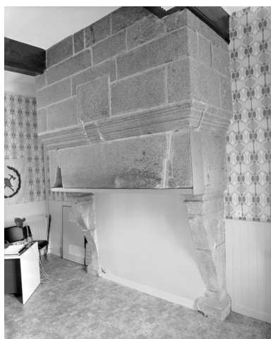
Vue générale de la cheminée du rez-de-chaussée. Phot. Guy Artur IVR53_19783500276X
