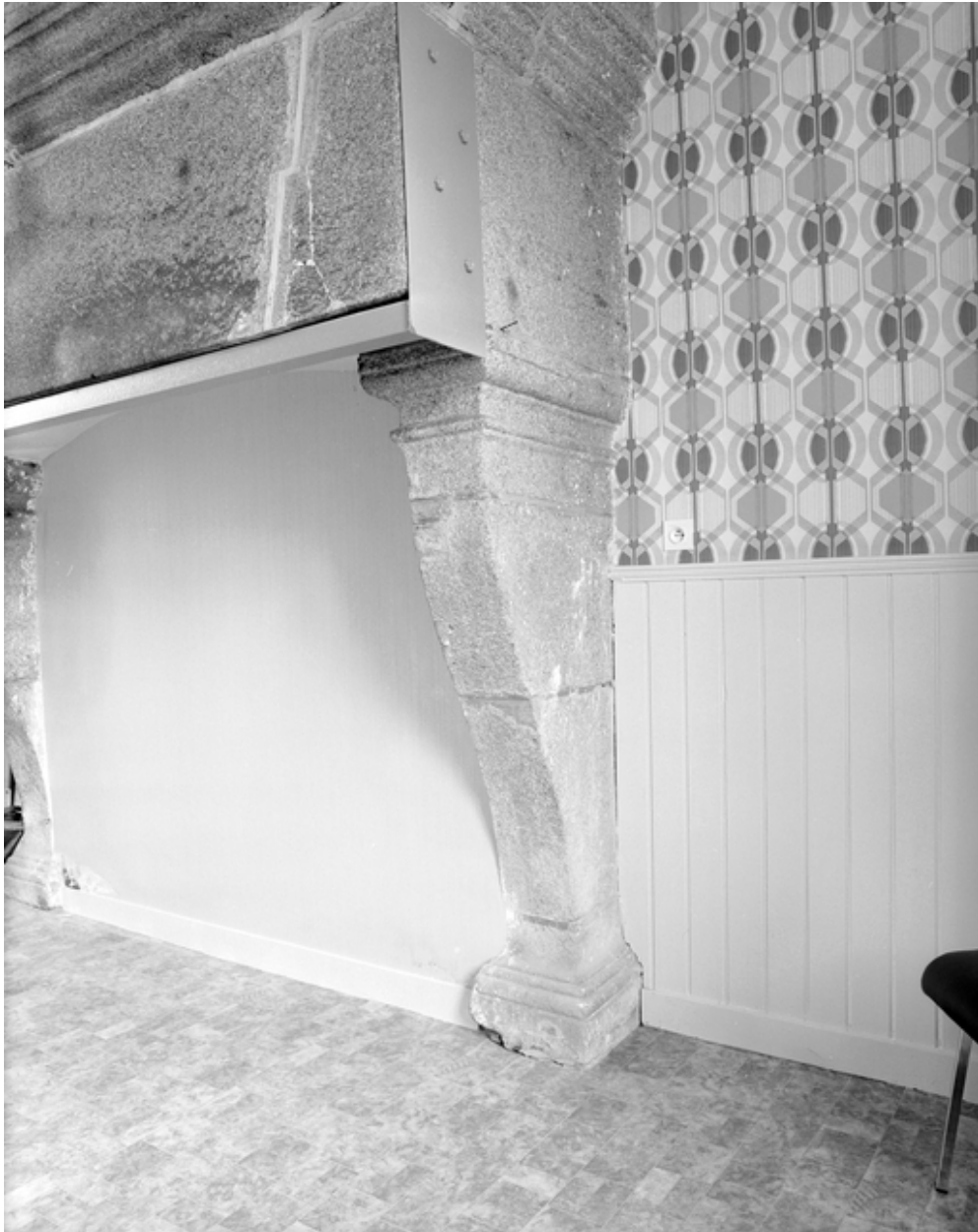
Vue de détail d'un piedroit de la cheminée du rez-de-chaussée.
