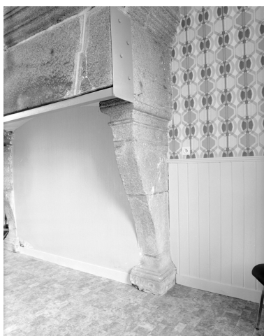
Vue de détail d'un piedroit de la cheminée du rez-de-chaussée. Phot. Guy Artur IVR53_19783500277X
