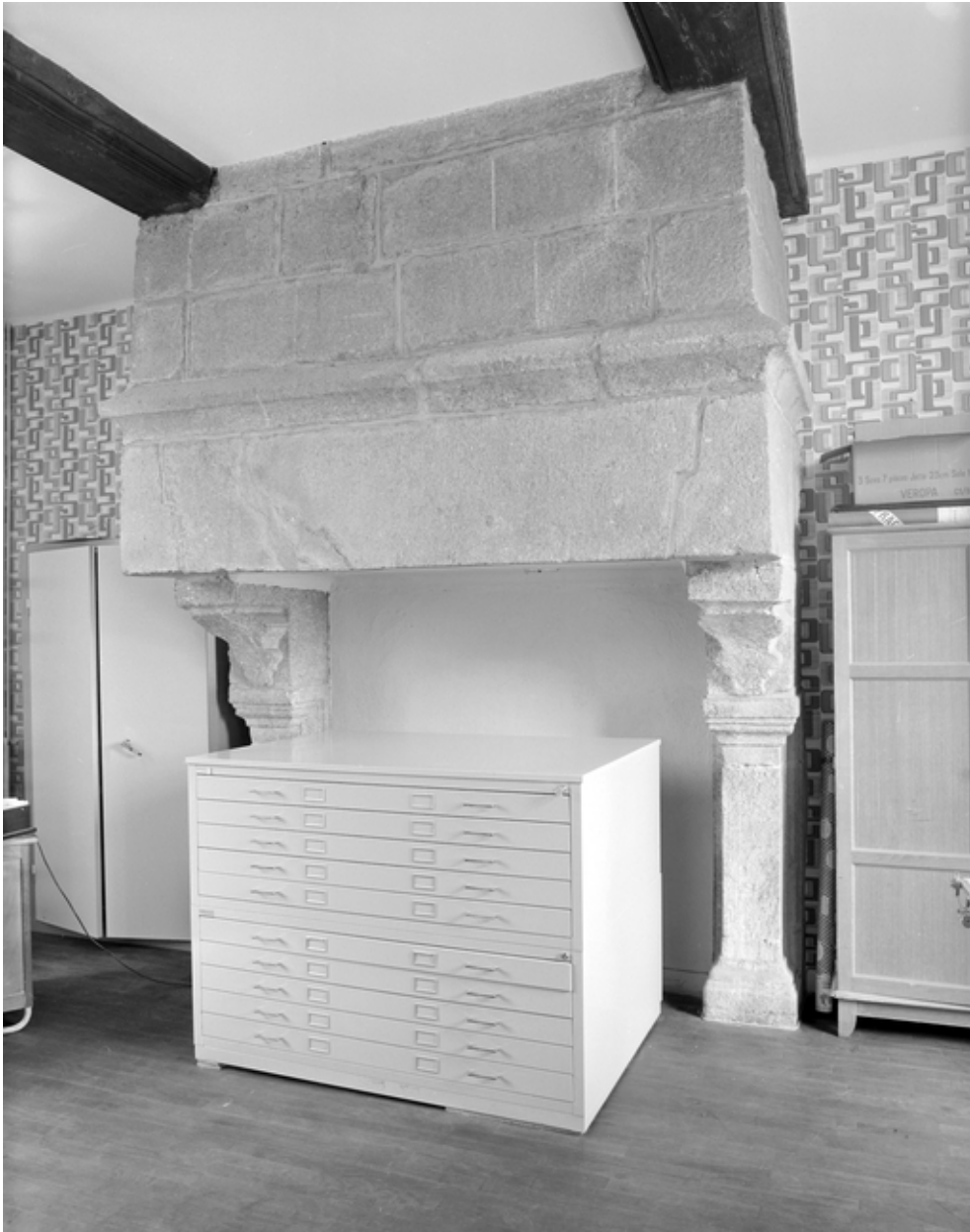
Vue générale de la cheminée de l'étage.
