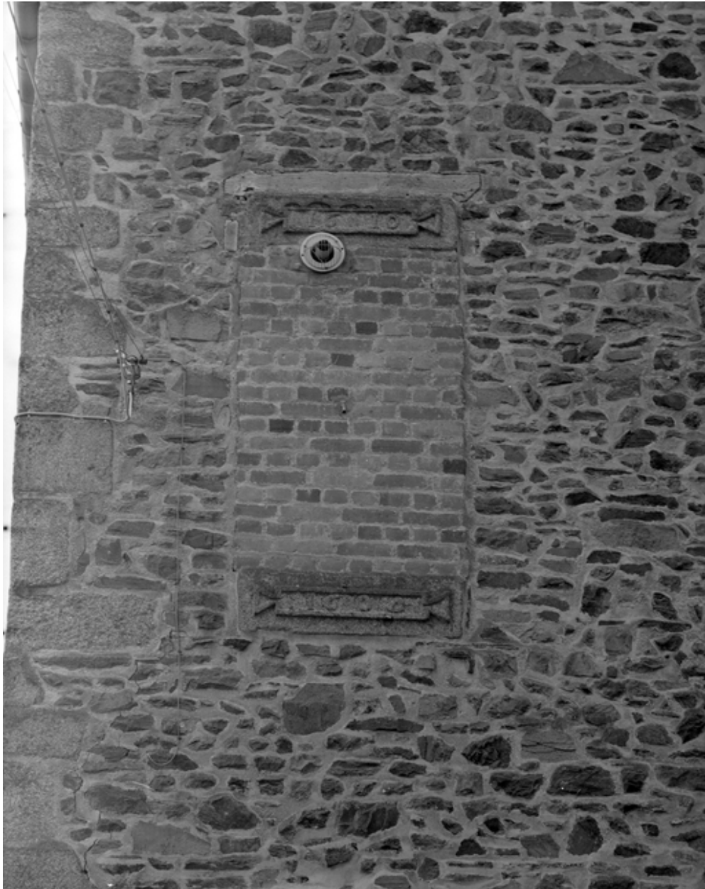
Vue de détail de la fenêtre datée de 1600 et 1610 sur le pignon nord.
