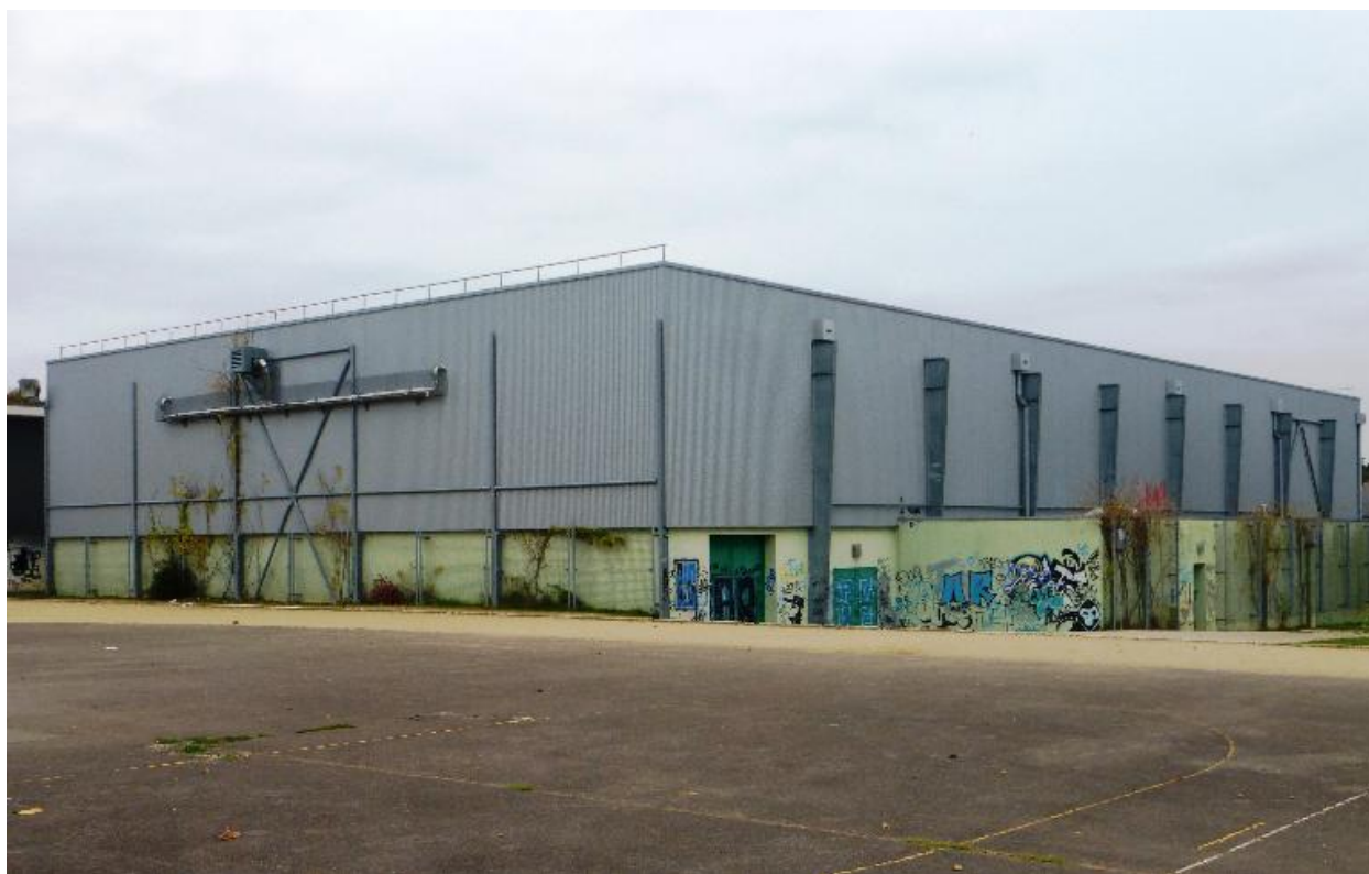
Salle Colette Besson vue du sud-est
