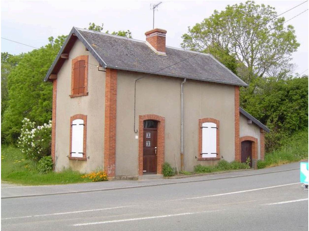
Maison du garde-barrières
