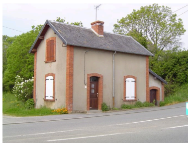
Maison du garde-barrières Phot. Clotilde Buhot IVR53_20062908579NUCA
