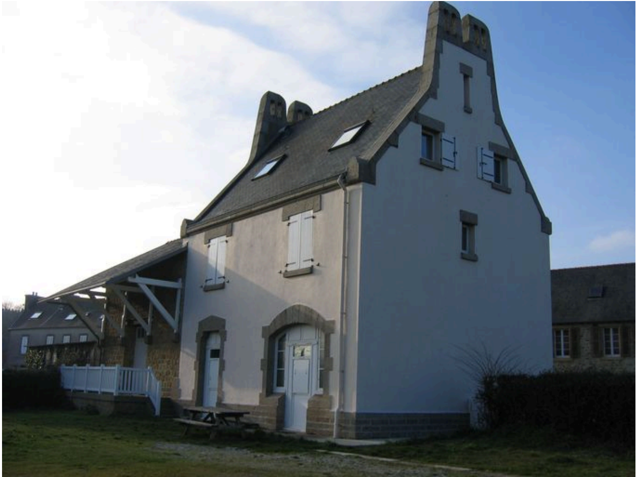
Vue générale de la gare du Fret
