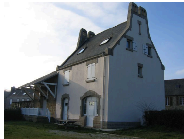
Vue générale de la gare du Fret Phot. Françoise Péron IVR53_20062908559NUCA
