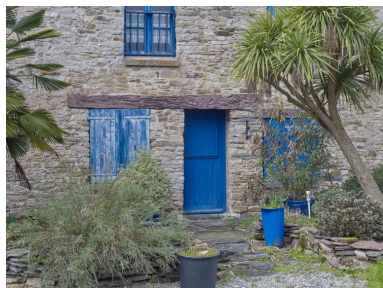
Détails de la façade est de la maison avec un linteau filant, 32 la Violais Phot. Bernard Bègne IVR53_20263500506NUCA
