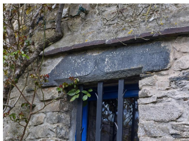
Linteau en schiste avec arc en accolade, 32 la Violais Phot. Bernard Bègne IVR53_20263500508NUCA
