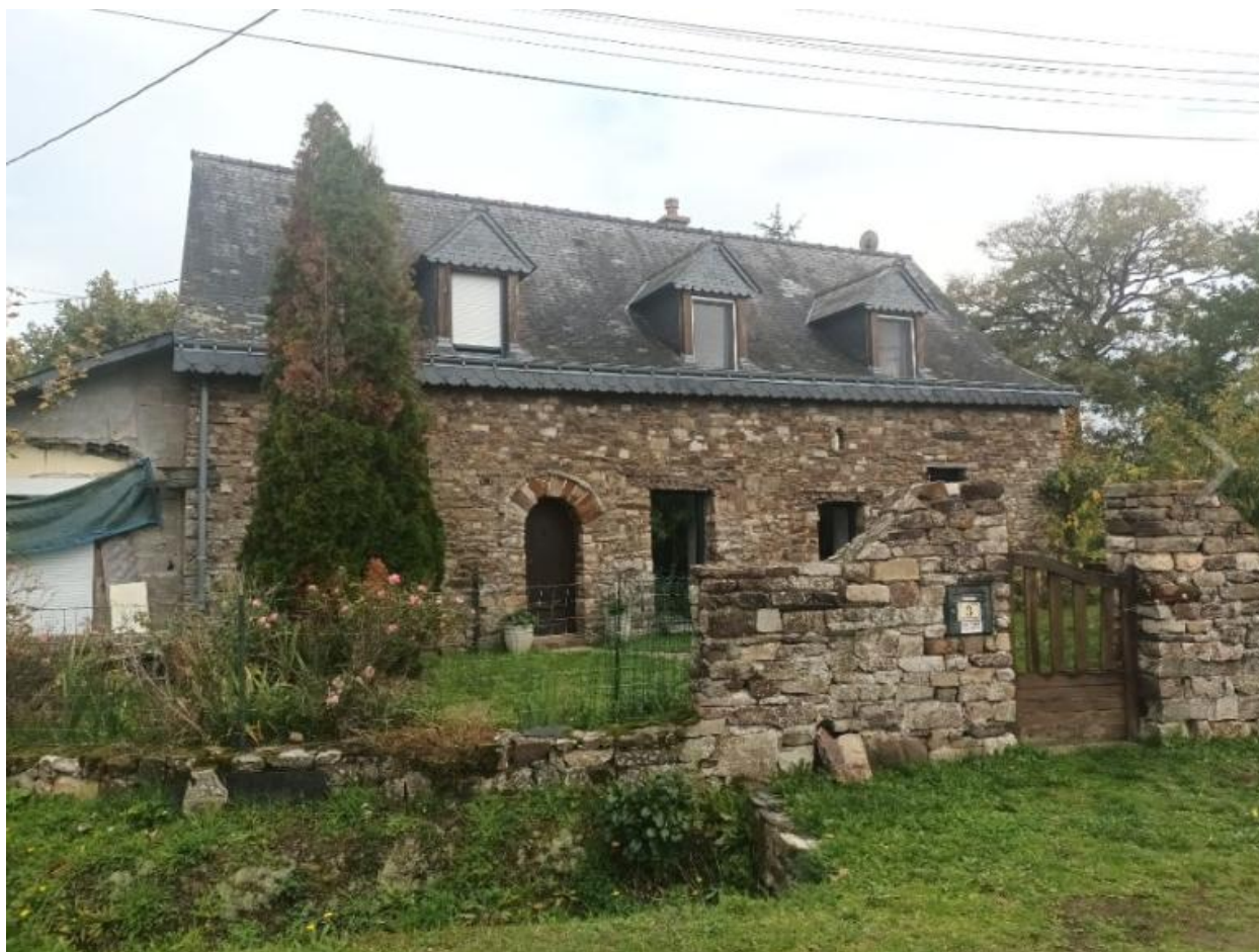
Façade avec porte à larmier, 3 la Gandouflais
