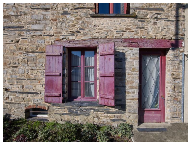
Linteau filant façade est, place de l'Eglise Phot. Bernard Bègne IVR53_20263500384NUCA
