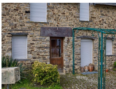
Détail de la façade est, linteau en schiste, 28 la Violais Phot. Bernard Bègne IVR53_20263500511NUCA
