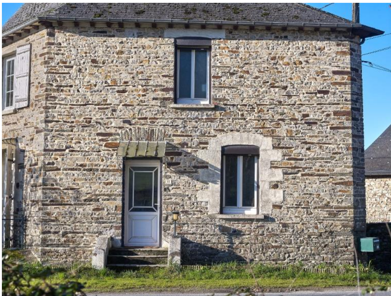
Façade côté route, 1 Roudun
