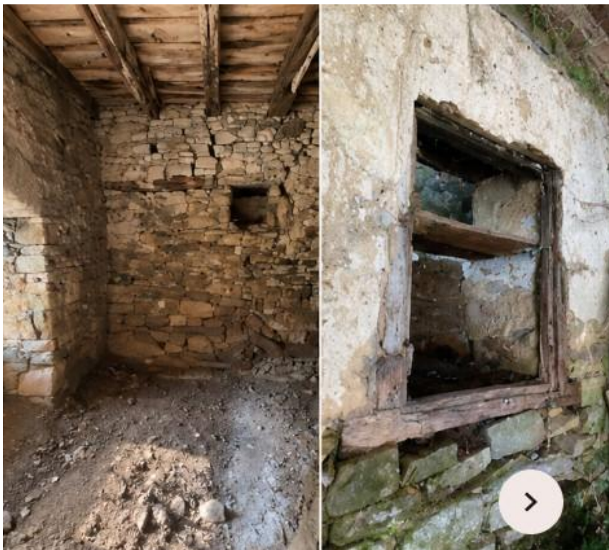
Détails des armoires murales de la Ferme de la Gandouflais
