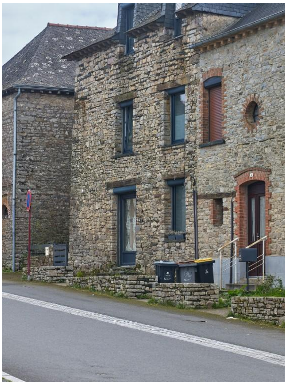
Linteaux en bois et arcs segmentaires en brique, 5 place de l'Eglise
