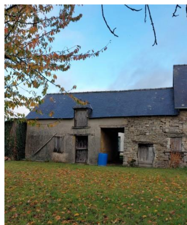
Ferme en terre dans l'écart de Montrou Phot. Cleo Tafial IVR53_20263510463NUCA
