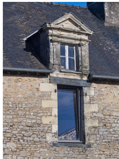
Lucarne d'orgueil du presbytère Phot. Bernard Bègne IVR53_20263500337NUCA
