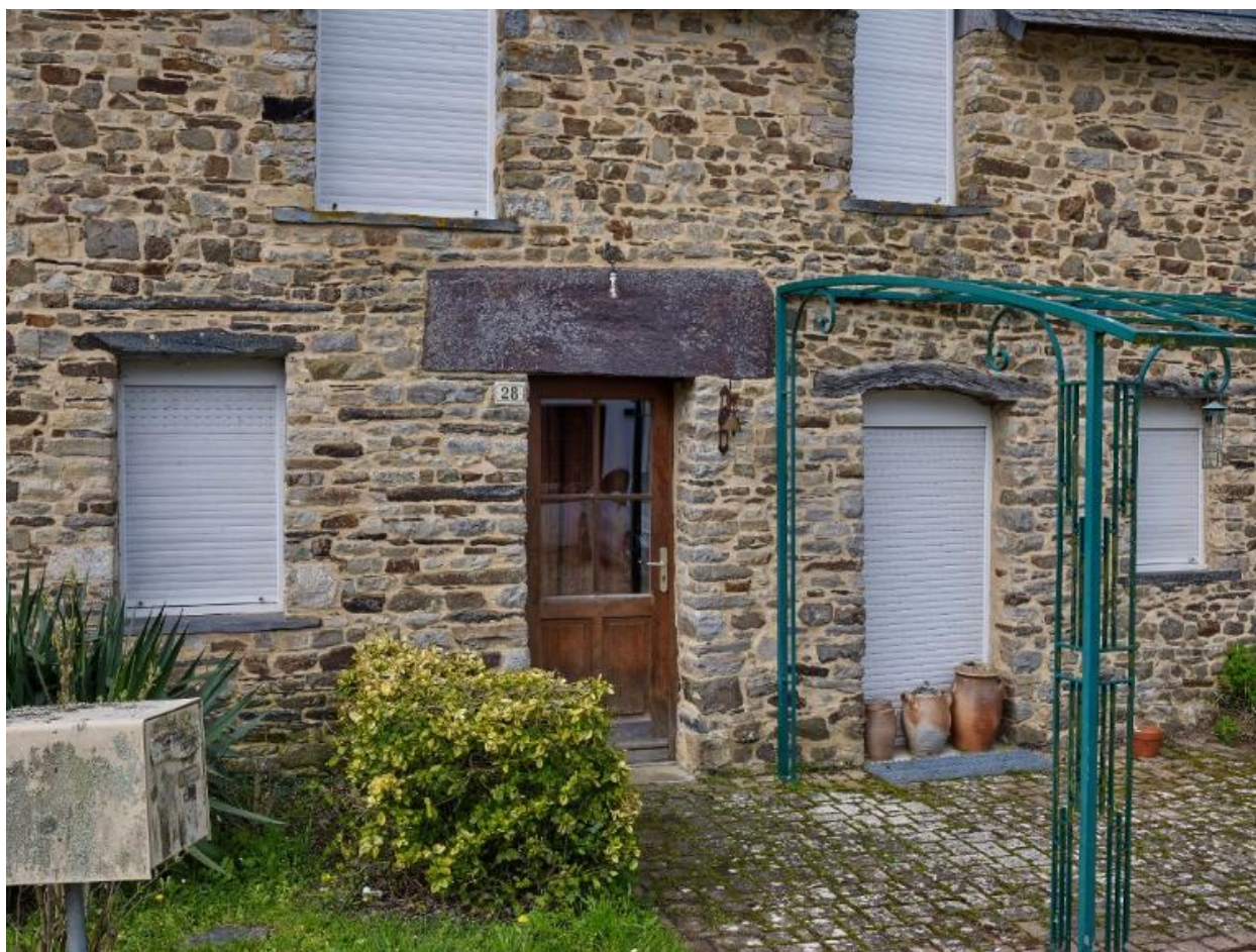
Détail de la façade est , linteau en schiste, 28 la Violais
