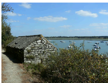
Guérite de douaniers de La Garenne Phot. Johan Vincent IVR53_20075605731NUCA
