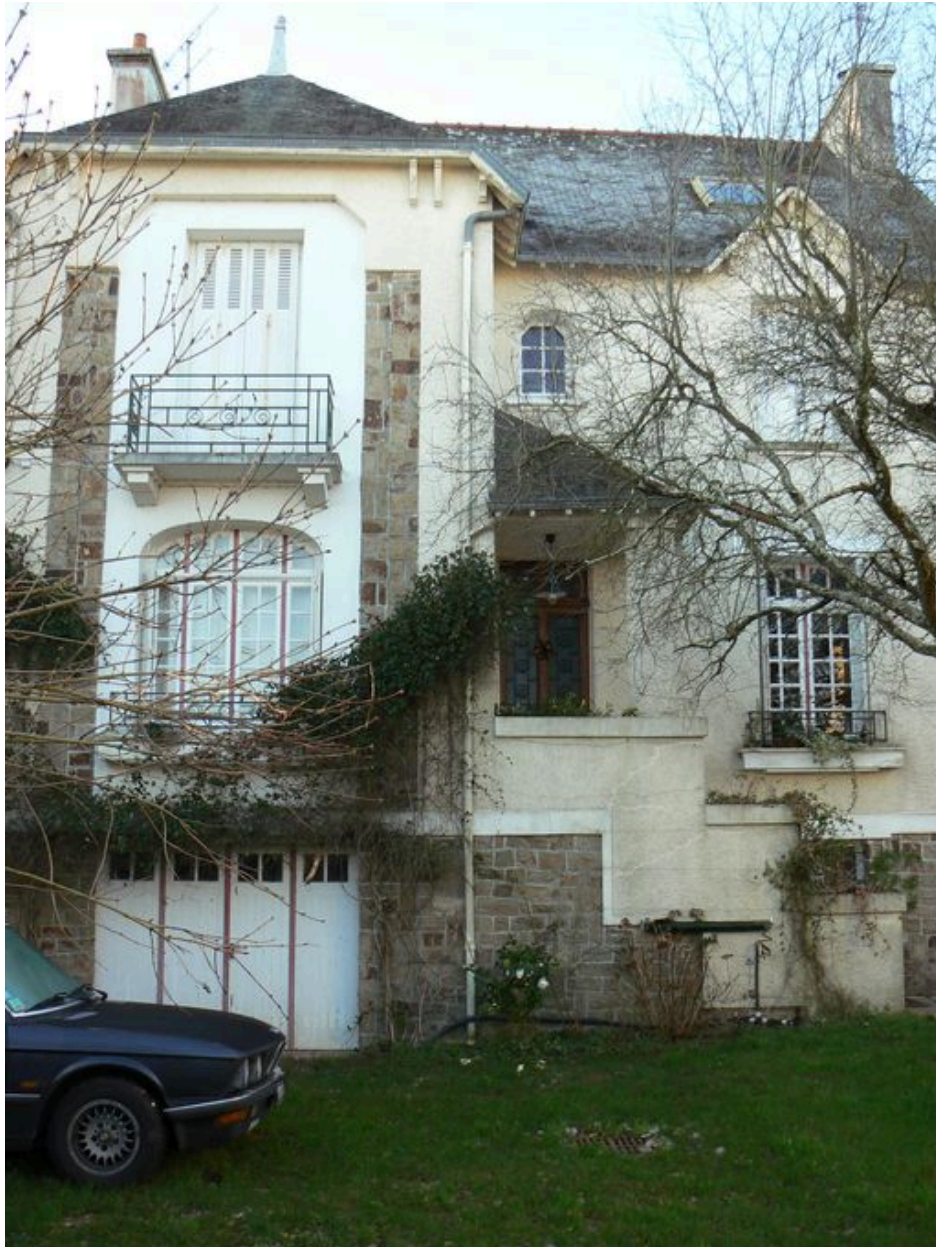
Vue générale de la maison du 69 rue de Bellevue
