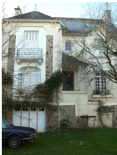
Vue générale de la maison du 69 rue de Bellevue Phot. Johan Vincent IVR53_20075605759NUCA
