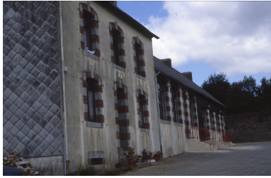
Ecole, vue générale. Phot. Denise Dufief IVR53_19862200733ZA
