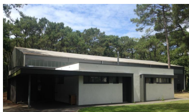
Vue de l'angle sud-ouest. Phot. Thierry Goyet IVR53_20205605137NUCA
