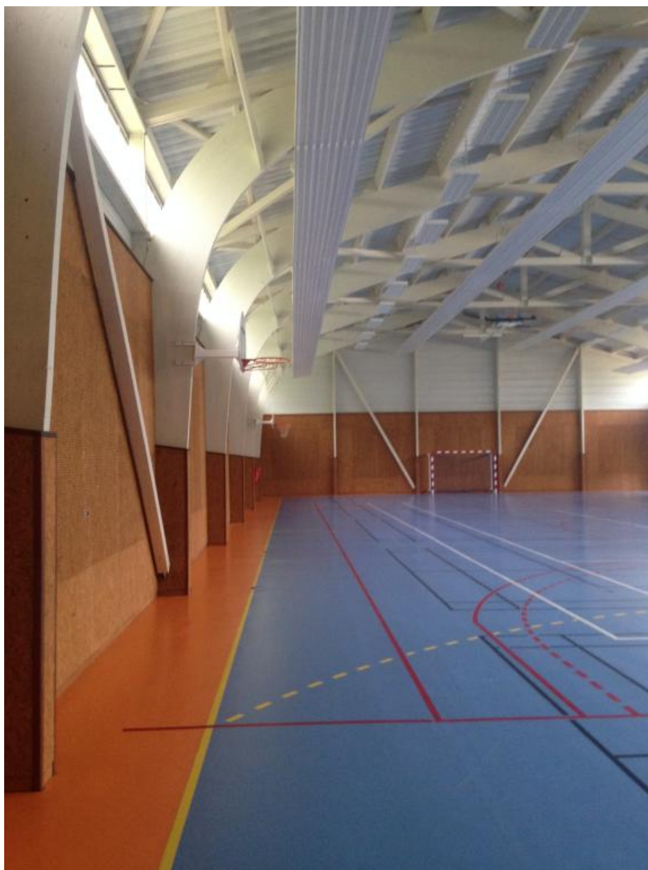
Vue intérieure après restructuration, prise le long de la façade nord. Noter l'ossature d'origine en lamellé collé.
