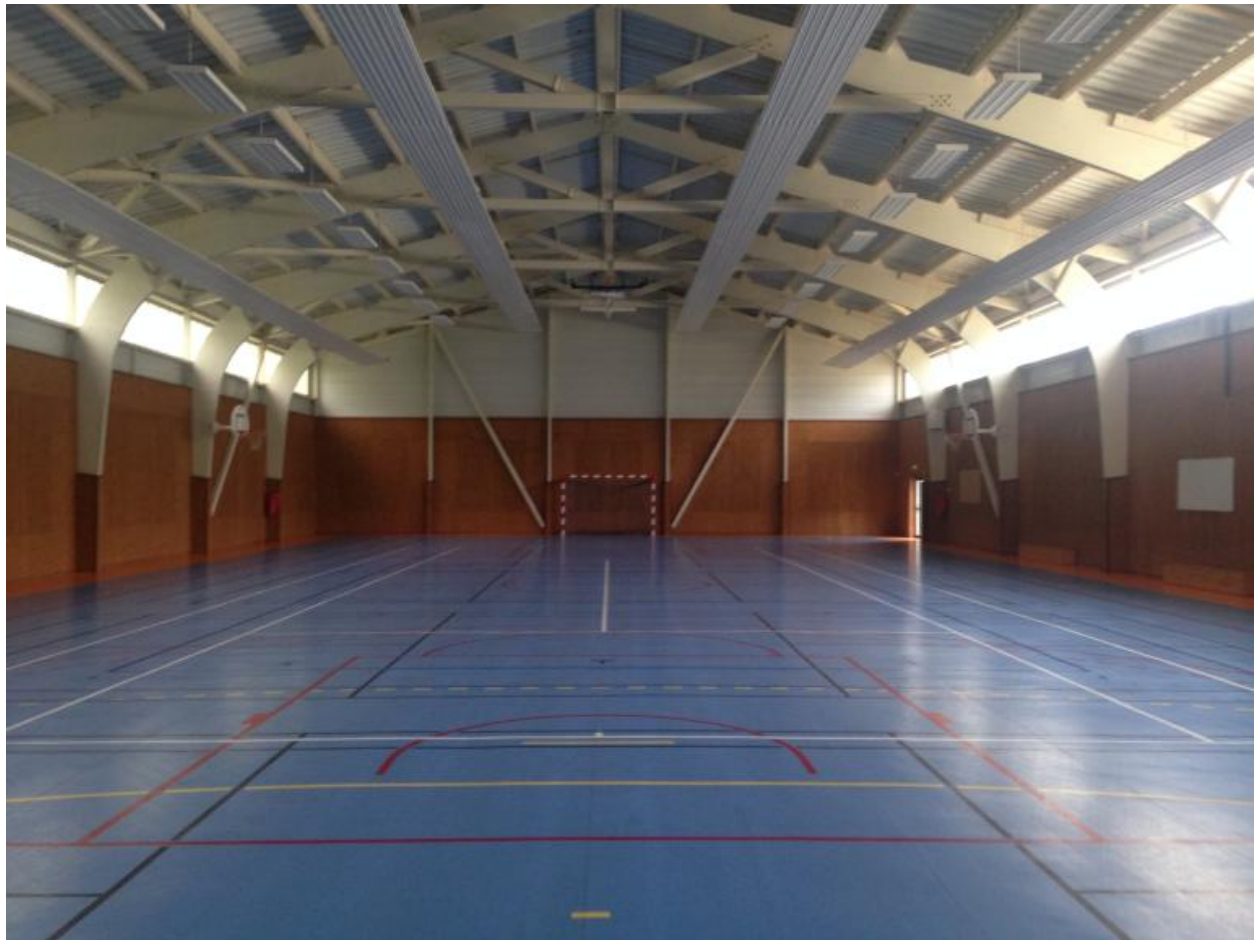
Vue intérieure après restructuration. Noter l'ossature d'origine en lamellé collé.
