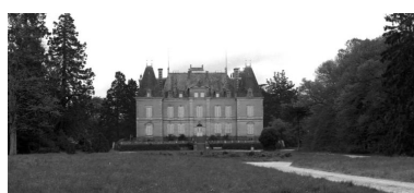
Vue générale du logis. Phot. Jean-Pierre Ducouret IVR53_19833500379Z
