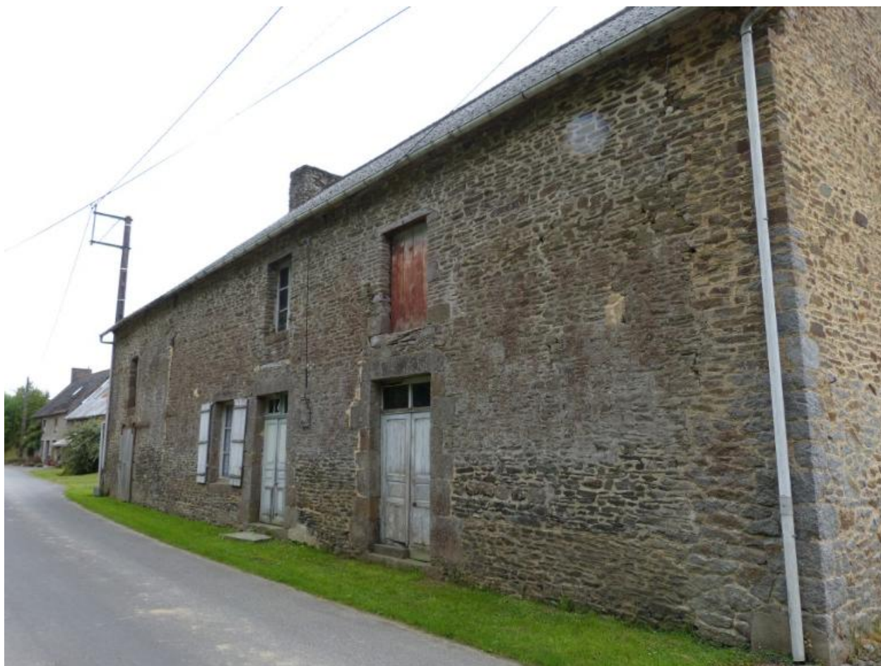
Ferme - Façade principale orientée nord
