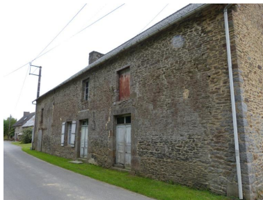
Ferme - Façade principale orientée nord Phot. Marquet Laurence IVR53_20243530318NUCA
