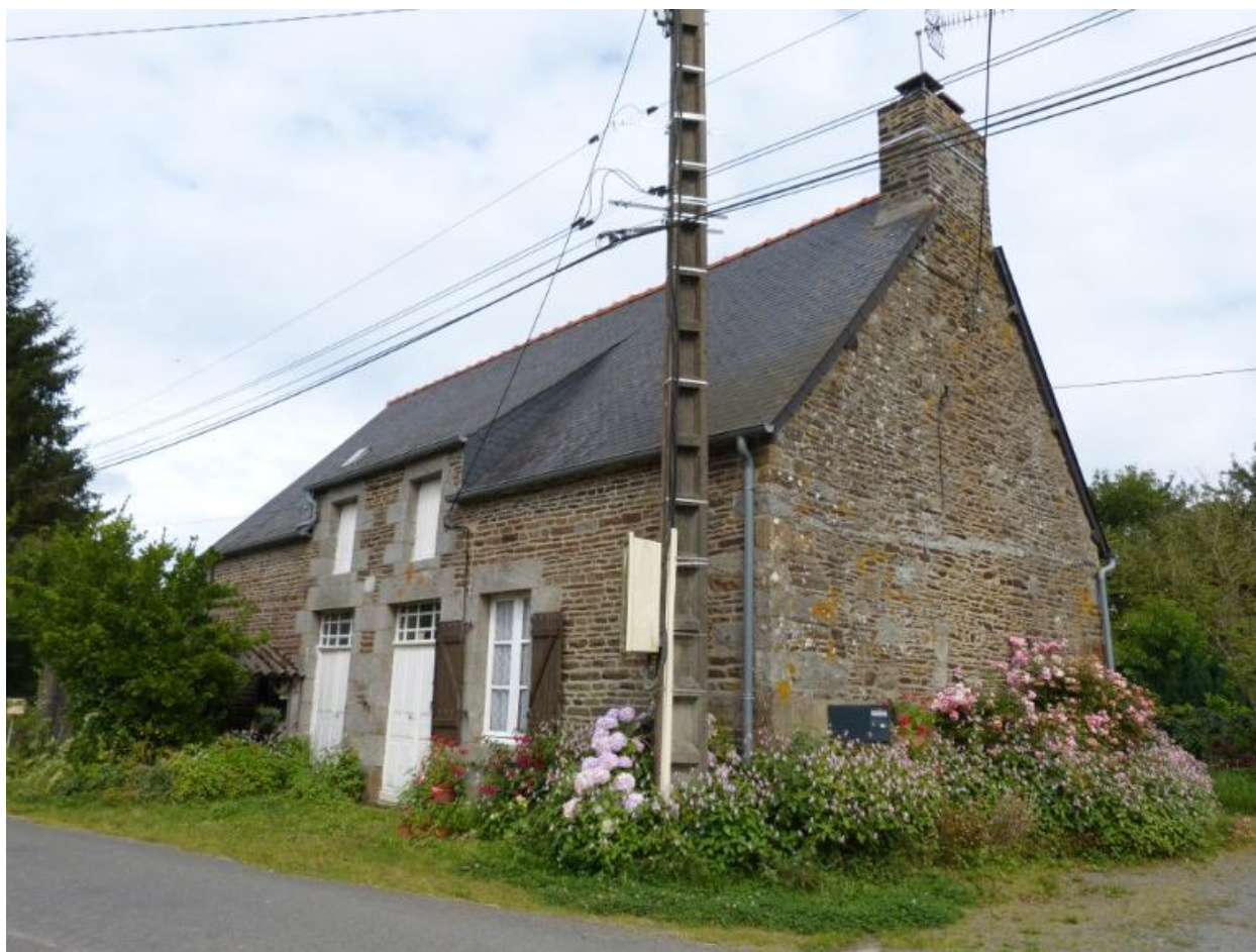
Vue de la façade principale ouest
