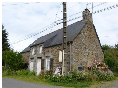
Vue de la façade principale ouest Phot. Marquet Laurence IVR53_20243530328NUCA
