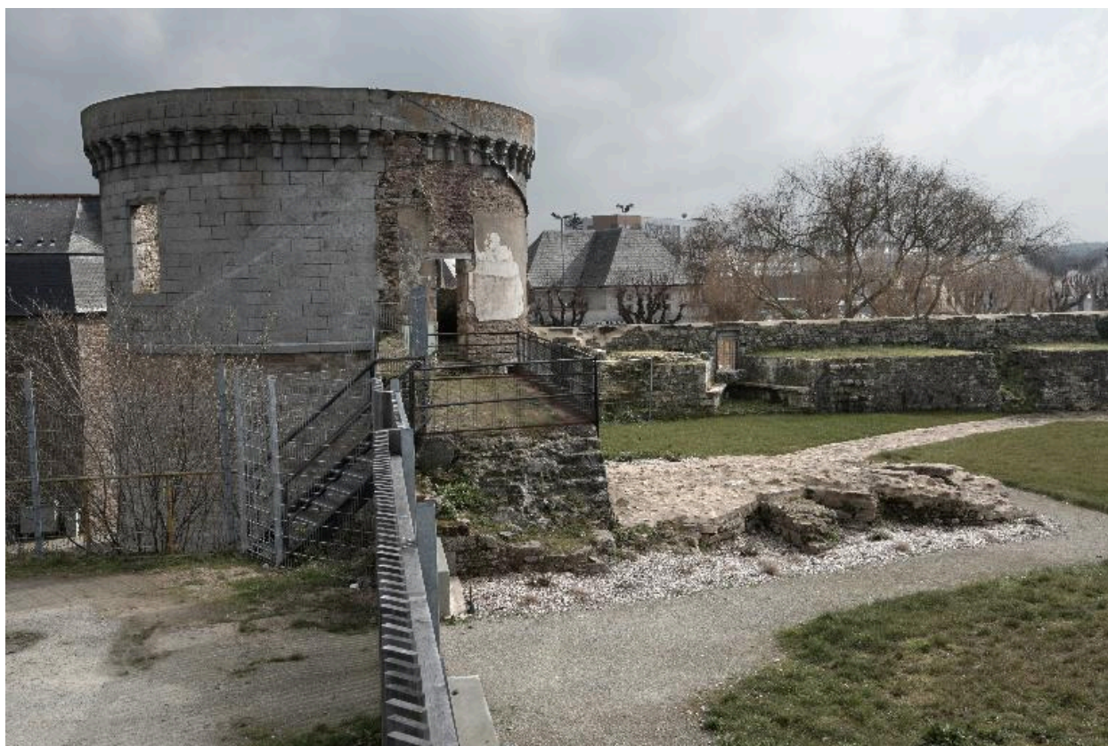
Vue de la tour est du château
