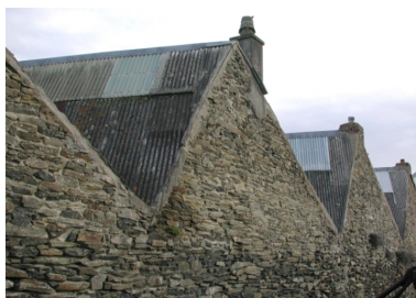
Sheds : toit et couverture de l'ancienne friterie Phot. Guy Prigent IVR53_20042204350NUCA
