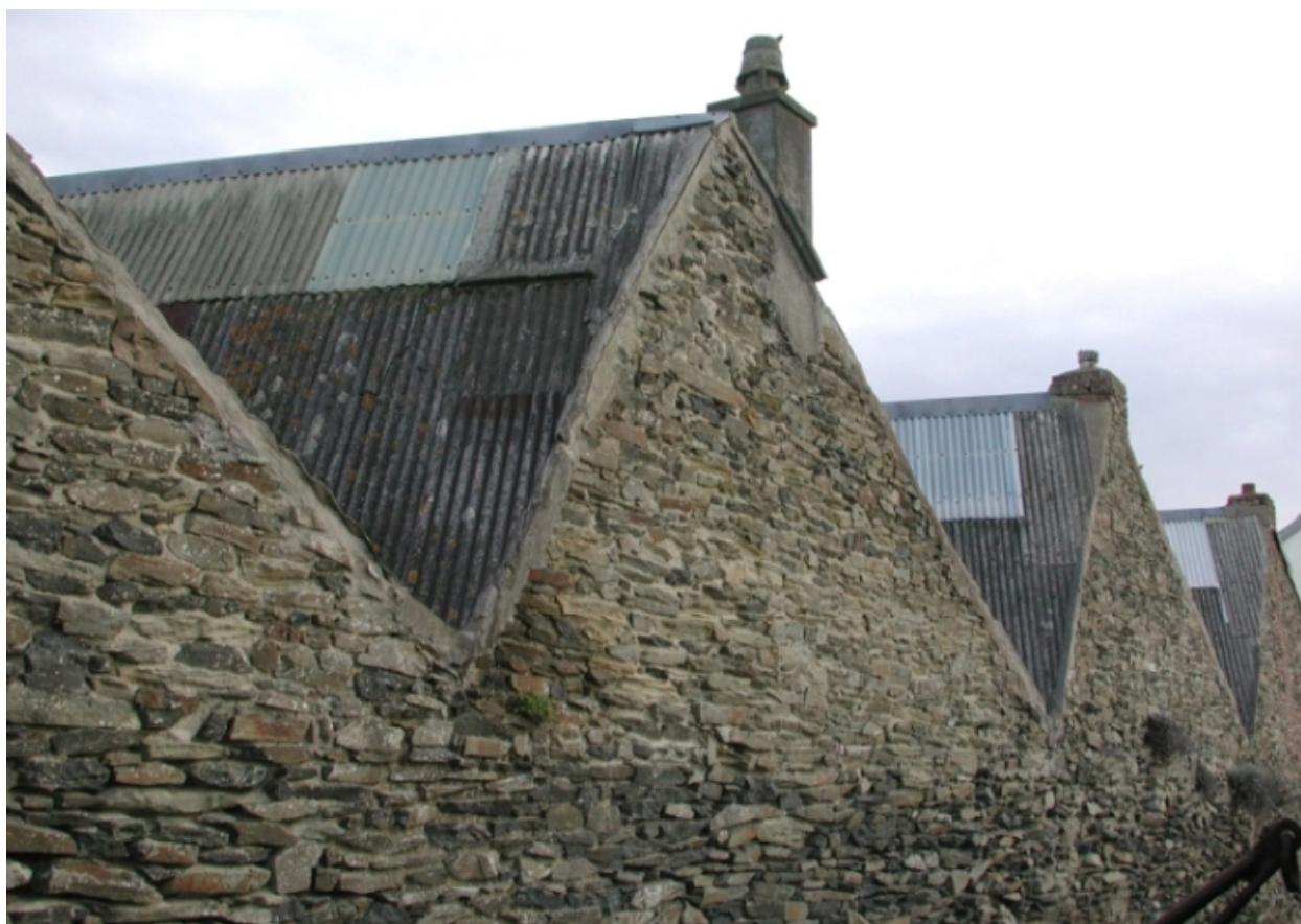
Sheds : toit et couverture de l'ancienne friterie
