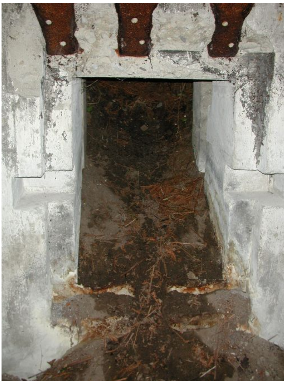
Vue de la sortie de secours de l'abri type tôle métro de la pointe de Perharidi
