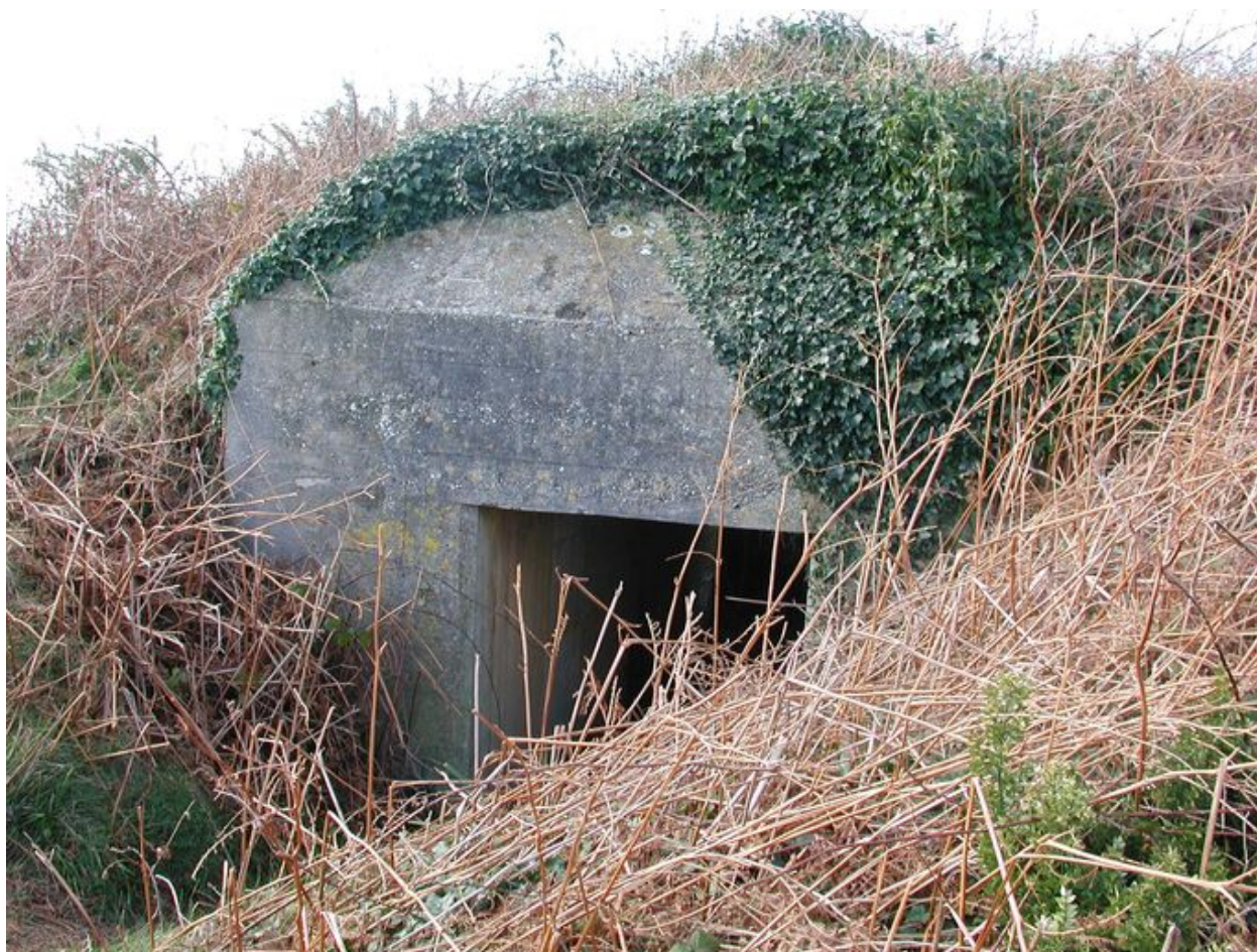
Vue générale de l'entrée sud de l'abri type tôle métro de la pointe de Perharidi
