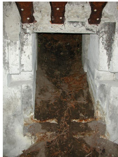
Vue de la sortie de secours de l'abri type tôle métro de la pointe de Perharidi Phot. Guillaume Lécueillier IVR53_20022901706NUCA
