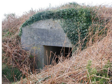
Vue générale de l'entrée sud de l'abri type tôle métro de la pointe de Perharidi Phot. Guillaume Lécueillier IVR53_20022901704NUCA
