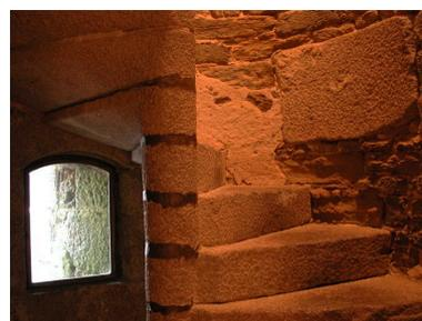
Vue de l'escalier à vis desservant les parties hautes et logé dans le saillant arrière
