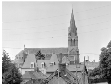
Elévation est : vue générale Phot. Guy Artur, Phot. Norbert Lambart IVR53_19943501410X
