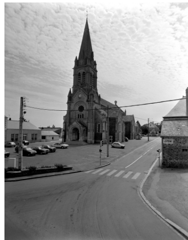
Elévation nord : vue générale Phot. Guy Artur, Phot. Norbert Lambart IVR53_19943501412X
