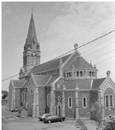
Elévation sud : vue générale Phot. Guy Artur, Phot. Norbert Lambart IVR53_19943501411X
