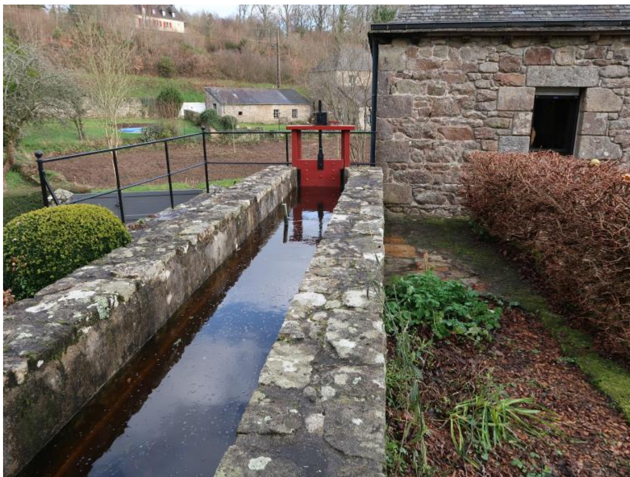
Loguivy-Plougras, le bourg : Moulin à eau de Traou an Dour, rigole du canal d'amenée située au-dessus de la roue à aubes
