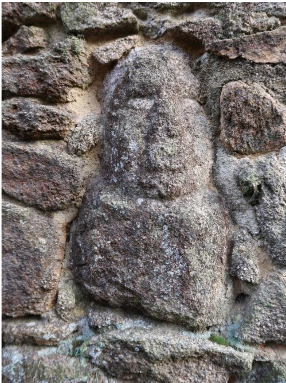
Loguivy-Plougras, le bourg : Moulin à eau de Traou an Dour, élévation ouest, détail d'un remploi intégré à la maçonnerie (tête sculptée dans du granite)
