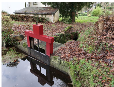
Loguivy-Plougras, le bourg : Moulin à eau de Traou an Dour, entrée de la rigole du canal d'amenée (vanne permettant de réguler ou fermer l'alimentation en eau depuis l'étang) Phot. Guillaume Lécueillier IVR53_20192205287NUCA
