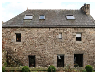
Loguivy-Plougras, le bourg : Moulin à eau de Traou an Dour, élévation ouest Phot. Guillaume Lécueillier IVR53_20192205291NUCA
