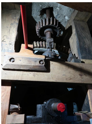
Loguivy-Plougras, le bourg : Moulin à eau de Traou an Dour, détail des mécanismes de transmission (arbre de la roue, rouet à alluchons) Phot. Guillaume Lécueillier IVR53_20192205296NUCA
