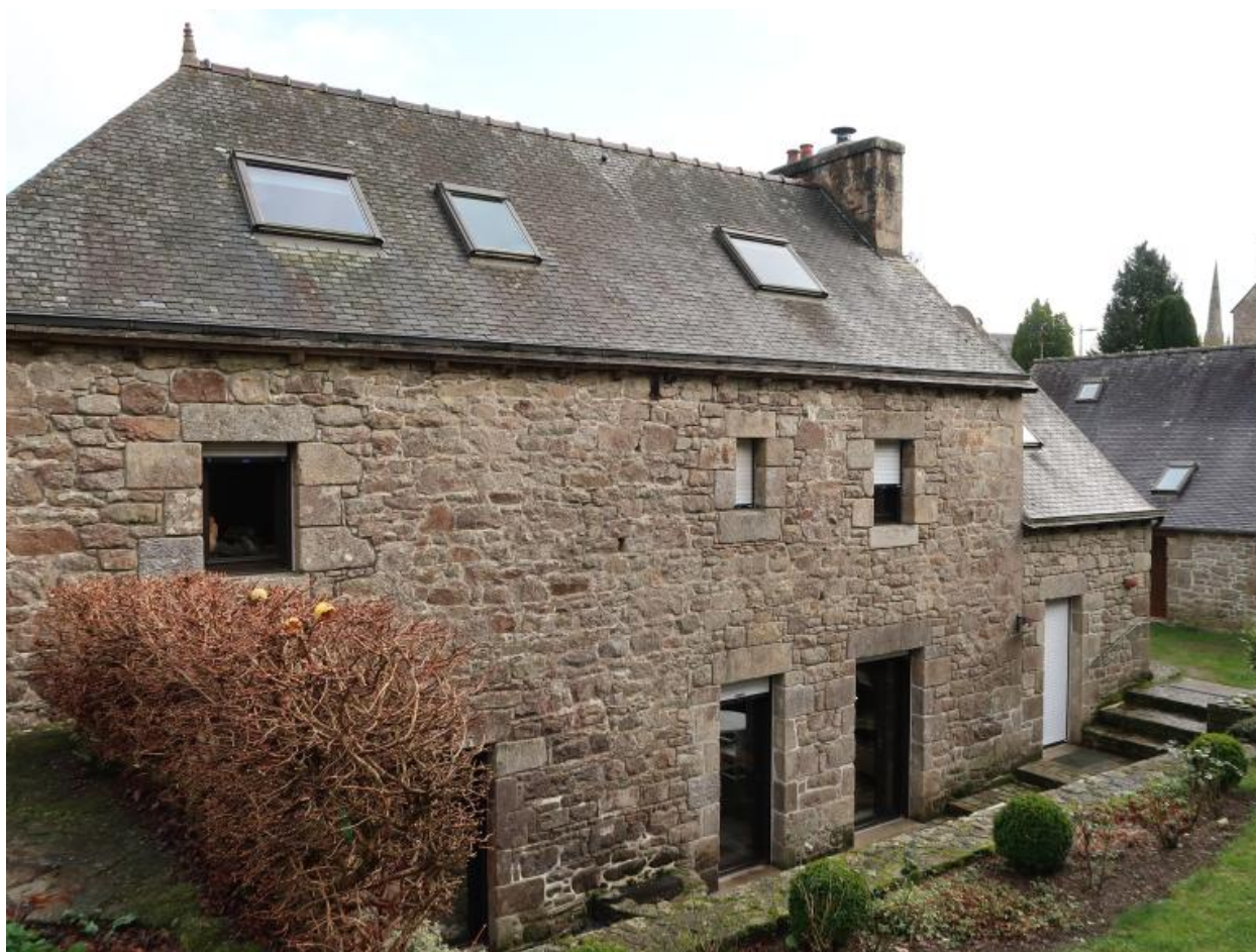
Loguivy-Plougras, le bourg : Moulin à eau de Traou an Dour, vue générale depuis l'ouest
