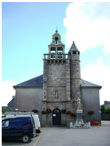
Lannéanou, église paroissiale Saint-Jean-Baptiste : élévation ouest Phot. Gwénaél Fauchille IVR53_20082906675NUCA
