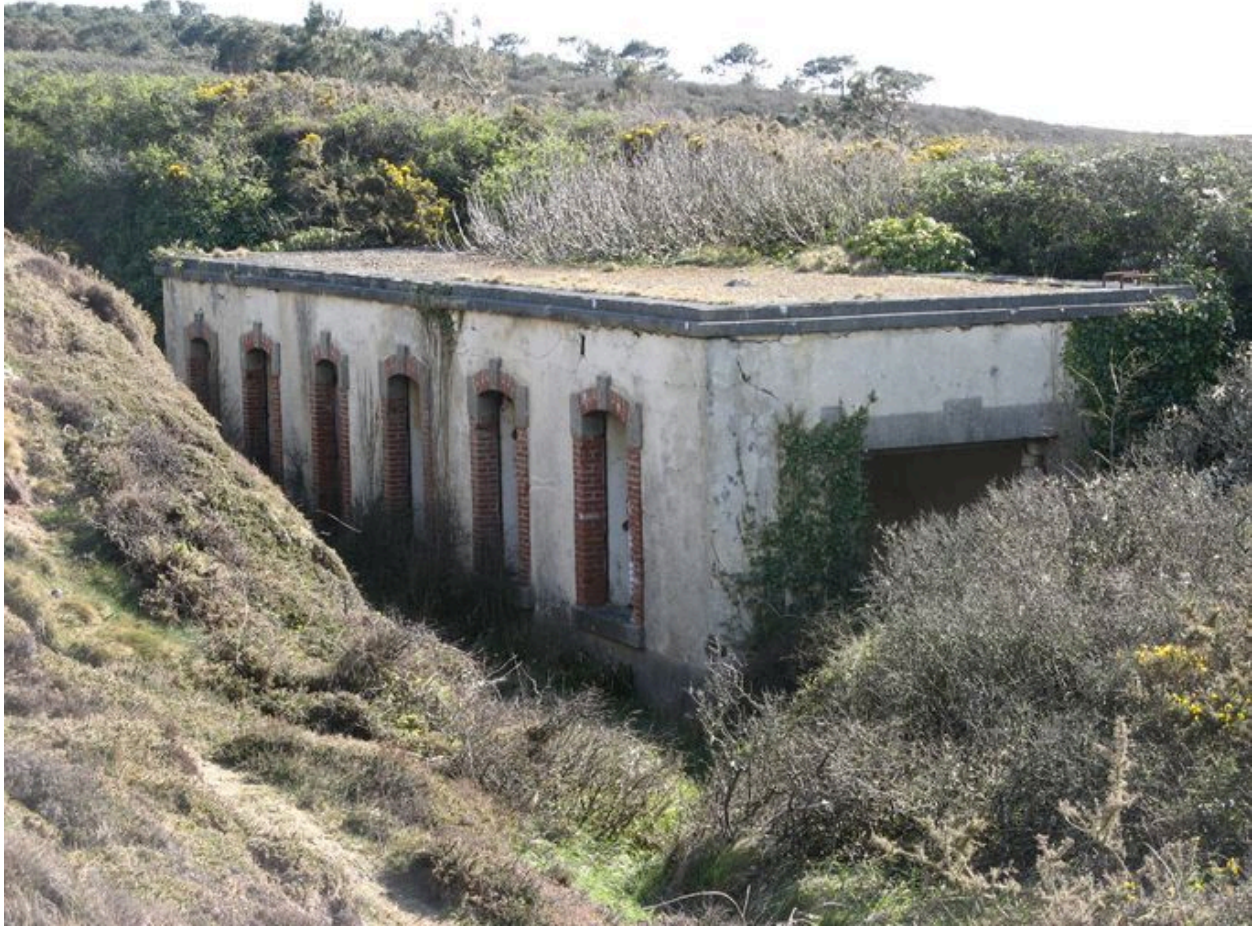
Usine électrique de la batterie de Kerviniou
