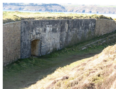
Route de service en tranchée avec magasin à munitions Phot. Guillaume Marie IVR53_20082908445NUCA
