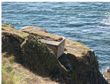
Abri du projecteur de la batterie de Kerviniou Phot. Guillaume Marie IVR53_20082908449NUCA
