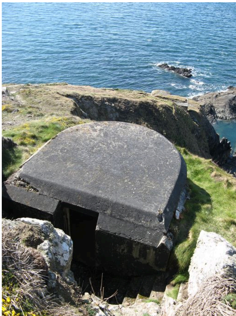
Poste de commande de projecteur et poste de télémétrie
