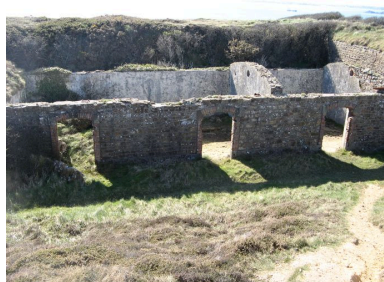
Magasin de la batterie de Kerviniou Phot. Guillaume Marie IVR53_20082908446NUCA
