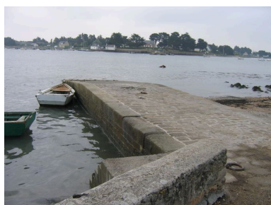
Vue générale de la cale du Passage Saint-Armel Phot. Françoise Péron IVR53_20075605721NUCA
