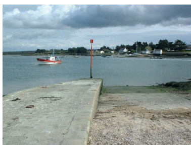
Cale du Passage Saint-Armel Phot. Julien Amghar IVR53_20085606104NUCA
