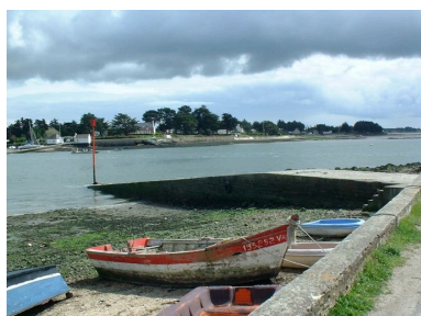
Cale du Passage Saint-Armel Phot. Julien Amghar IVR53_20065606574NUCA
