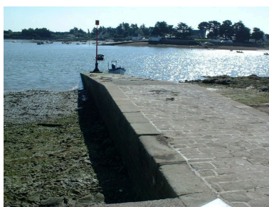
Cale du Passage Saint-Armel Phot. Julien Amghar IVR53_20085606102NUCA
