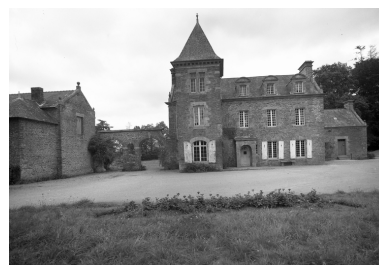
Vue générale sud. Phot. François Dagorn IVR53_19775601169V
