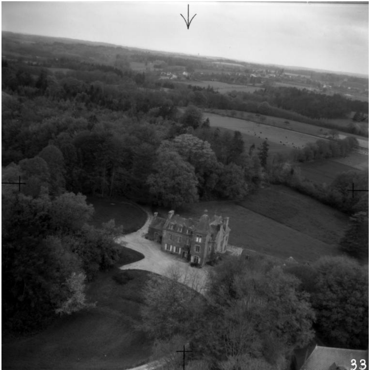
Vue aérienne prise du sud-est
