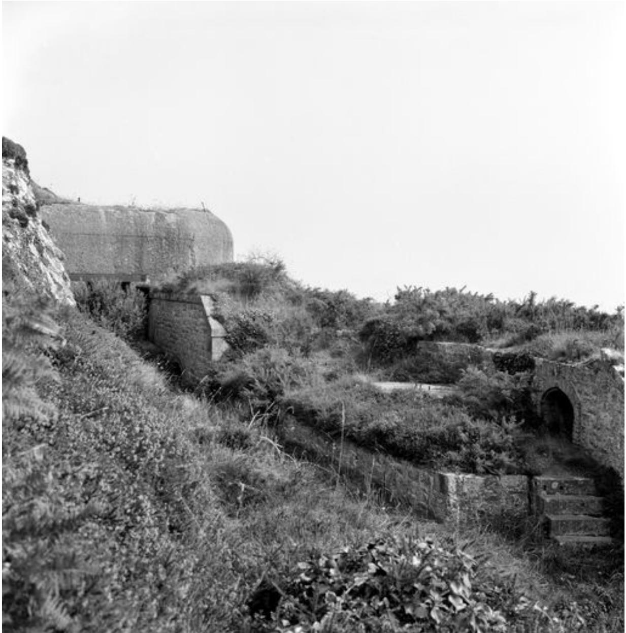
Vue de la batterie de côte du Petit Gouin en 1969. La batterie basse a été augmentée d'un bunker - casemate de type 671 coiffant le débouché du magasin à poudre sous roc
